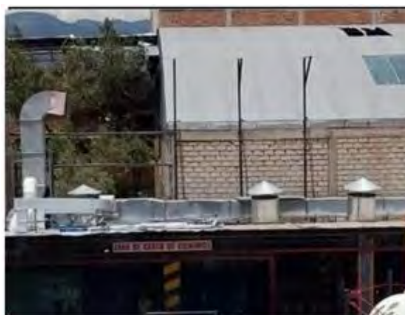
Fotografía 8 Inicio de prueba de instalación de gas
