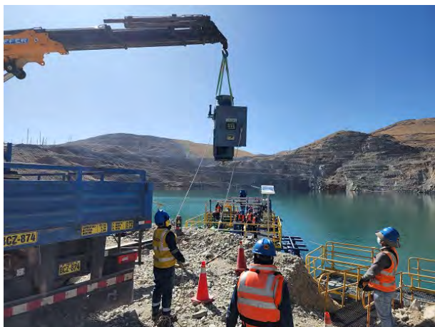
Instalación de motor eléctrico en la barcaza
