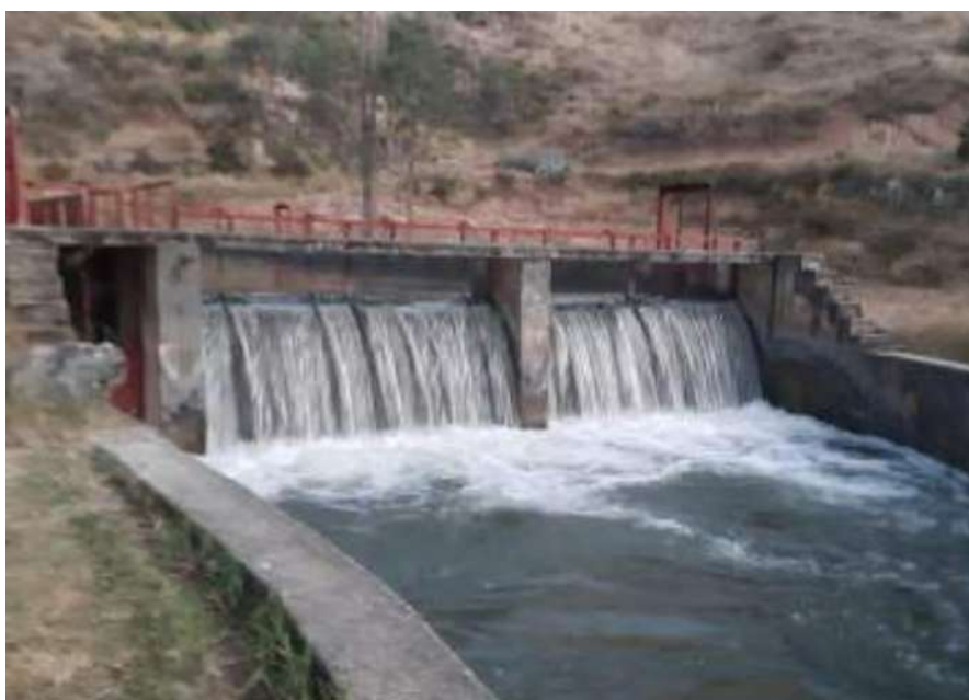
Bocatoma del río Huancaray
