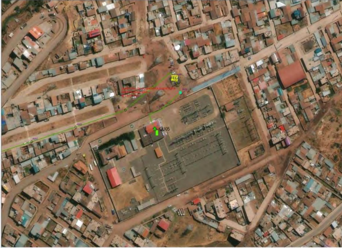
Figura 3. 1 Fotografía de planta de la subestación elevadora de Qencoro -San Jerónimo.
