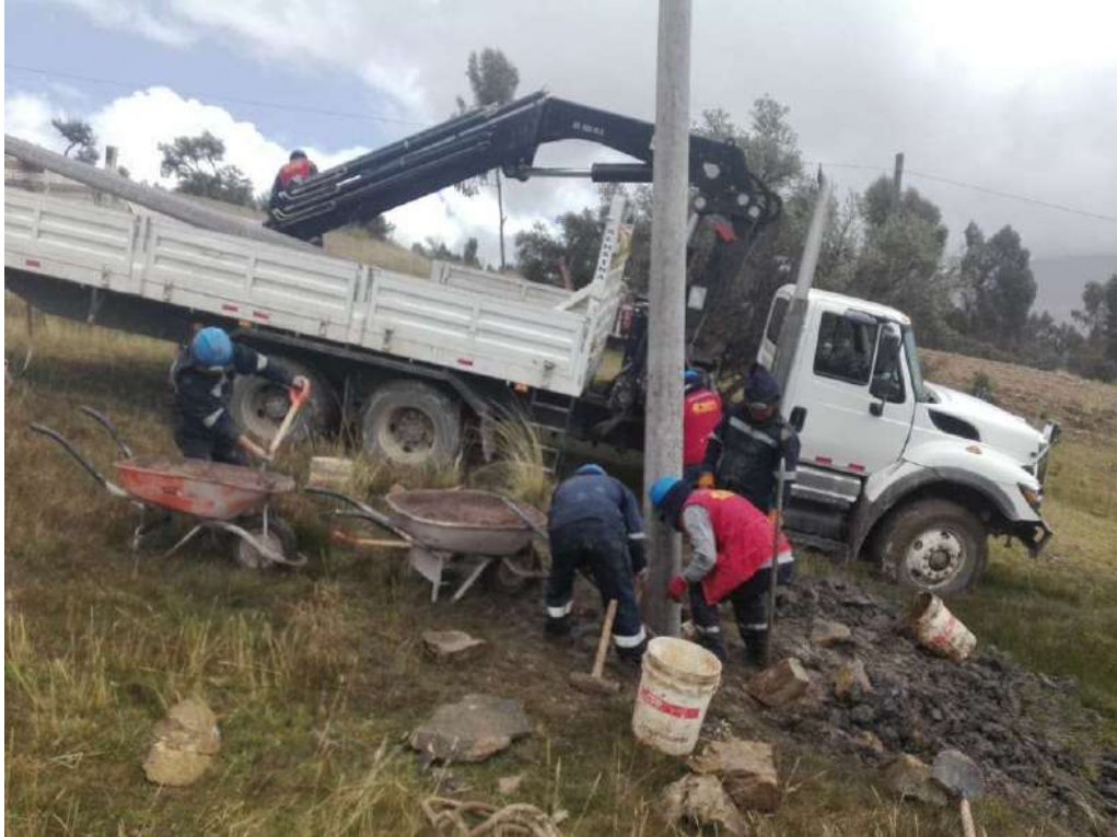
FOTOGRAFIA 5. Izaje de postes con grua
