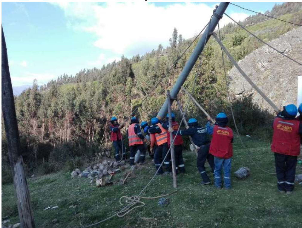
FOTOGRAFIA 4. Izaje de Postes a maniobra
