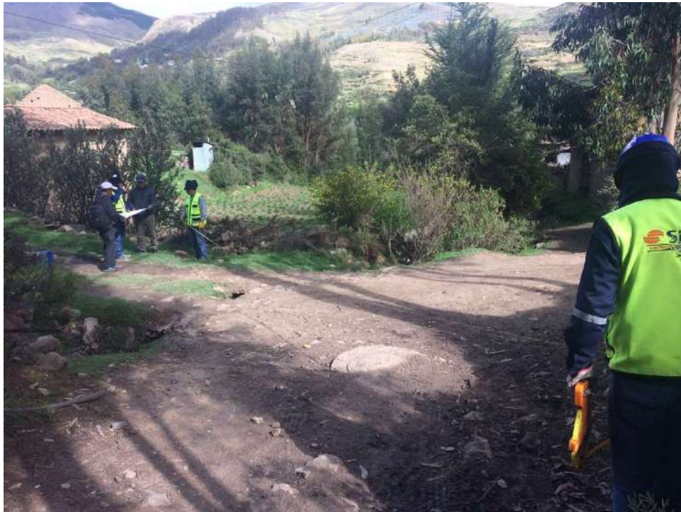
FOTOGRAFIA 2. Replanteo de obra sector Chacabamba
