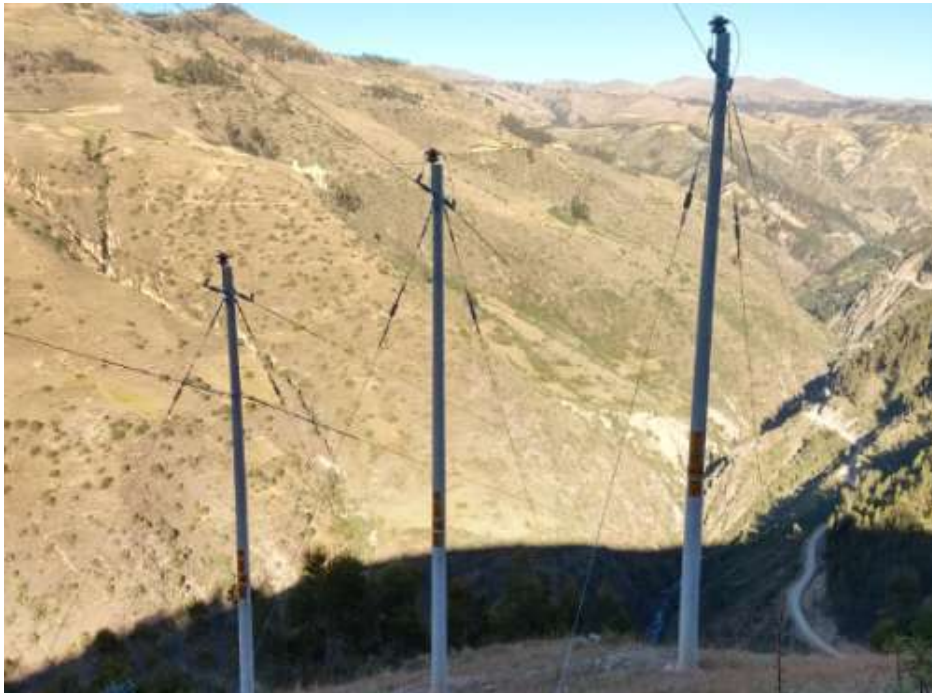
FOTOGRAFIA 15. Armado AT7 (Trio) Instalado en la LP Colquepata.
