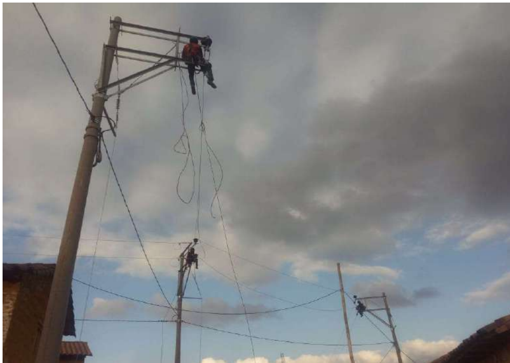
FOTOGRAFIA 6. Tendido de conductor AAAC
