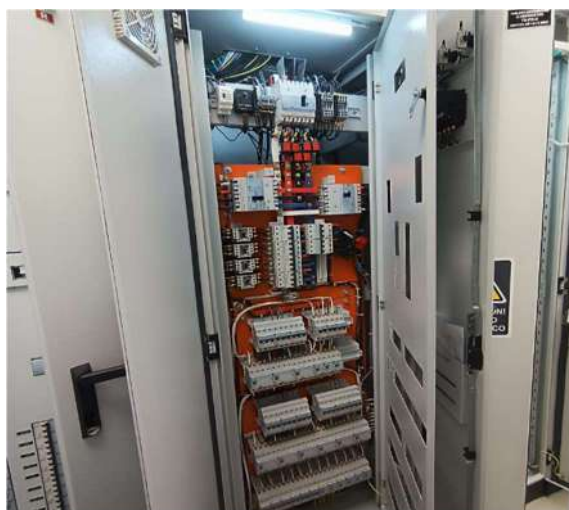
Figura 18 Montaje y Peinado de tableros generales
