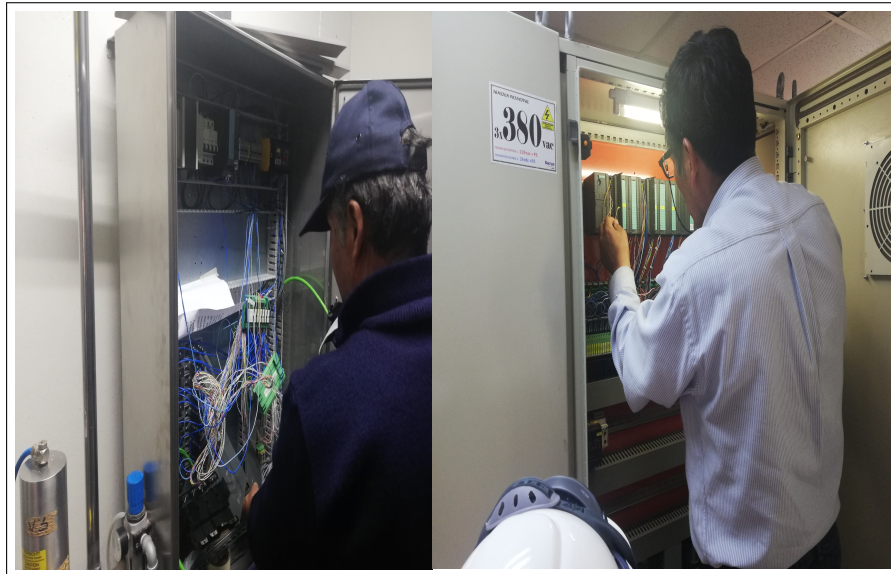
Figura 5.3: Cambio de direcciones de entradas y salidas de módulos de los distintos tableros
