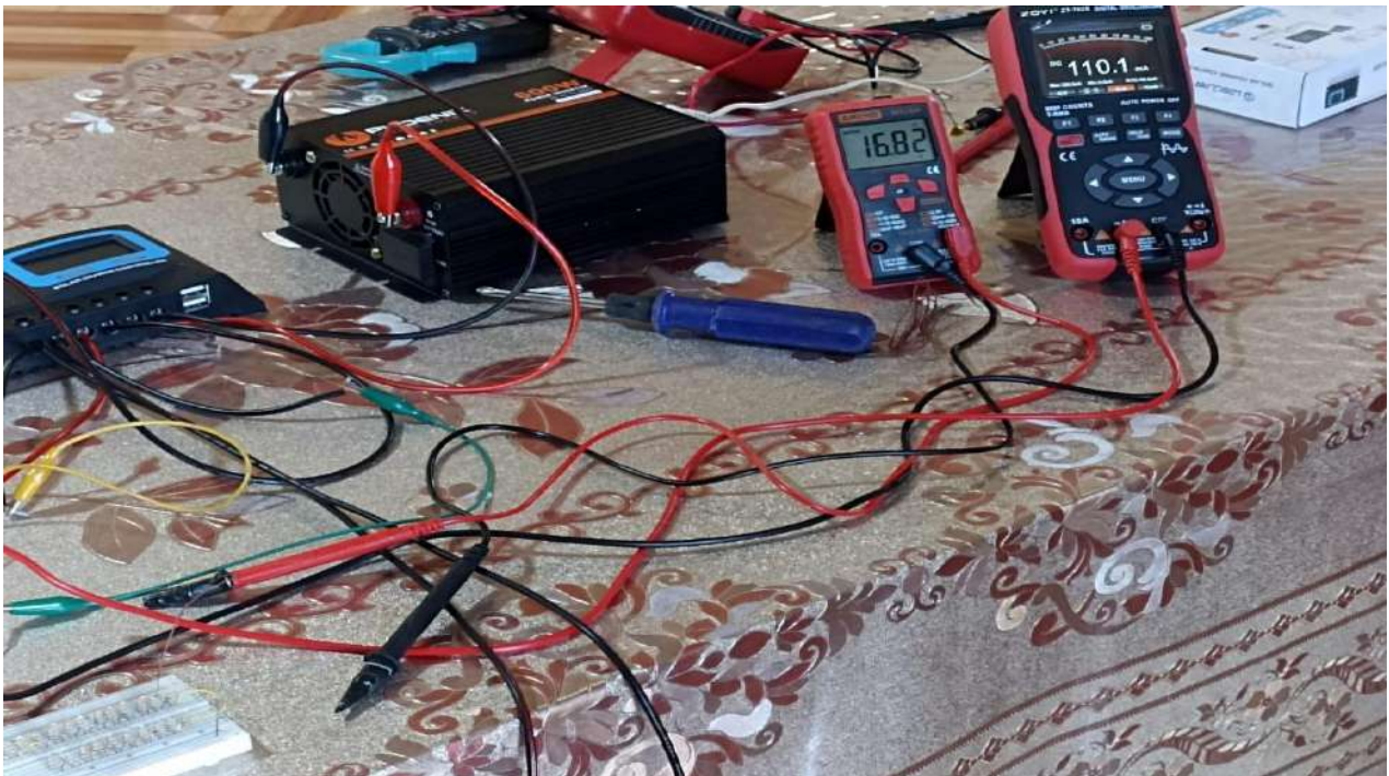
Figura 109 Voltaje DC de entrada al SPCM prueba experimental.
