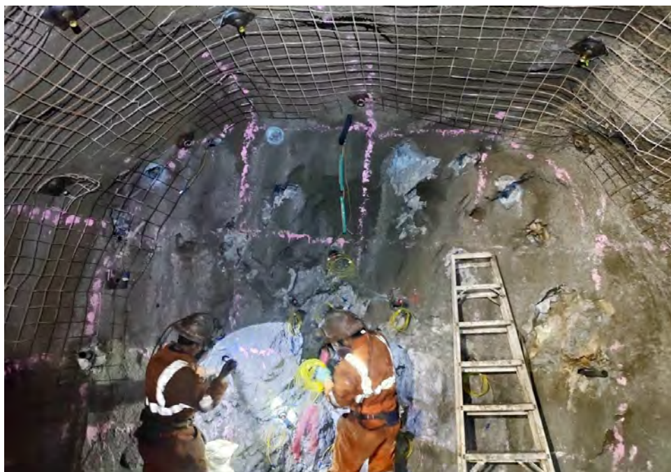
Figura 33. Carguío de accesorios y explosivos en el frente.
