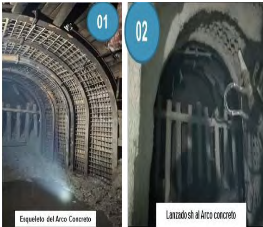
Figura 21. Sostenimiento con cimbras.
