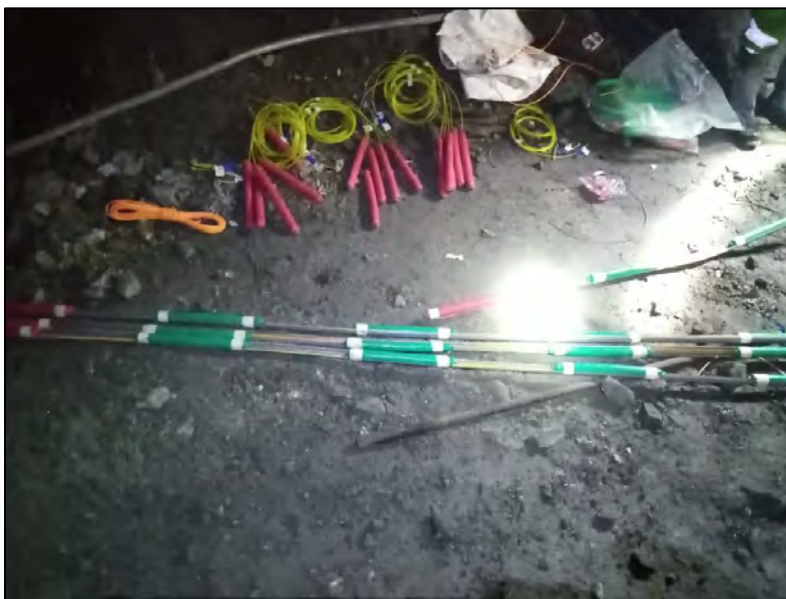
Figura 32. Accesorios y explosivos para el frente.
