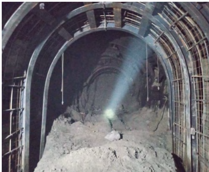
Figura 36. Resultados de la voladura controlada.
