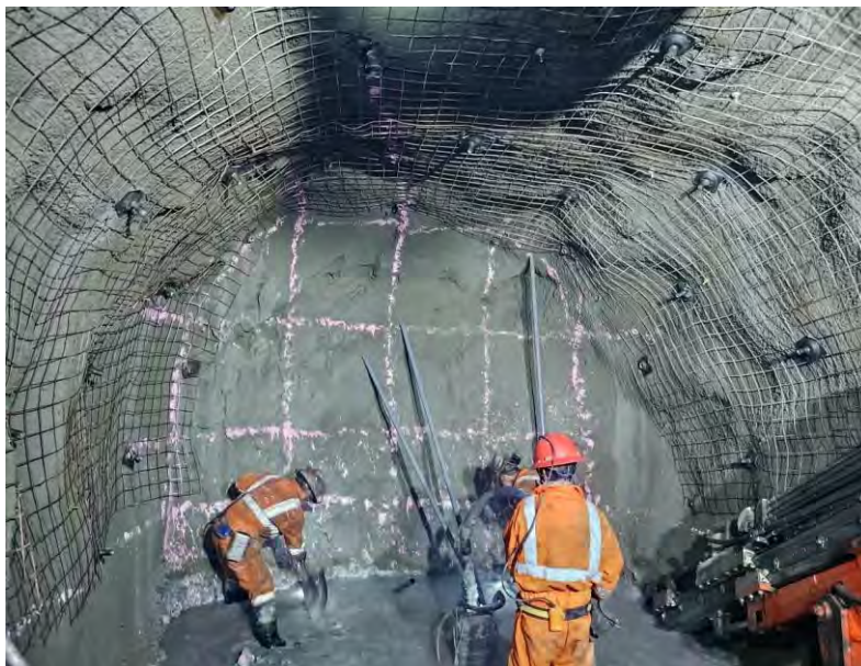
Figura 31. Perforación del frente.
