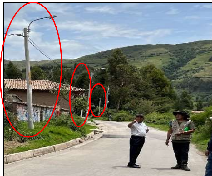
Foto 49: Registro de infraestructura eléctrica en zona de inundación.
