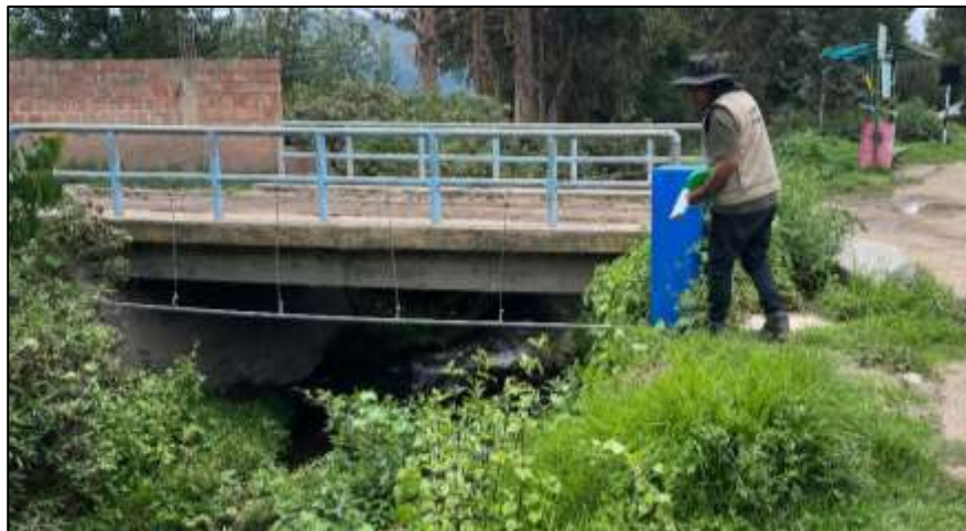
Foto 28: Geometría del Puente 06 coordenadas Este: 803251 Norte: 8505955.
