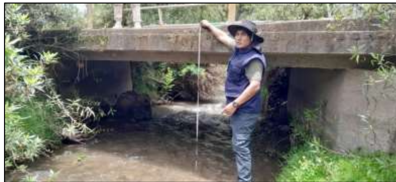
Foto 24: Geometría del Puente 01 coordenadas Este: 803464 Norte: 8504131
