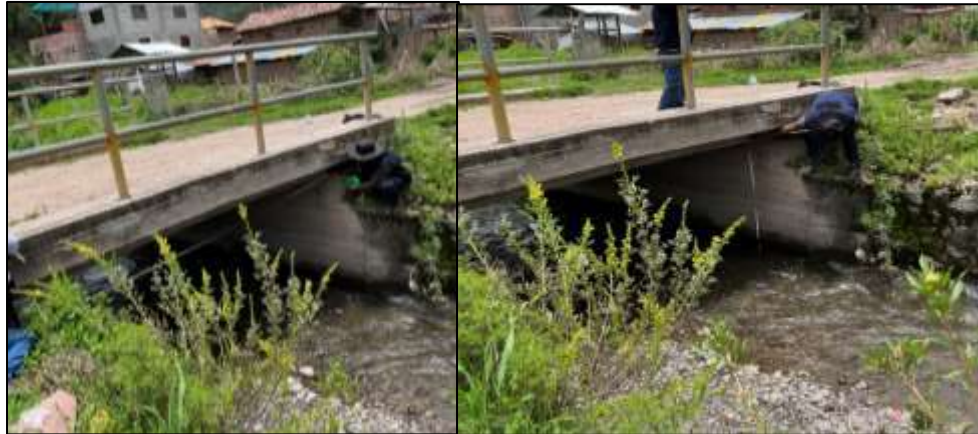
Foto 25-26: Geometría del Puente 02 coordenadas Este: 803332 Norte: 8504314.
