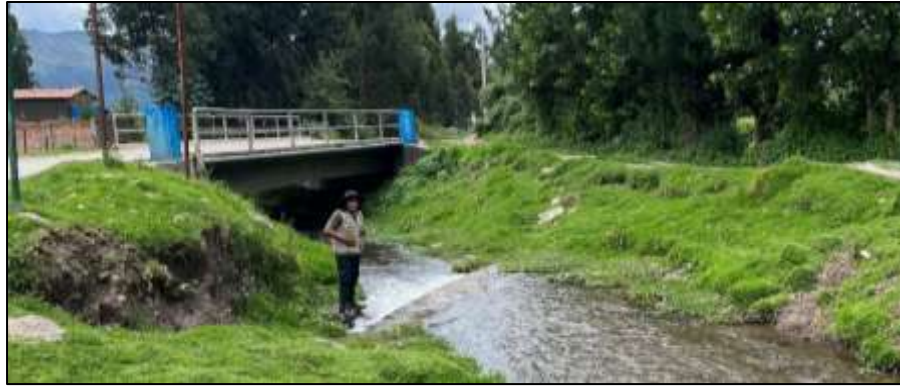
Foto 27: Geometría del Puente 03 coordenadas Este: 803210 Norte: 8504721.
