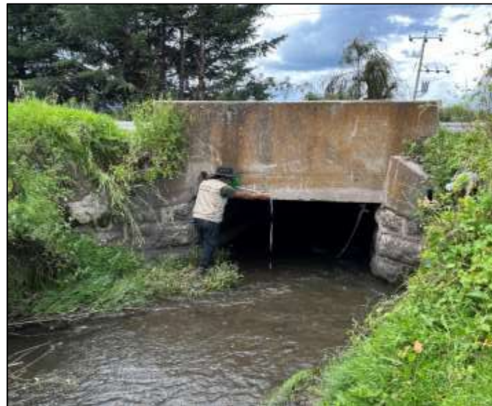
Foto 29: Geometría del Puente 07 coordenadas Este: 803253 Norte: 8505992.
