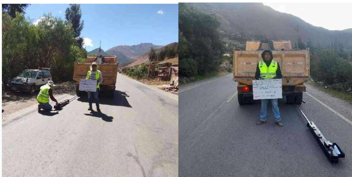
Imagen 3: Ensayo de deflexión con Viga Benkelman en la vía Huacarpay - Vicho
