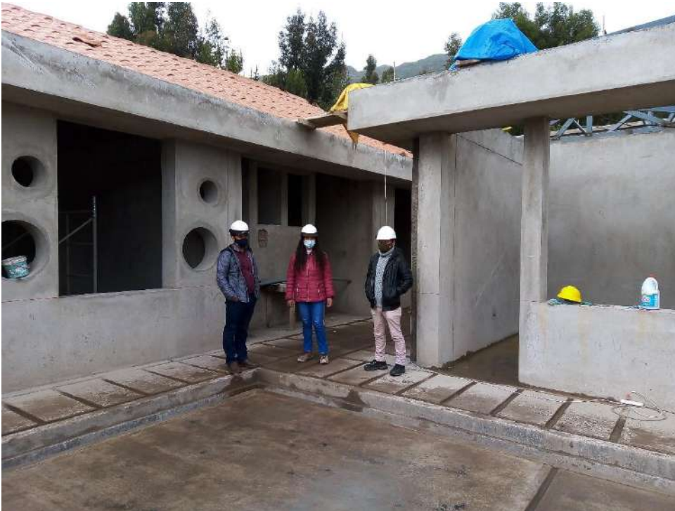
Figura 90 Verificación de calidad de acabados.
