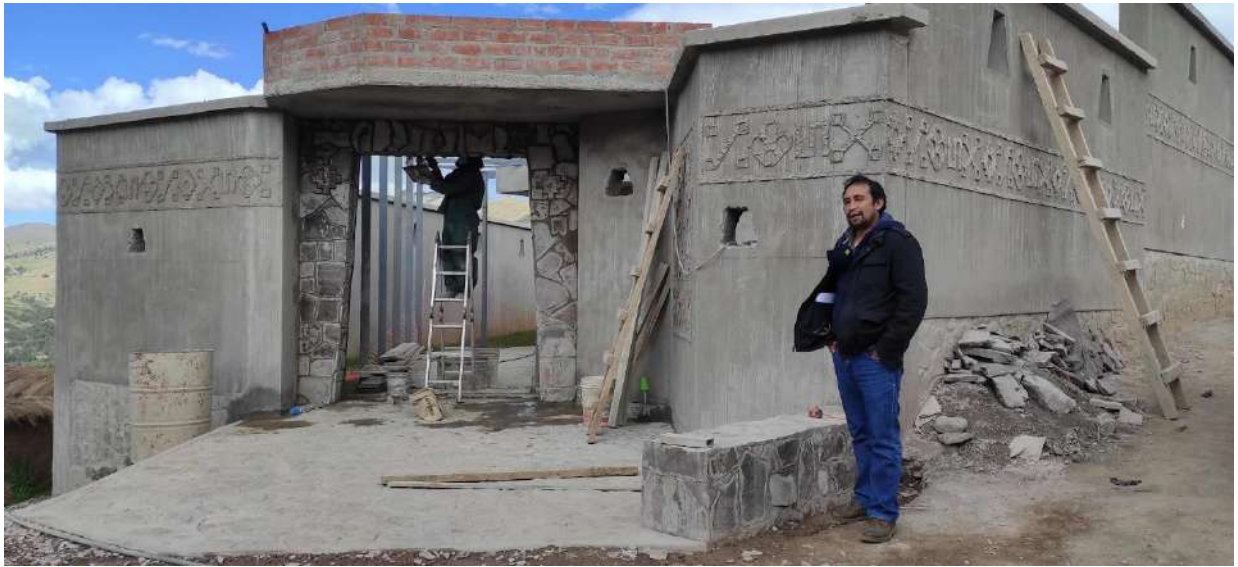
Figura 99 Verificación de tarrajeo exterior y mampostería.
