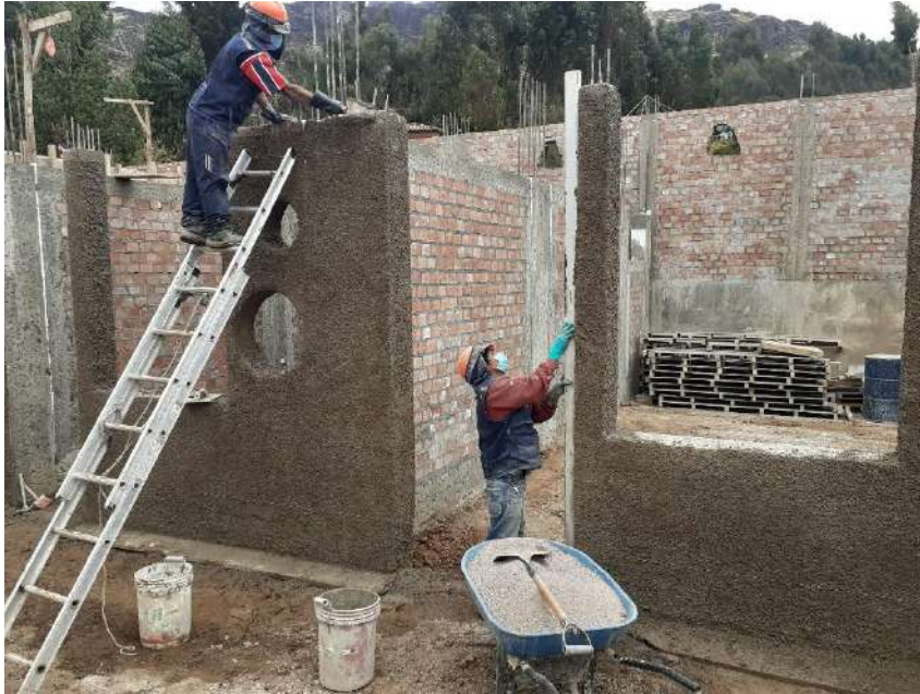
Figura 81 Trabajo de tarrajeo primario.
