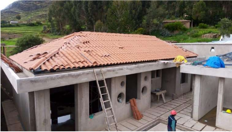
Figura 89 Acabados de tarrajeo final.
