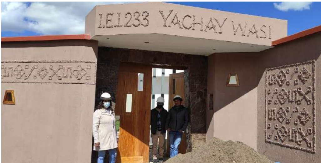
Figura 92 Verificación de tarrajeo exterior y carpintería.
