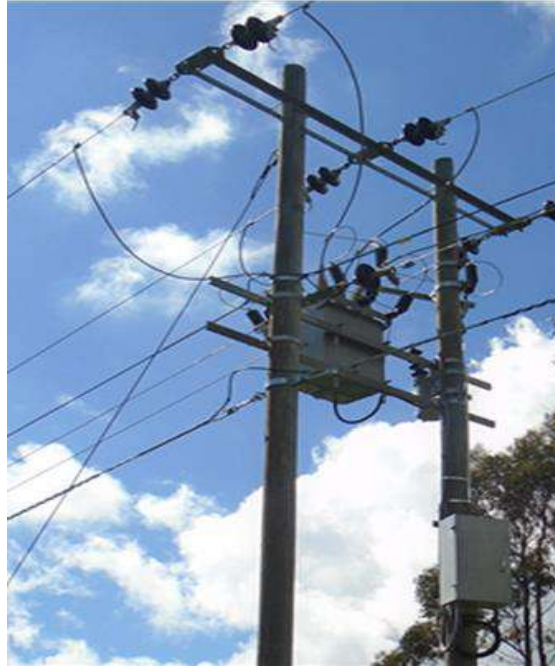
Figura 23: Interruptor automático del alimentador de CA-01
