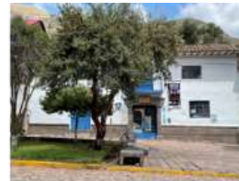
Municipalidad Distrital de Andahuaylillas Fuente: Propia (2021)
