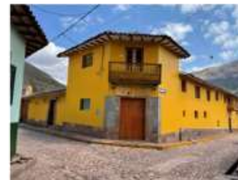
Cafetería “La Sixtine”/Centro de Eventos y Hotel “Casa del Sol” ubicado en la esquina de la plaza del centro poblado. Fuente: Propia (2021)
