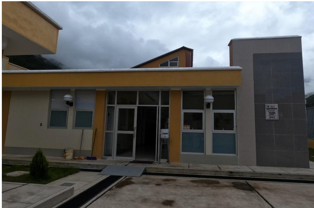
Fotografía 2. Infraestructura del puesto de salud. Unidad de administración y consulta externa
