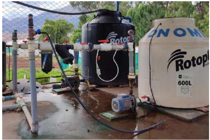
Foto N° 13. Inyector Venturi
