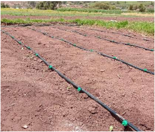
Foto N° 12. Instalación del sistema del riego por goteo
