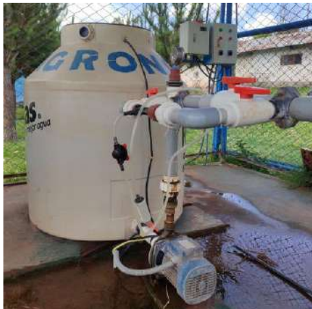
Foto N° 12. Instalación del sistema del riego por goteo
