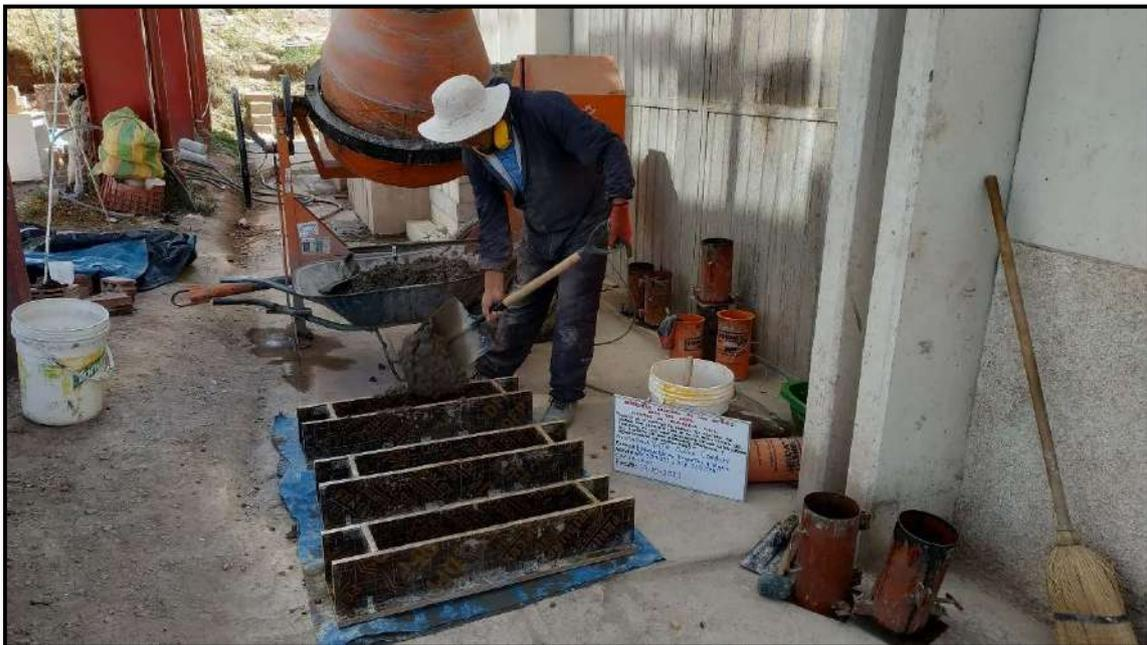
Fotografía 63: Elaboración de vigas de concreto por sustitución parcial del cemento con 15% de cenizas de aserrín.
