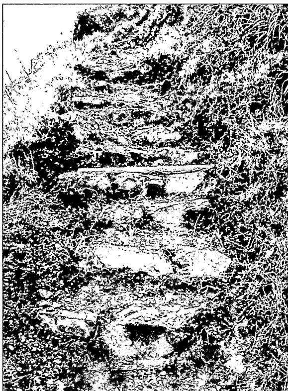
*Fig. 83. Camino con escalinatas, hechas con bloques y lajas planas (escala 1m.).*
