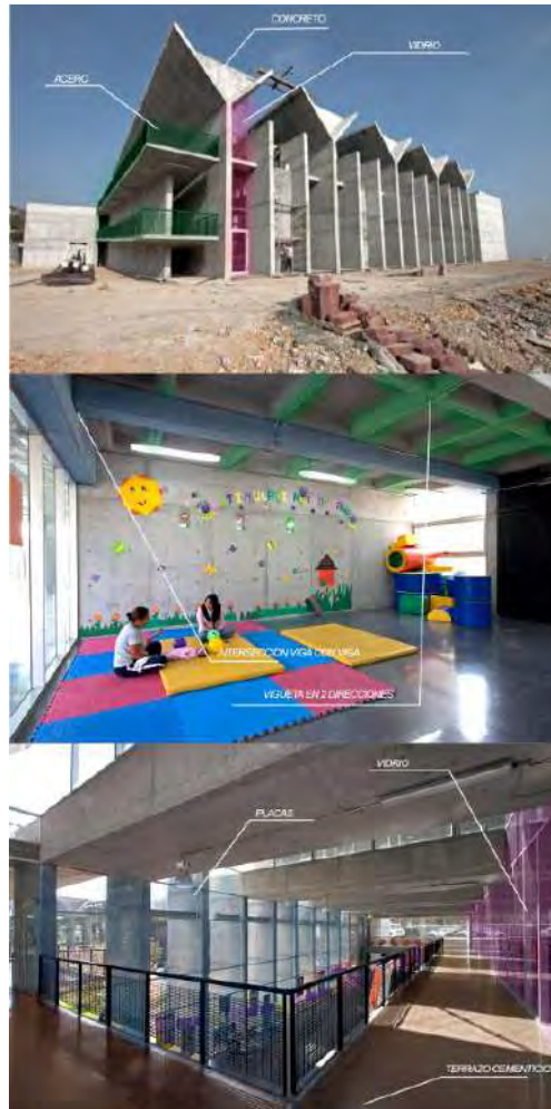
Figura 21. Vista exterior e interior - Centro Comunitario Independencia
