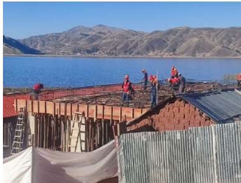
Actividades realizadas de encofrado de losa y colocados de acero en losa.
