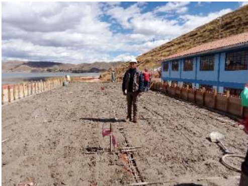
Actividades realizadas de vaciado de concreto en losa, vigas y canaleta.
