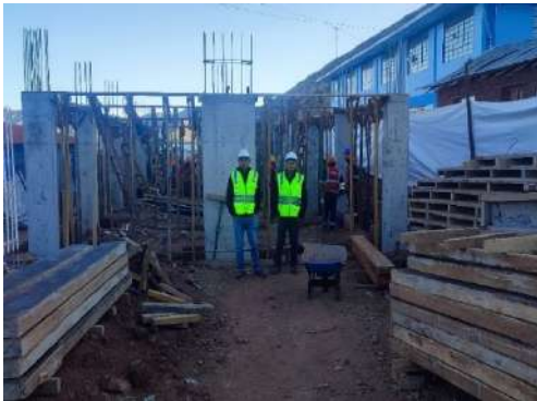
Actividades realizadas de colocados de pies derecho en vigas.
