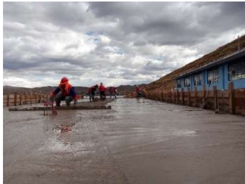
Actividades realizadas de regleo e losa y canaleta.
