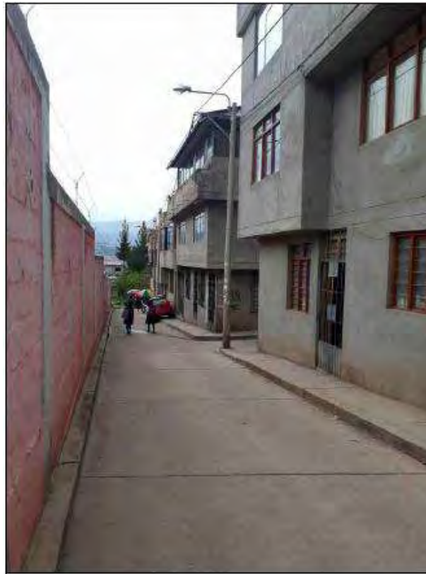
Figura 11: Vista exterior, previa ejecución.
