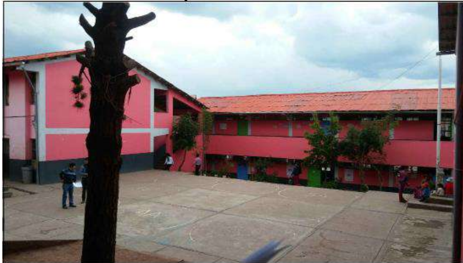
Figura 10: Vista interior del patio, previa ejecución.
