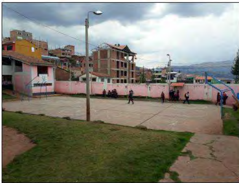
Figura 9: Vista de la losa deportiva existente, ingreso principal del nivel secundaria, previa ejecución.
