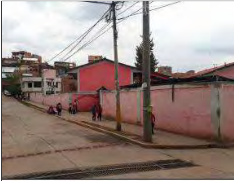
Figura 8: Vista del ingreso principal del nivel inicial y primaria, desde la Calle José Carlos Mariátegui, previa ejecución.
