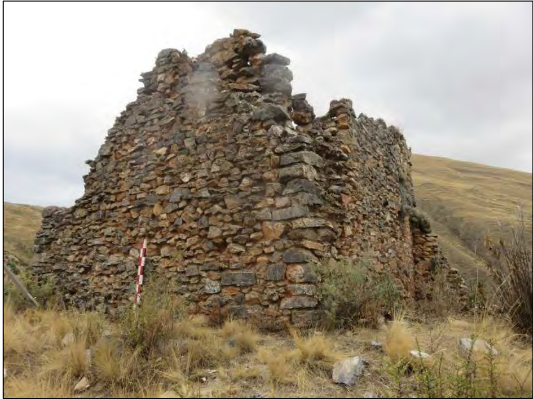
VISTA DEL RECINTO N° 04 LADO EXTERIOR, SE PUEDE APRECIAR LA UNION EL CUAL FORMA UN ANGULO RECTO.
