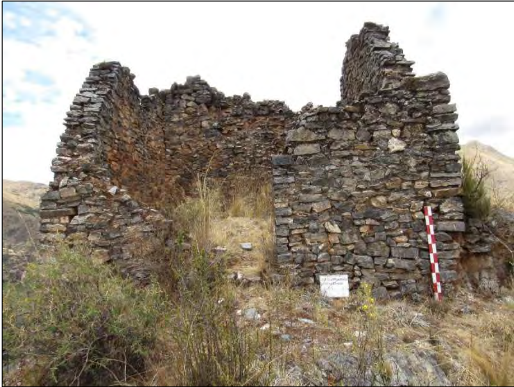
VISTA DEL RECINTO N° 04 LADO EXTERIOR, UBICADO EN EL SECTOR "A".
