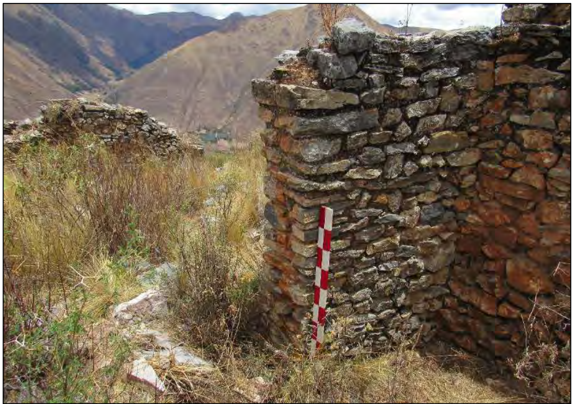
VISTA DEL RECINTO N° 02 LADO INTERIOR, UBICADO EN EL SECTOR "A".
