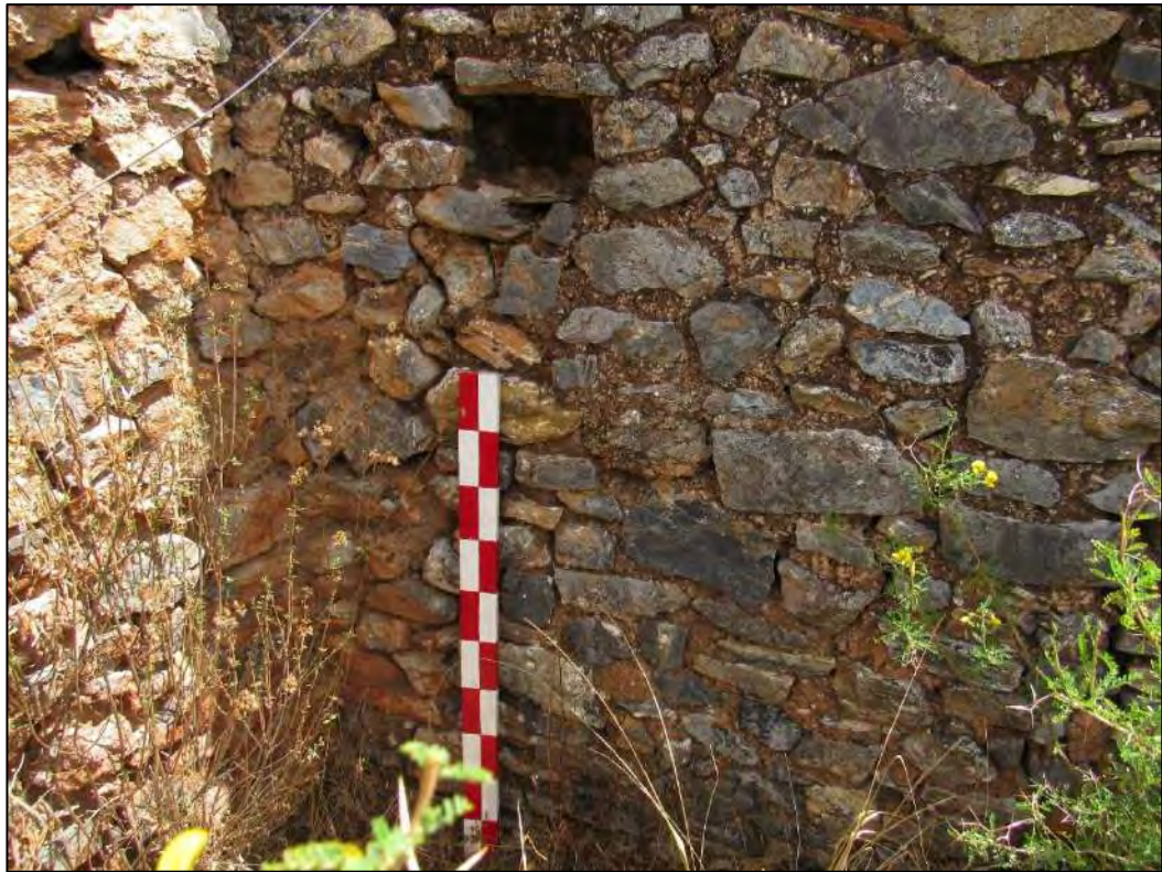
VISTA DEL NICHU UBICADO AL INTERIOR DEL RECINTO.
