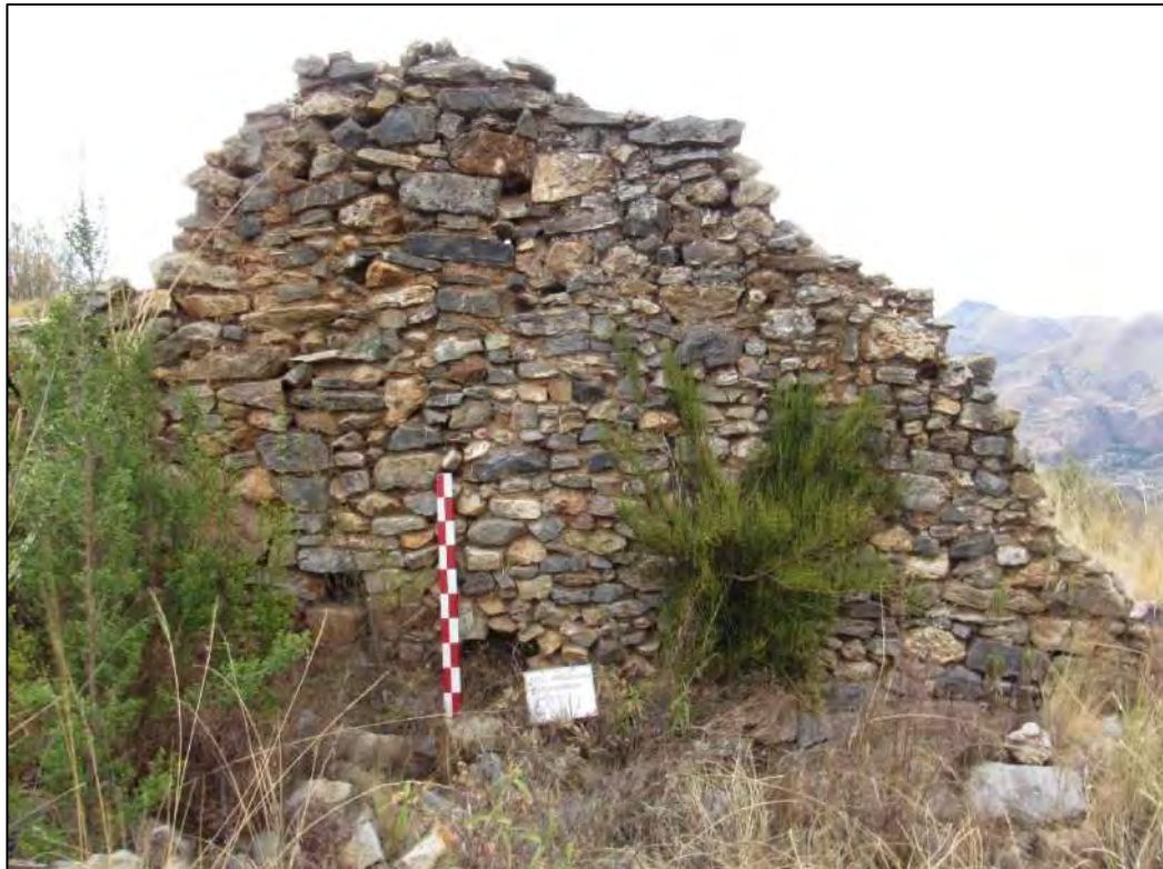
VISTA DEL RECINTO 15, LADO INTERIOR UBICADO EN EL SECTOR B
