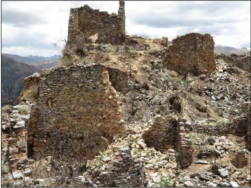
VISTA LADO EXTERIOR DEL RECINTO N° 10 Y DE LA ESTRUCTURA PEQUEÑA 02.
