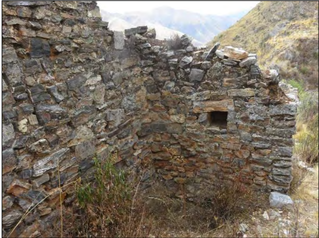
VISTA A DETALLE DE LA UNION INTERNA DE LOS MUROS QUE FORMAN UN ANGULO OVALADO
