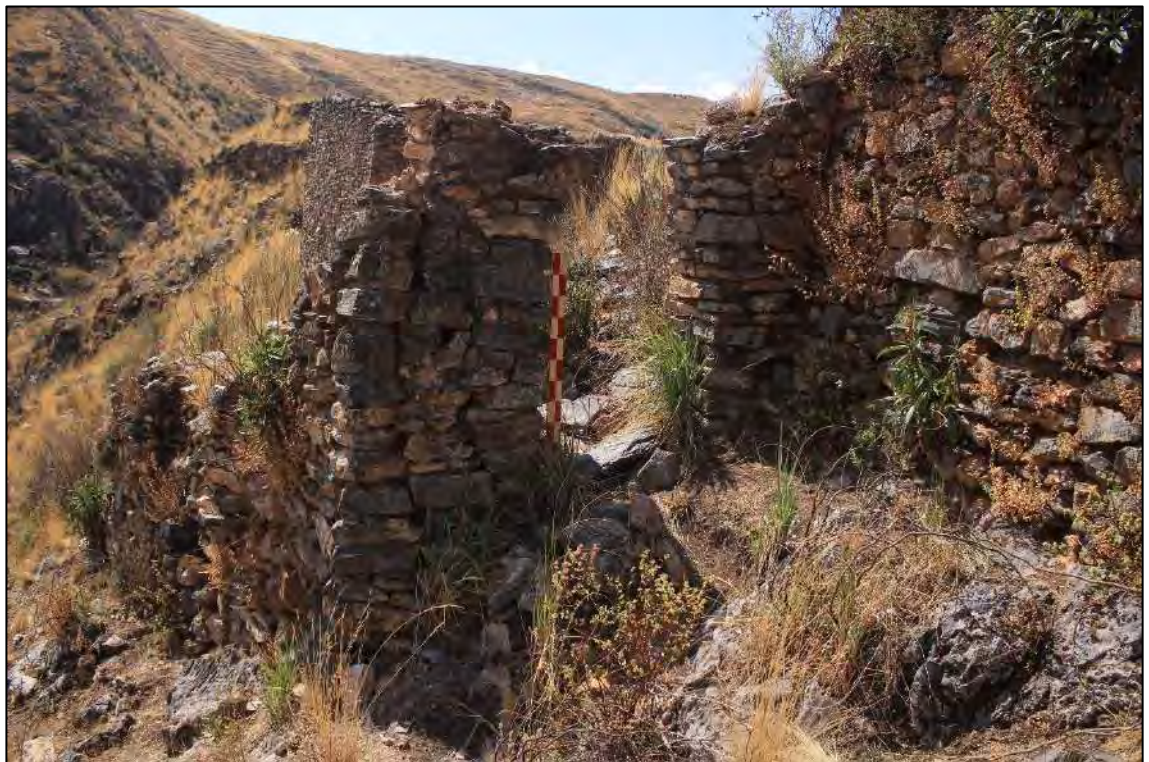
VISTA EXTERIOR DE LA MURALLA SUR, DONDE SE EVIDENCIA EL VANO DEL ACCESO PRINCIPAL.
