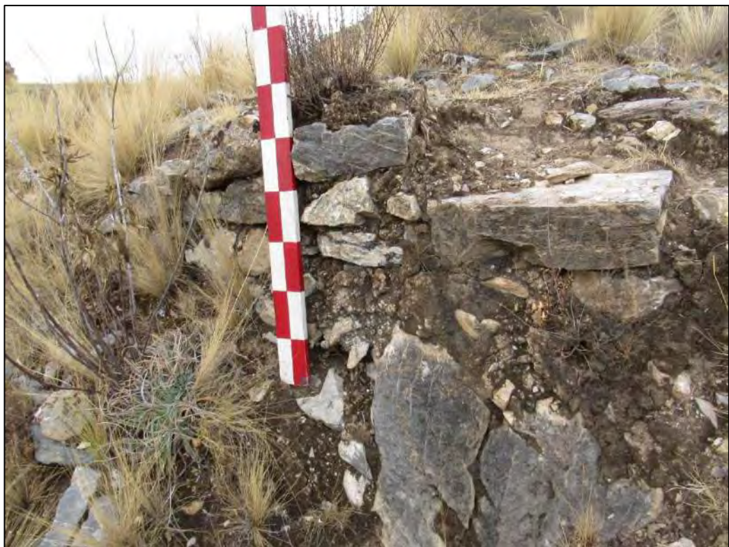
VISTA DEL RECINTO 13, SE EVIDENCIA LA CIMENTACIÓN DEL RECINTO QUE TAMBIÉN CUMPLE LA FUNCIÓN DE MURO CONTENCIÓN.
