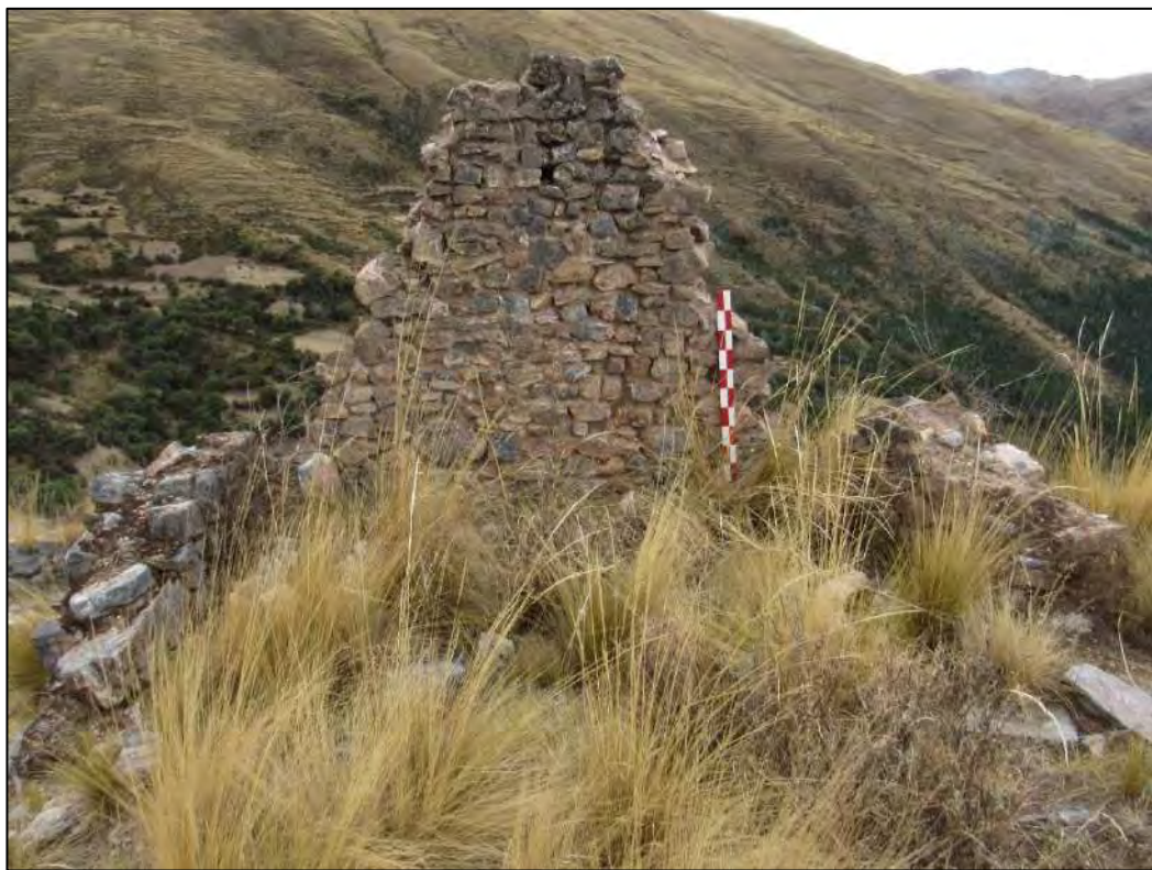
VISTA INTERIOR DEL RECINTO 14,
