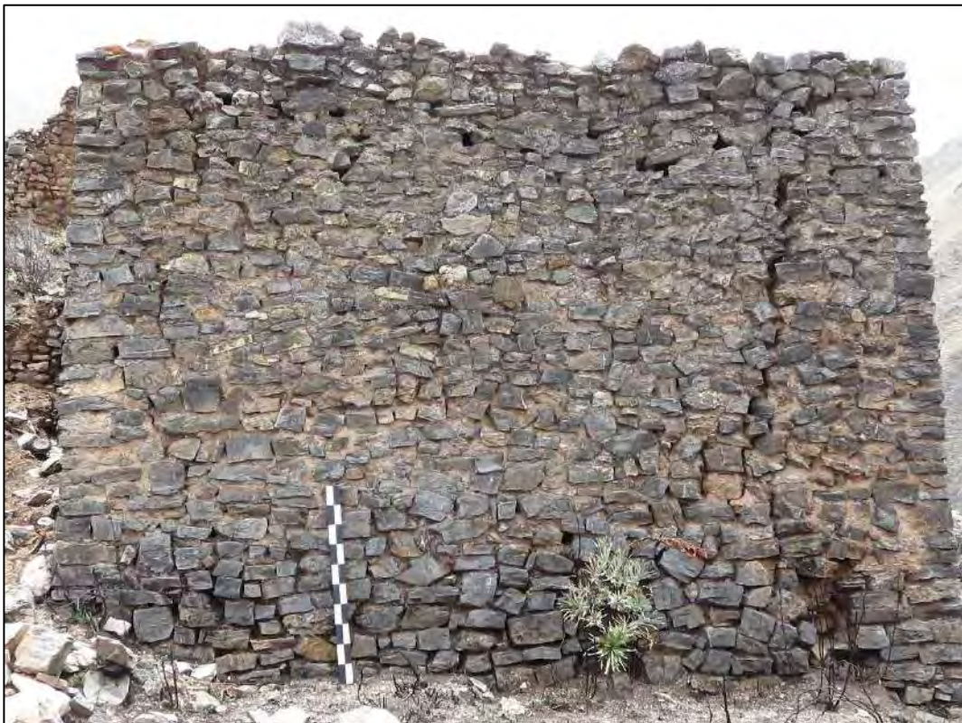
VISTA DEL RECINTO N° 10 LADO EXTERIOR, UBICADO EN EL SECTOR "A".
