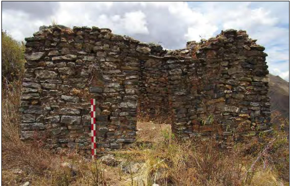
VISTA DEL RECINTO N° 03 LADO EXTERIOR, UBICADO EN EL SECTOR "A".
