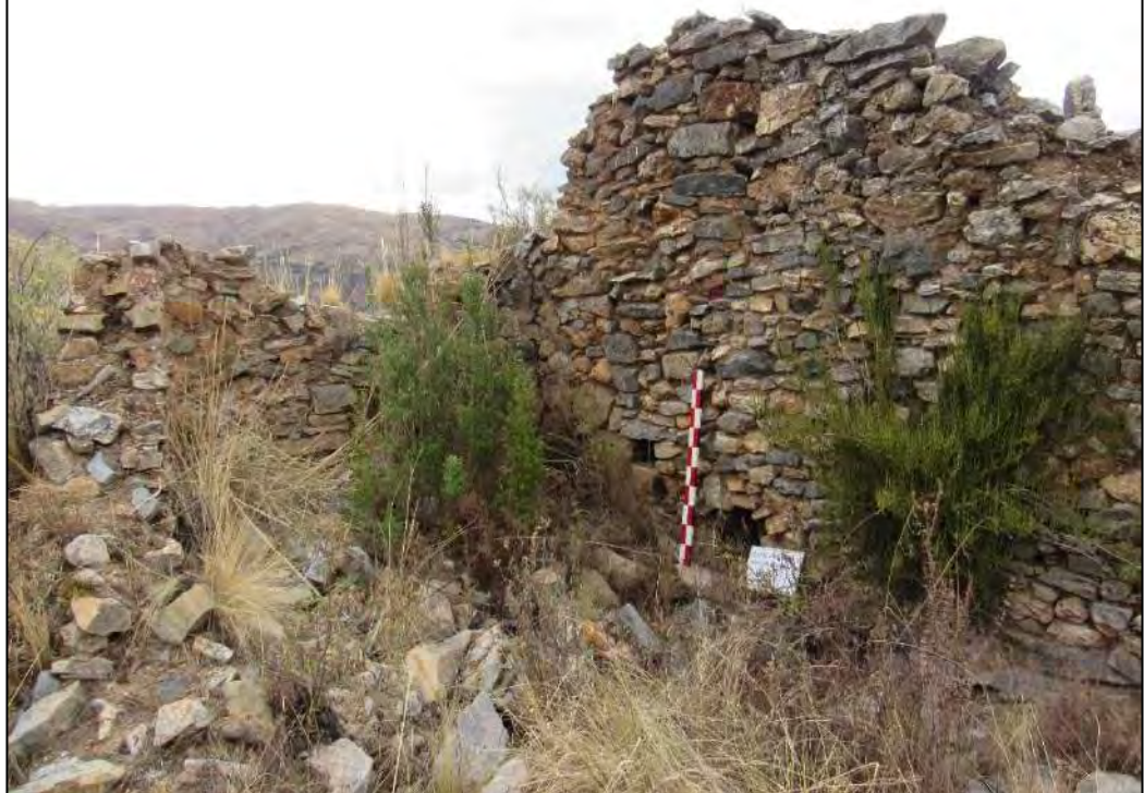
VISTA DEL RECINTO 15, DONDE SE APRECIA EL MAL ESTADO DE CONSERVACIÓN
