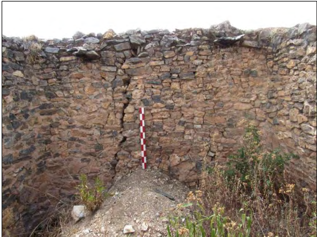
VISTA DEL INTERIOR DEL RECINTO NOTESE LAS LAJAS UBICADOS EN LA PARTE SUPERIOR DEL MURO.
