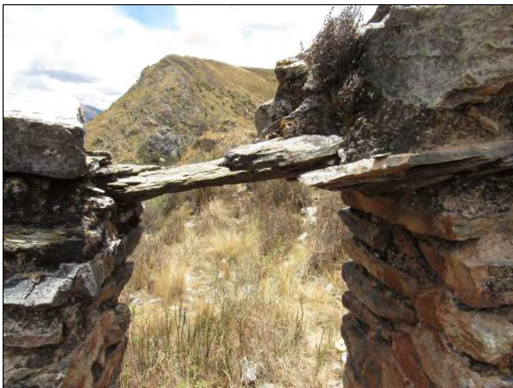
VISTA A DETALLE DEL DINTEL DEL RECINTO N° 03, CONSTITUIDO POR LAJAS.
