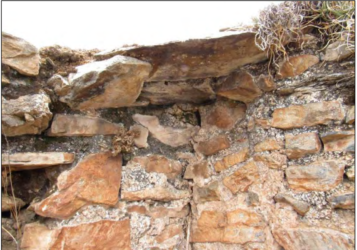
VISTA A DETALLE DE LAS LAJAS UBICADOS EN LA PARTE SUPERIOR DEL RECINTO.
