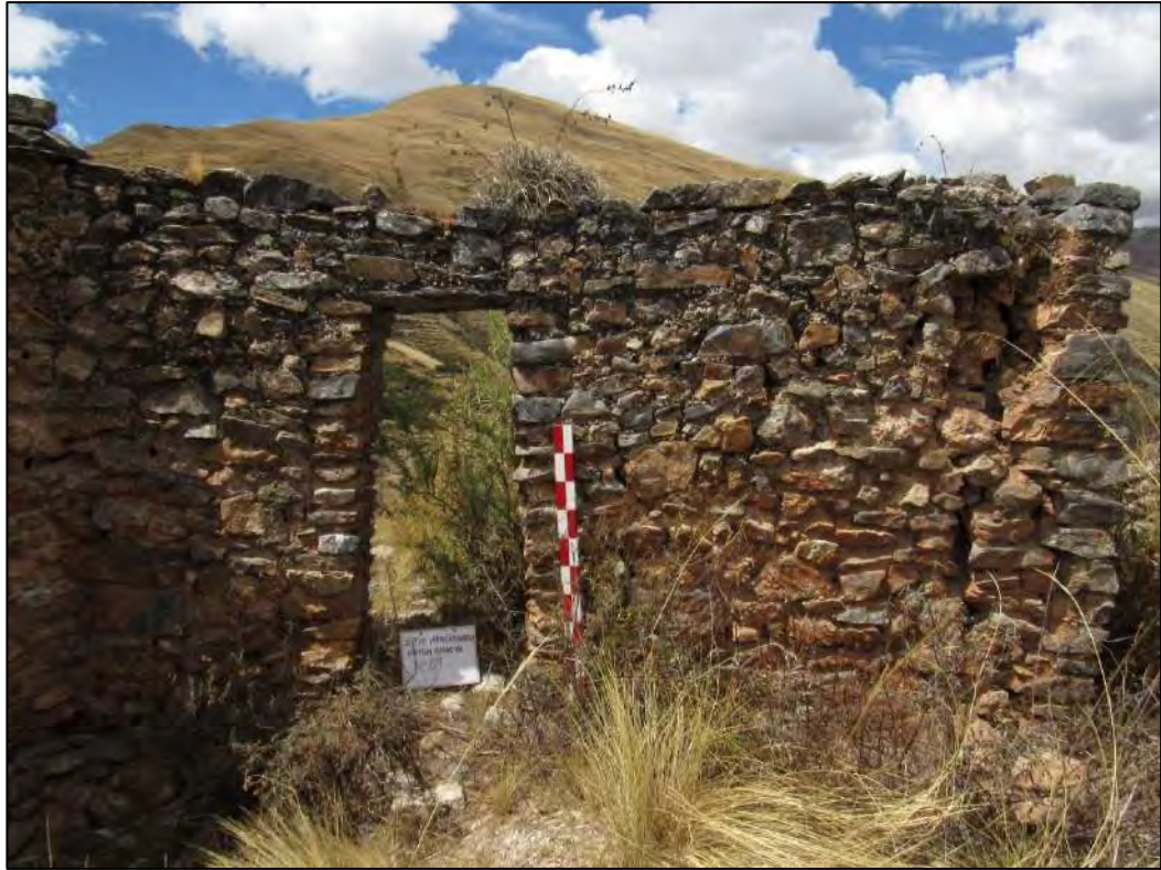
VISTA DEL RECINTO N° 09 LADO EXTERIOR, UBICADO EN EL SECTOR "A".
