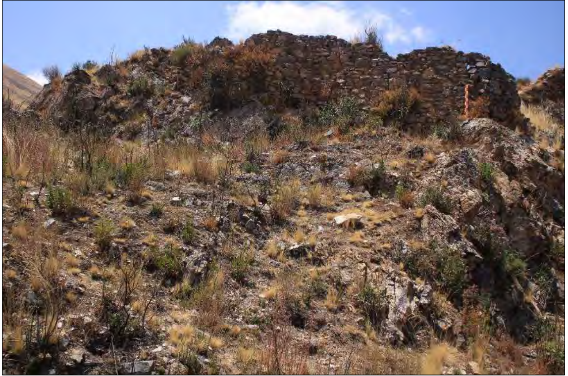
VISTA EXTERIOR DE LA MURALLA NORTE
