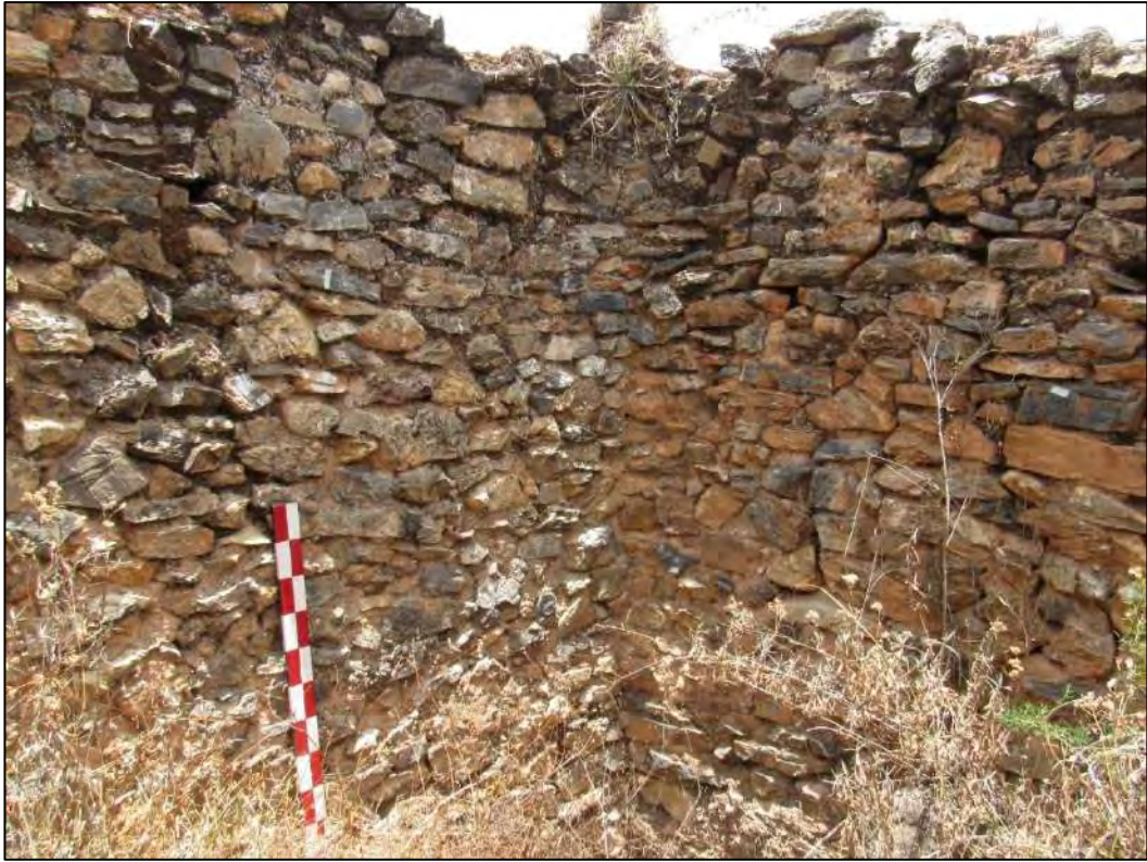
VISTA A DETALLE DE LA UNION INTERNA QUE FORMAN UN ANGULO OVALADO
