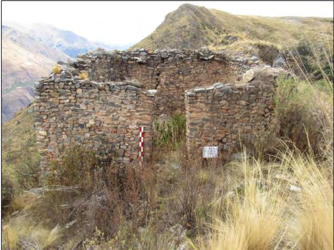
VISTA DEL RECINTO N° 11 LADO EXTERIOR, UBICADO EN EL SECTOR "A".
