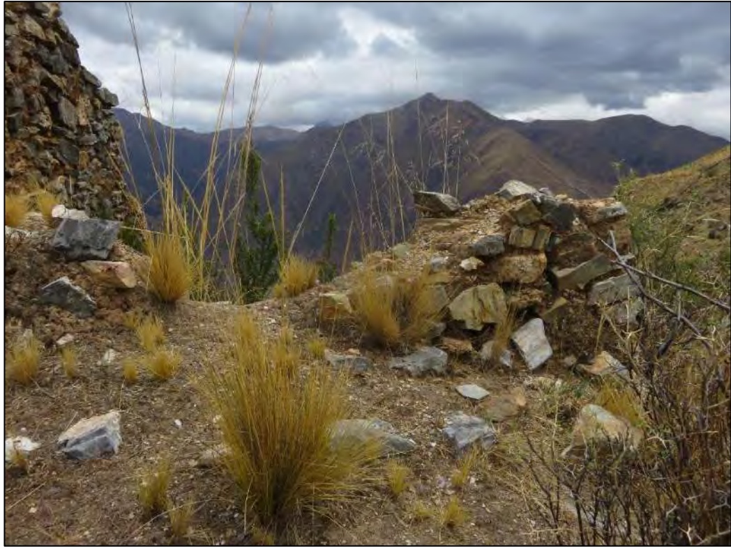
VISTA DEL RECINTO 15, DONDE SE APRECIA EL MAL ESTADO DE CONSERVACIÓN
