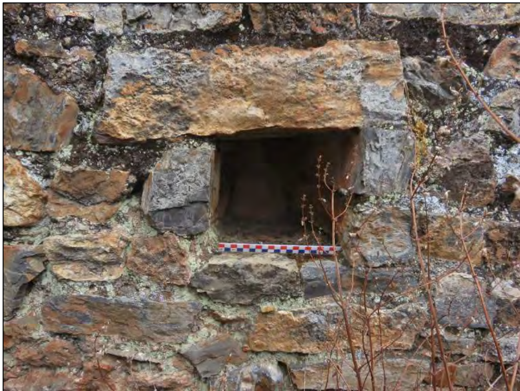
VISTA A DETALLE DEL NICHOS DEL RECINTO N° 04.
