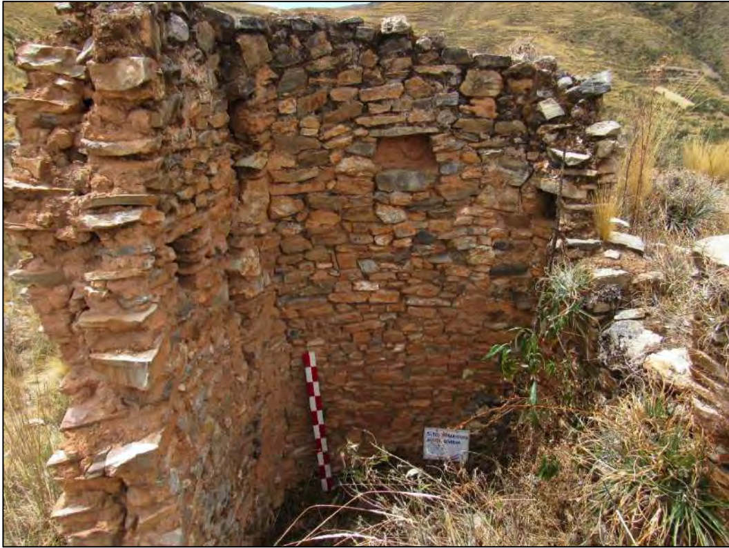
VISTA DEL RECINTO N° 07 LADO INTERIOR, UBICADO EN EL SECTOR "A".
