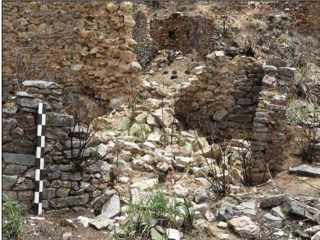
VISTA LADO EXTERIOR DEL RECINTO N° 10, DONDE POSIBLEMENTE SE UBICARIA EL VANO DE ACCESO.
