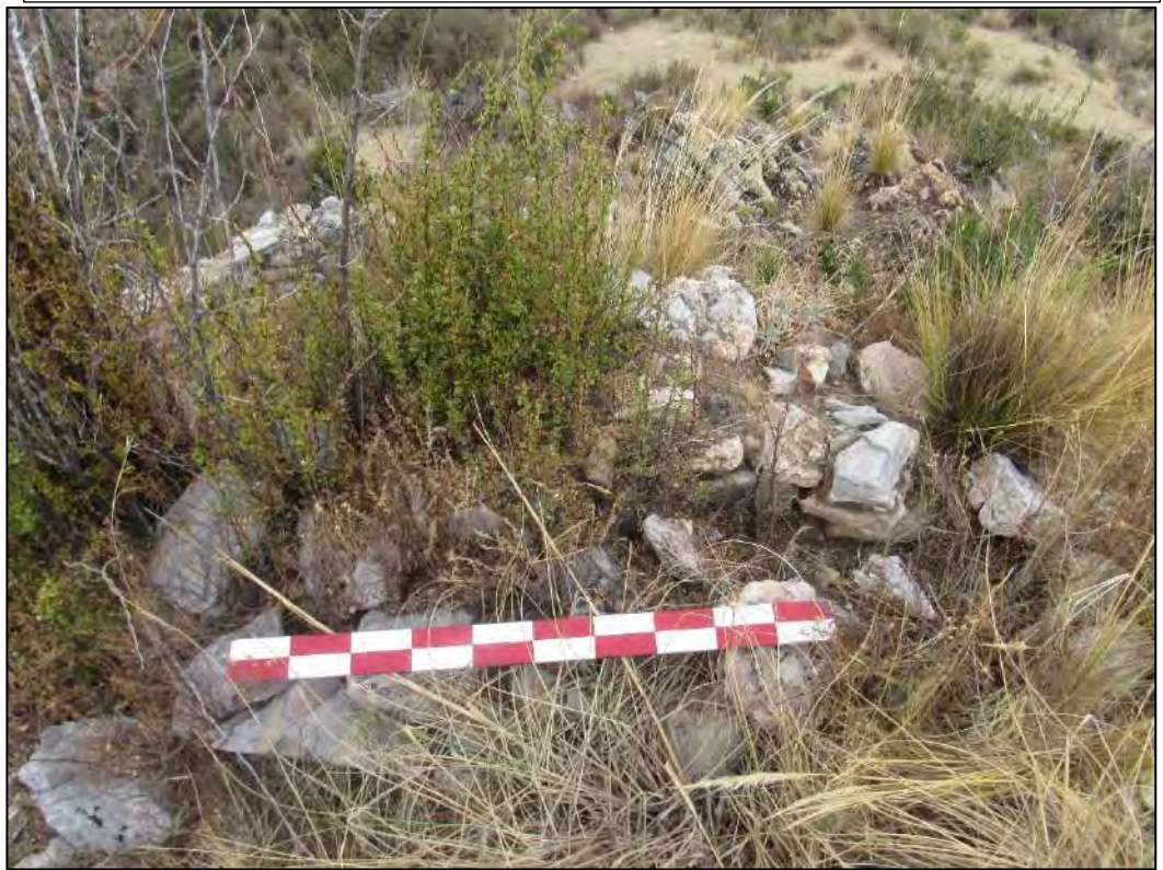
VISTA DE LA PARTE INTERNA DEL RECINTO 18, NÓTESE EL MAL ESTADO DE CONSERVACIÓN.
