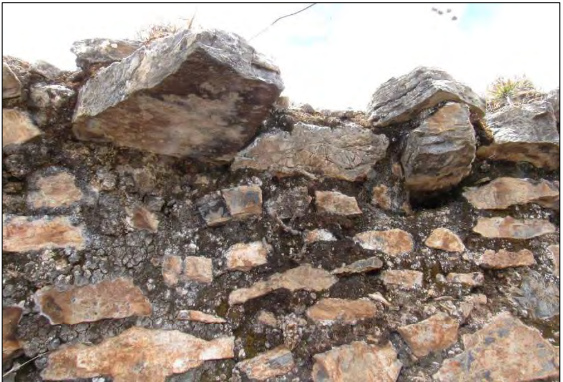
VISTA A DETALLE DE LAS LAJAS UBICADOS EN LA PARTE SUPERIOR DEL RECINTO.
