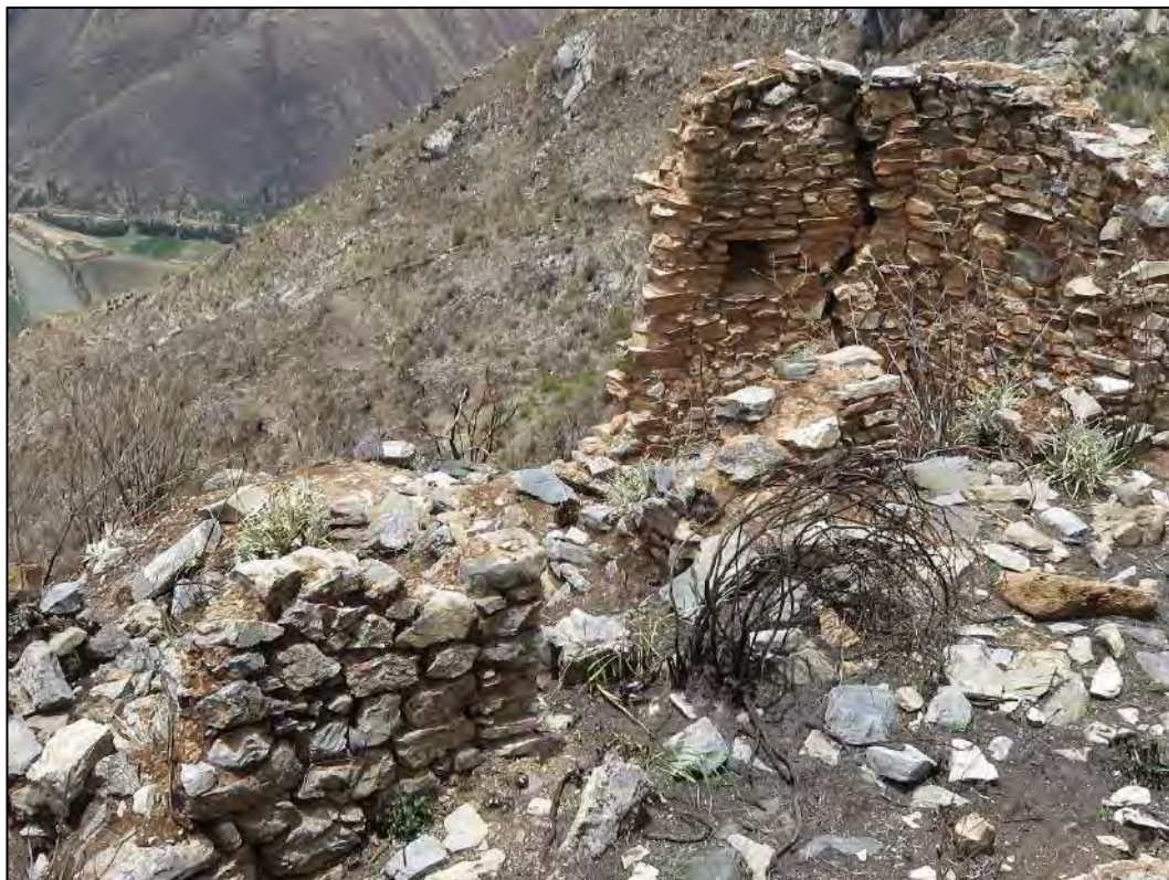
VISTA DEL RECINTO N° 06, NOTESE EL MAL ESTADO DE CONSERVACIÓN
