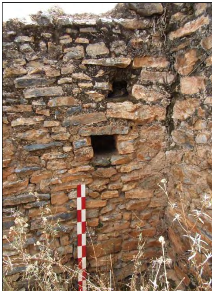
VISTA A DETALLE DEL NICHOS DEL RECINTO N° 03.
