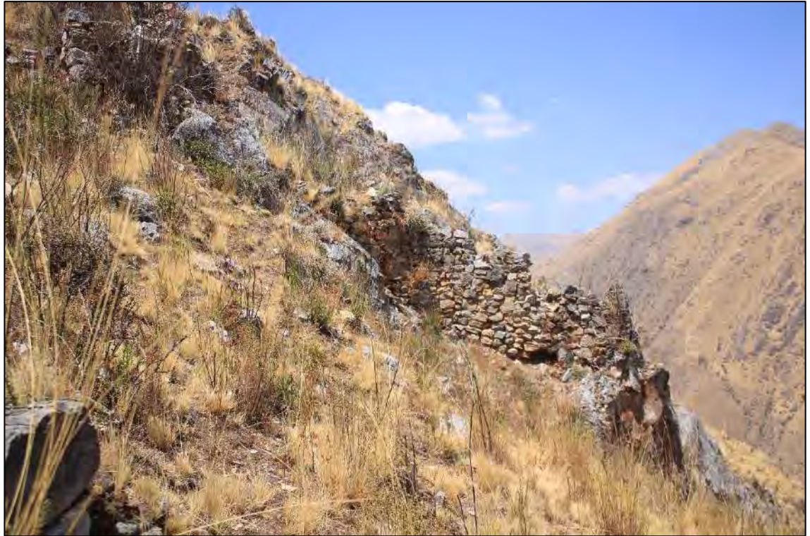
VISTA EXTERIOR DE LA MURALLA NORTE
