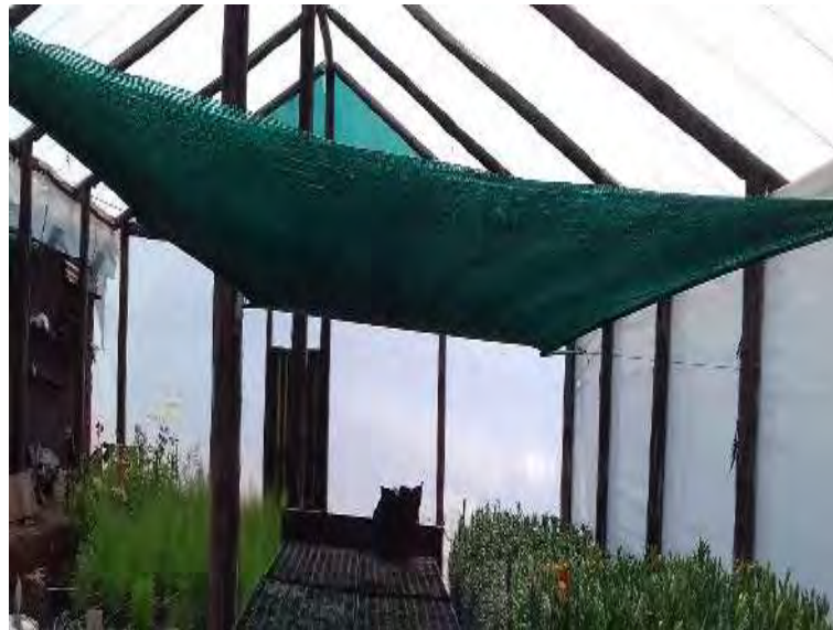
Fotografía N° 10: Instalación de malla raschel
