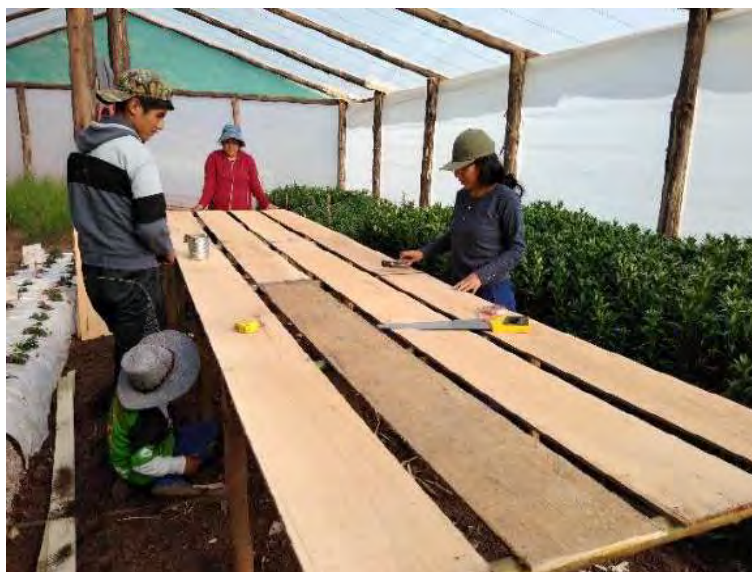
Fotografía N° 02: Construcción de tarima
