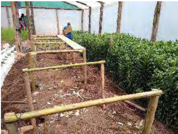
Fotografía N° 01: Construcción de tarima
