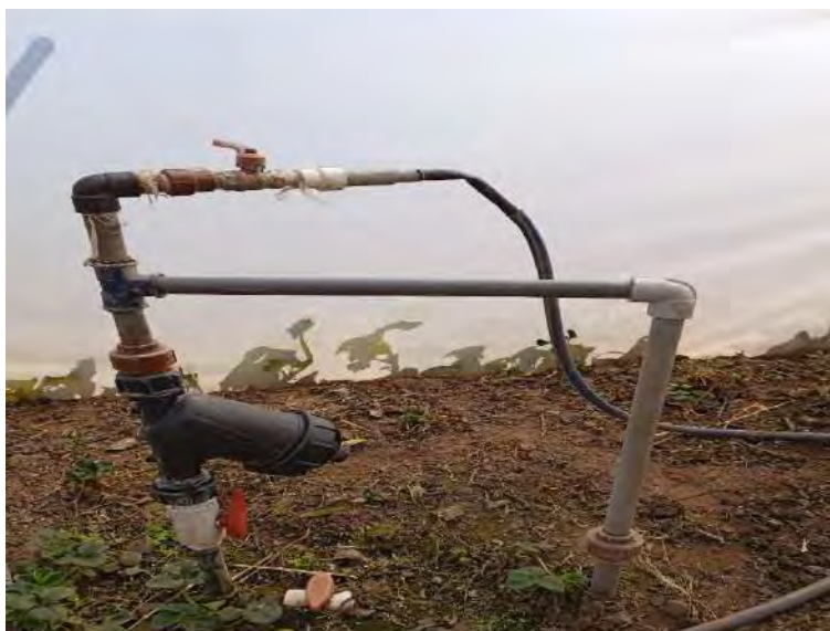
Fotografía N°11: Instalación del sistema de riego
