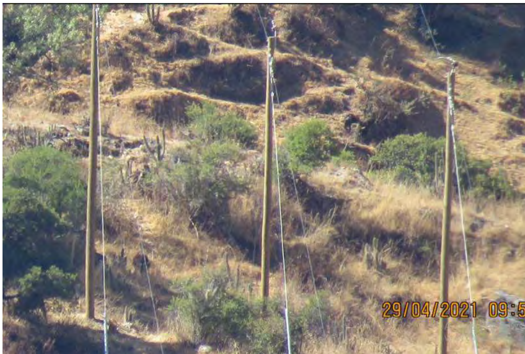
Fotografía 2. Triposte instalado en Sector Vito
