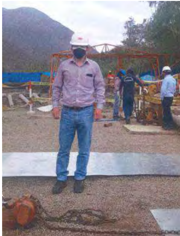
Fotografía 8. Supervision prueba de postes
