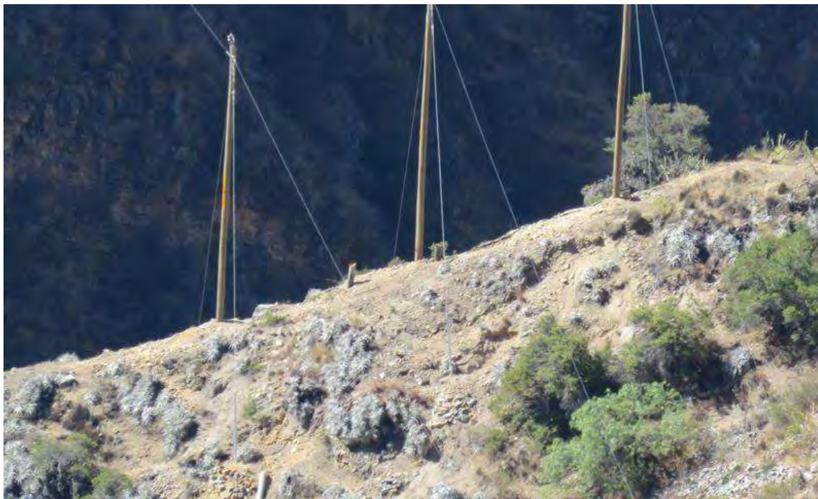
Fotografía 3. Triposte instalado sector Vito- I
