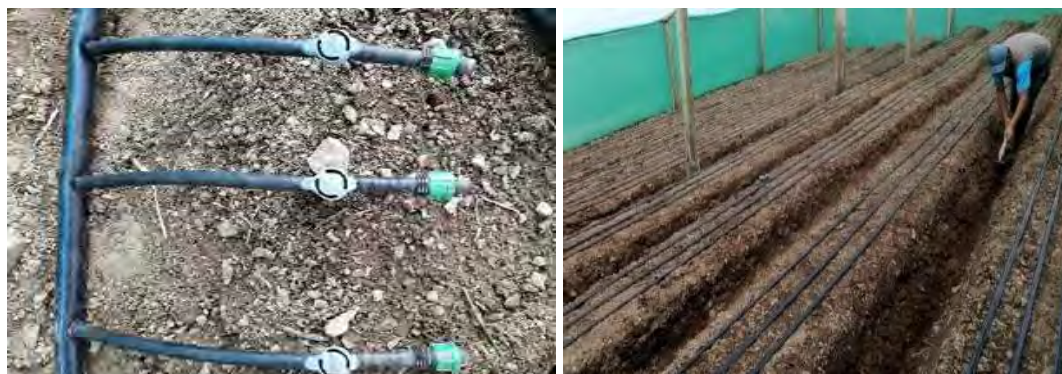
Figura 24. Instalación de sistema de riego
