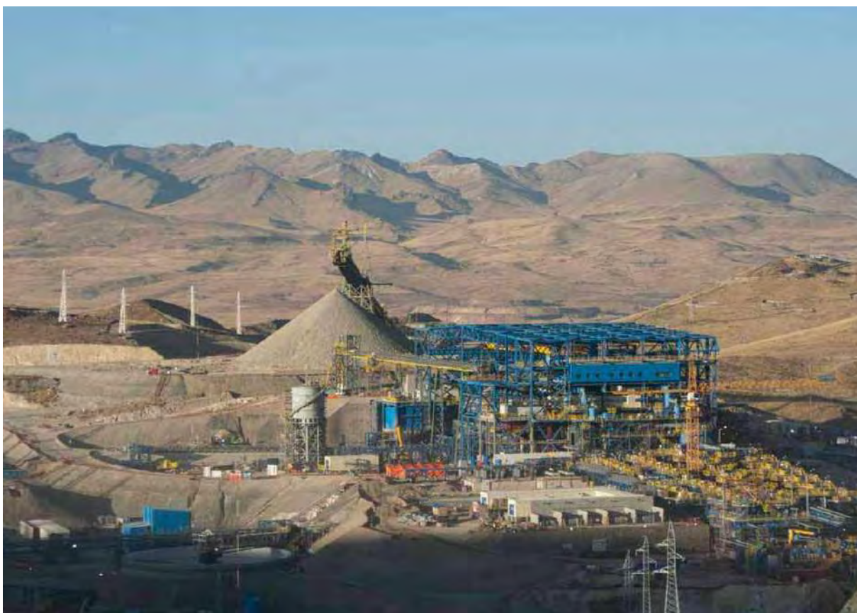
Figura 1. Planta concentradora moderna de Antapaccay.
