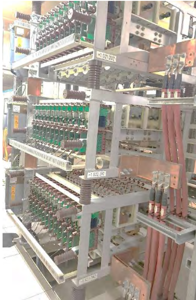
Figura 23. Cicloconvertidor para un devanado trifásico del molino Sag.
