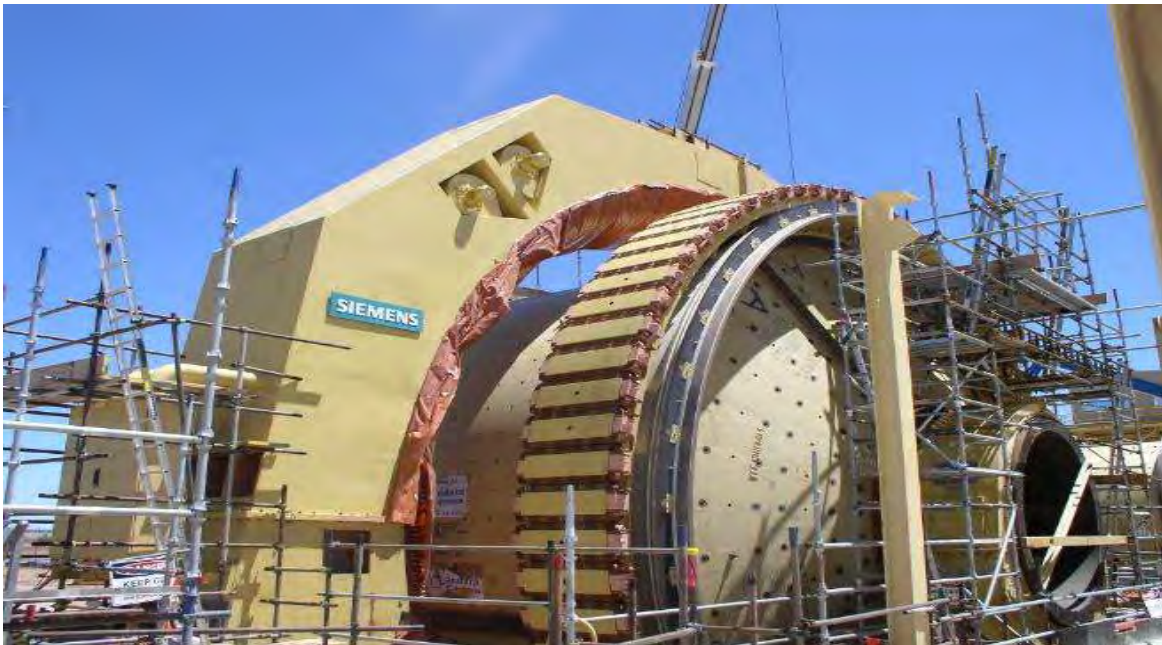
Figura 30. Desplazamiento del estator de un motor síncrono de polos salientes en MW.
