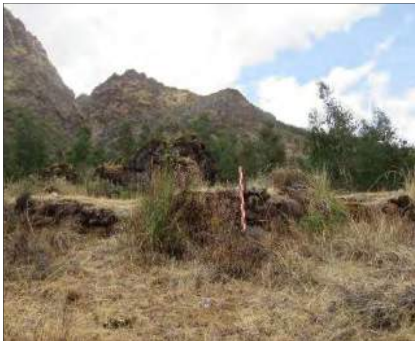
Muro de contención - 04 B
