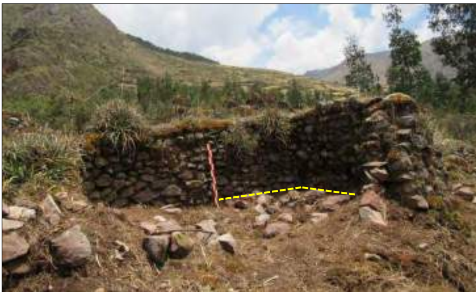
Vista de la Estructura - 23 B
