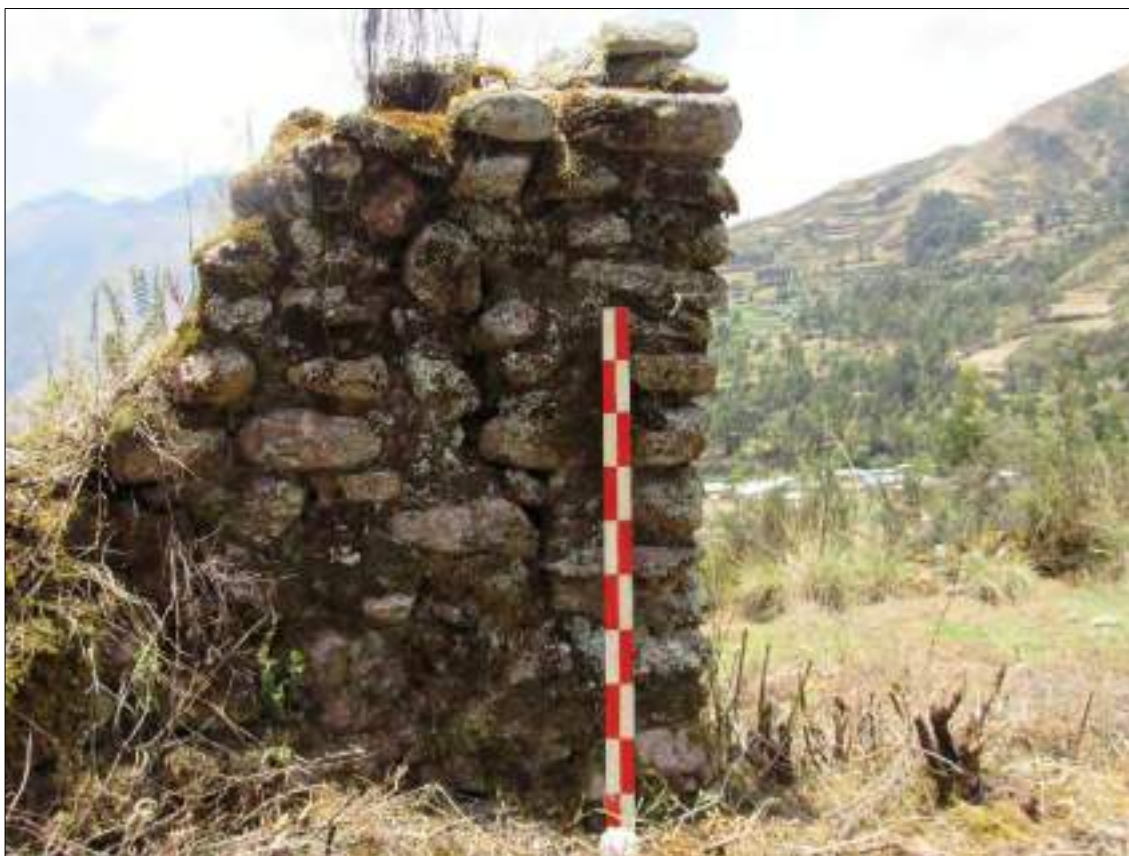
Mampostería de la Estructura -22 B
