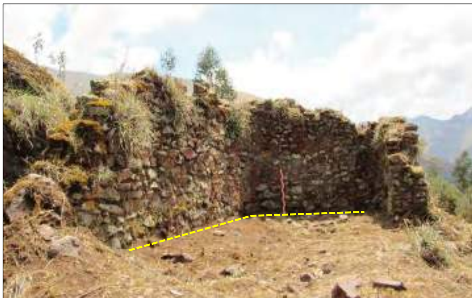
Vista de la Estructura - 24B
