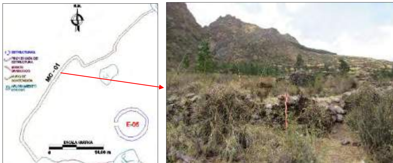
Muro de contención - 01B
