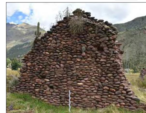
FOTOGRAFIA DEL MURO LATERAL IZQUIERDO PARTE INTERNA
