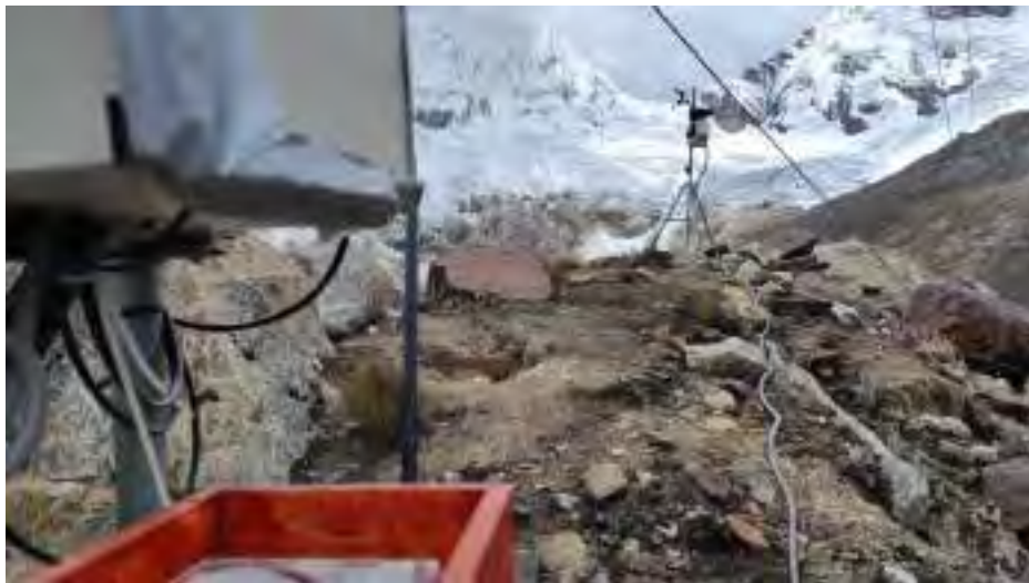
Figura 63: Lugar de instalación del sensor con vista al nevado y a la antena que proporciona WiFi a la laguna.
