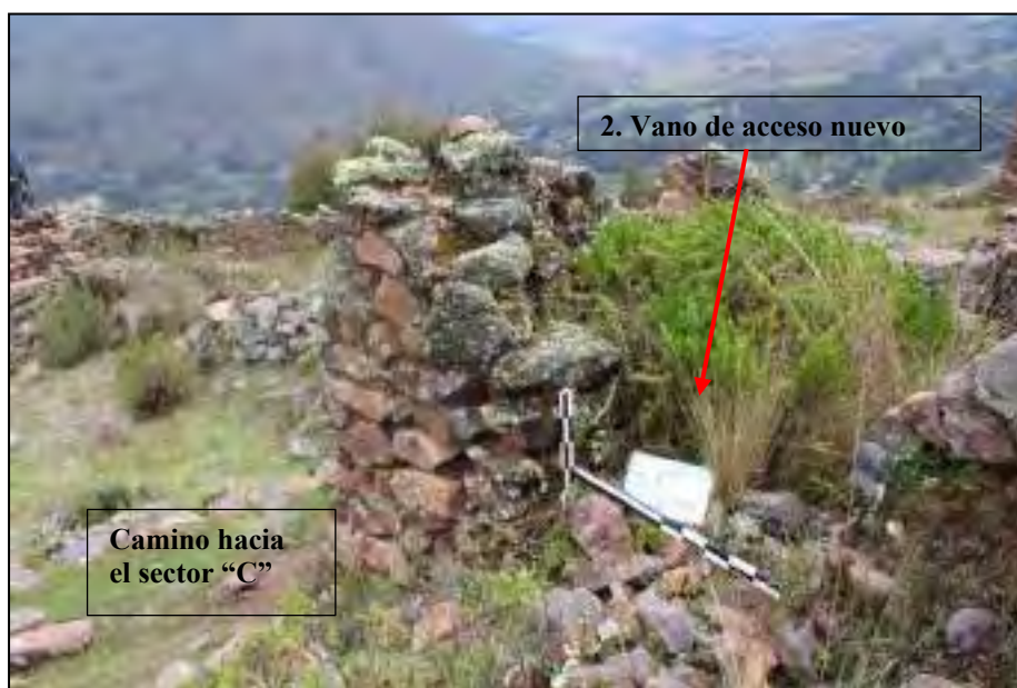
Figura 116. Vista exterior y vano de acceso, recinto R-20.
