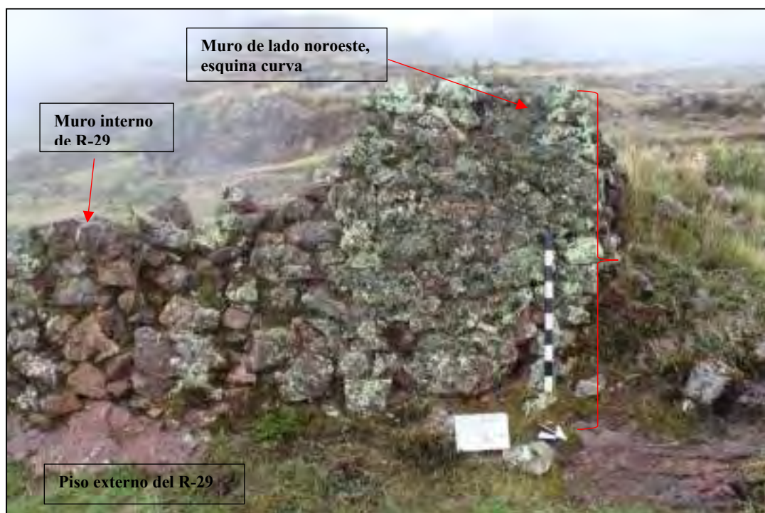
Figura 172. Muro posterior externo del recinto R-29.
