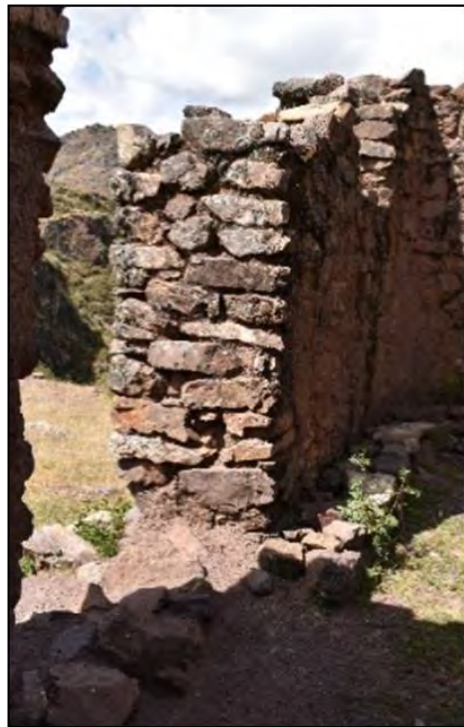
Figura 54. Vano de Acceso.
