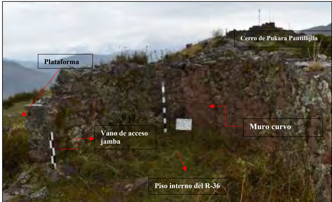
Figura 158. Muro interno del recinto R-36.
