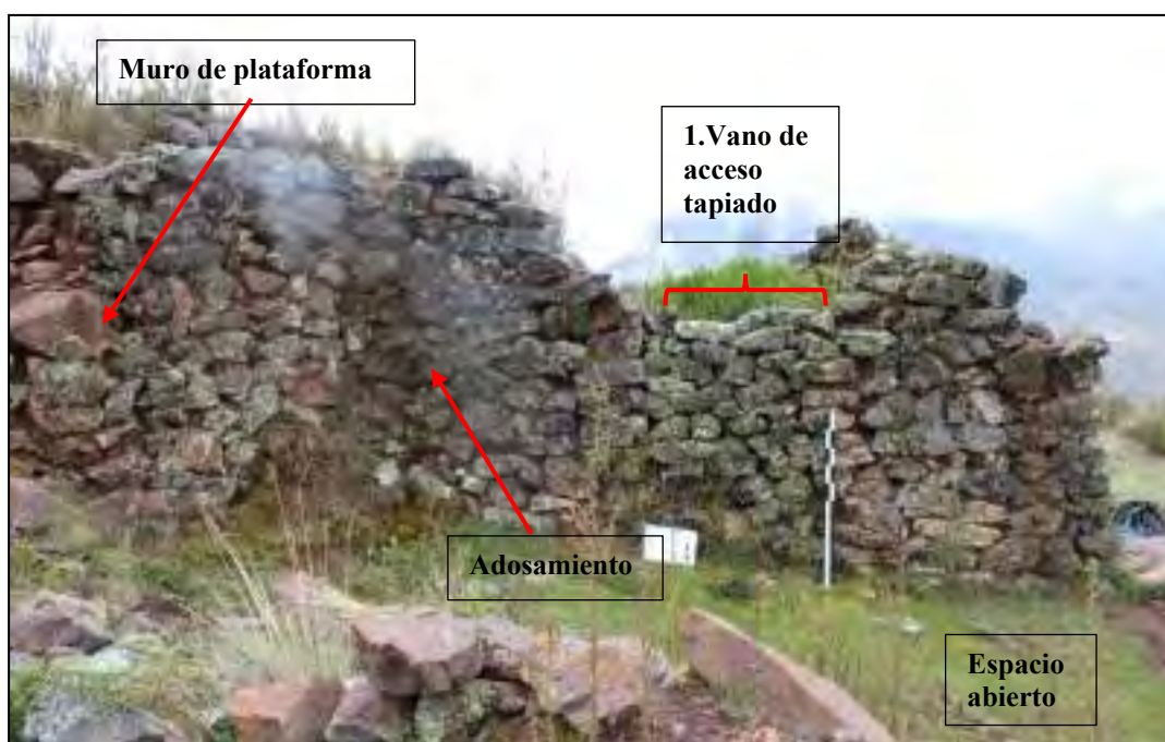
Figura 117. Vano de acceso tapiado.
