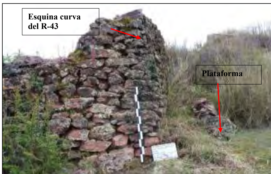
Figura 189. Esquina curva externa del recinto R-43.
