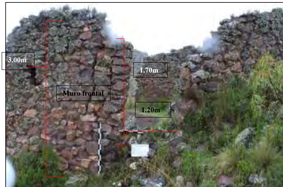
Figura 143. Muro frontal del R-35.
