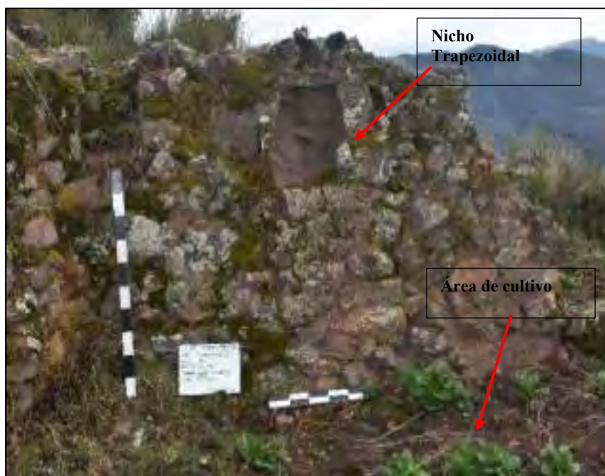
Figura 187. Características arquitectónicas del recinto R-42.
