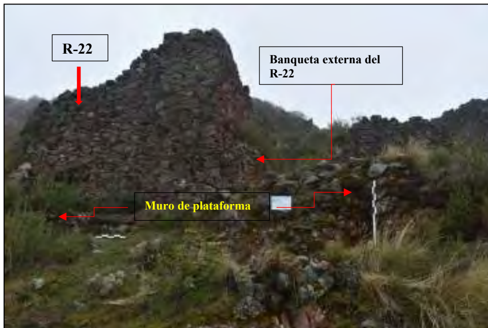
Figura 124. Recinto R-22 con plataforma.
