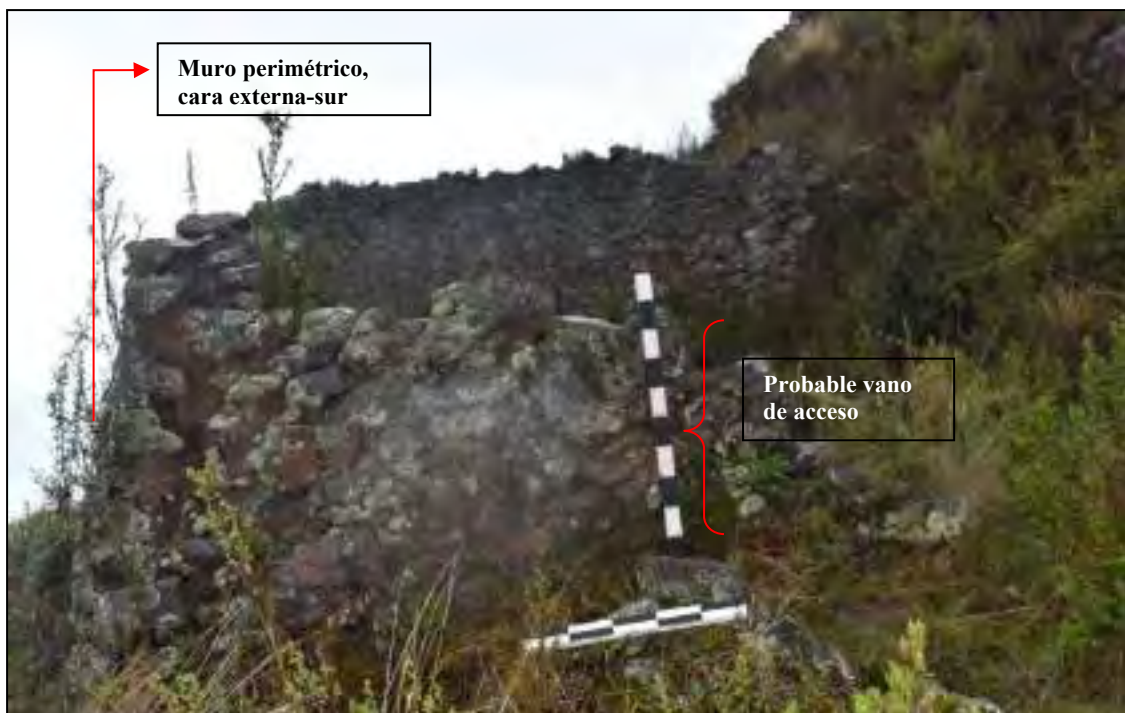
Figura 39. Vista frontal del recinto R-02
