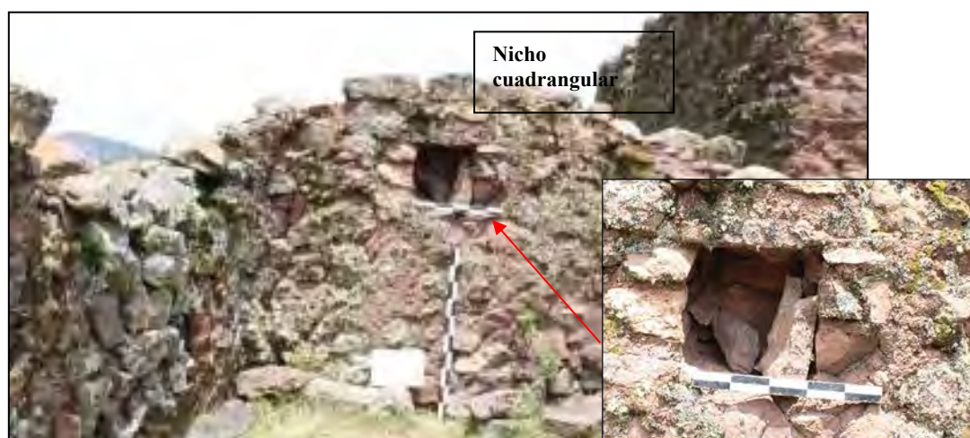
Figura 68. Vista del muro interno, recinto R-6.
