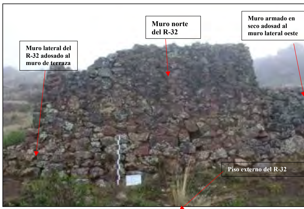
Figura 155. Muro del lado norte de R-32.
