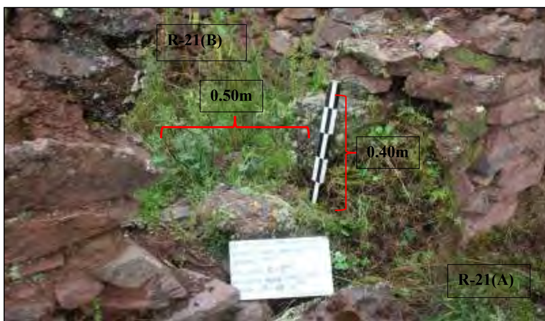
Figura 120. Vano de acceso hacia el R-21(B).
