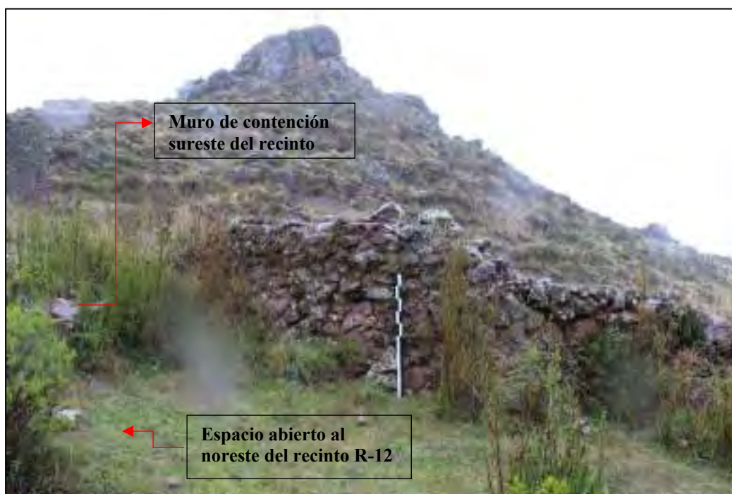
Figura 80. Muro exterior sureste, recinto R-12
