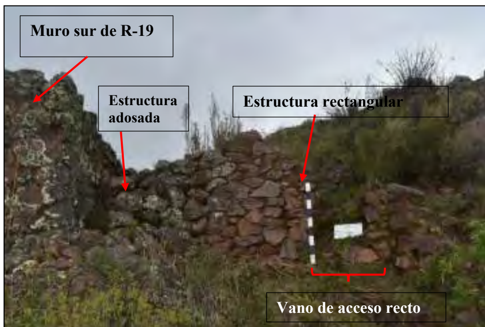
Figura 110. Estructura adosada al recinto R-19.
