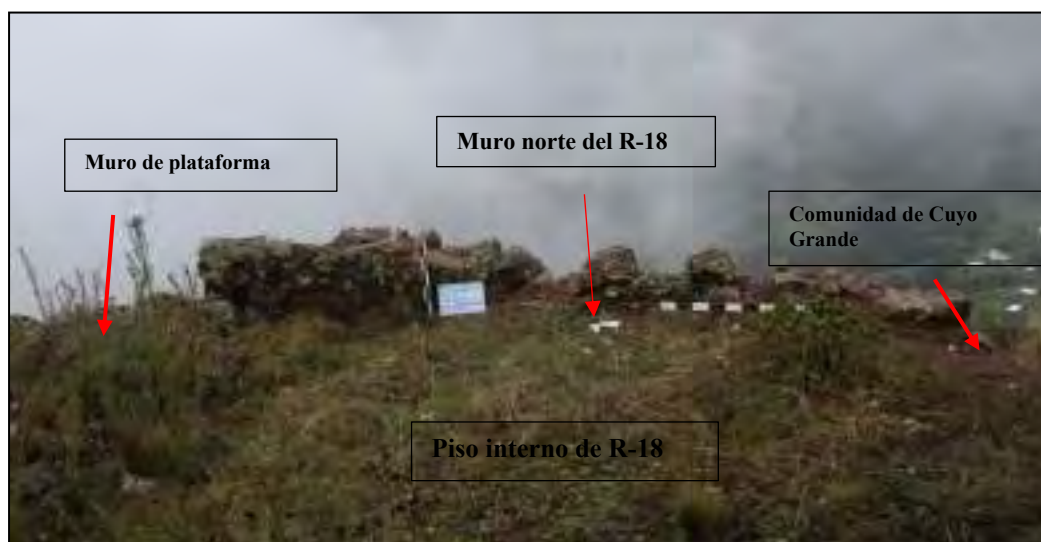
Figura 101. Vista interna del muro norte del recinto R-18.
