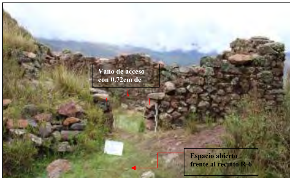
Figura 67. Vista frontal oeste del recinto R-6.
