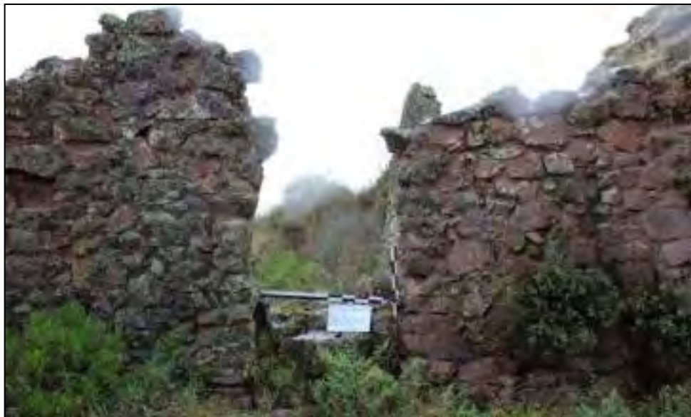
Figura 46. Vista del vano de acceso interno de forma cóncava.
