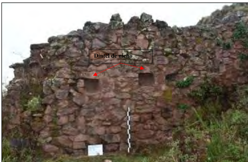
Figura 127. Muro interior del recinto R-22.
