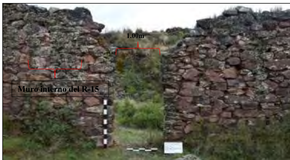
Figura 88. Vano de acceso, recinto R-15.
