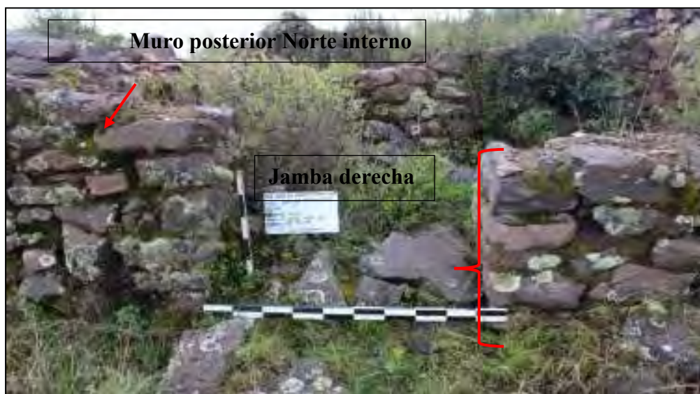
Figura 195. Vista frontal del recinto R-45.
