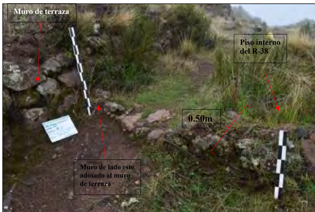
Figura 177. Vista de muro de lado este del recinto R-38.
