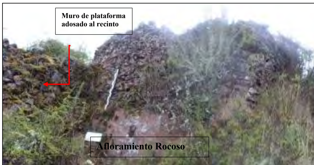
Figura 196. Vista exterior sureste del recinto R-46.
