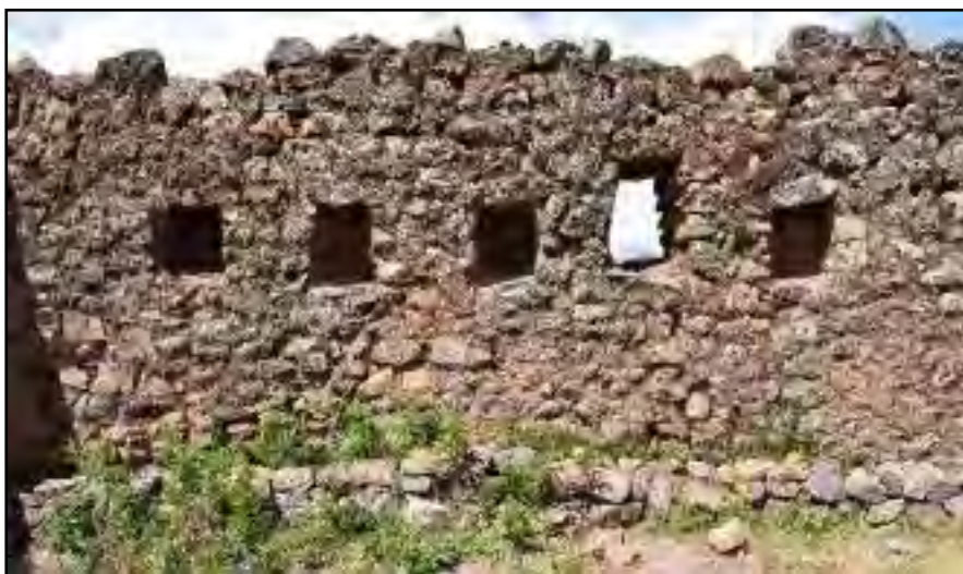
Figura 57. Foto de muro lateral interno sur, recinto R-7.
