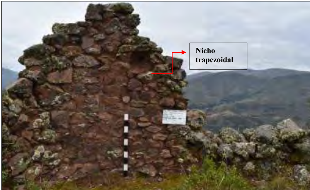
Figura 97. Muro interno noroeste del recinto R-17.
