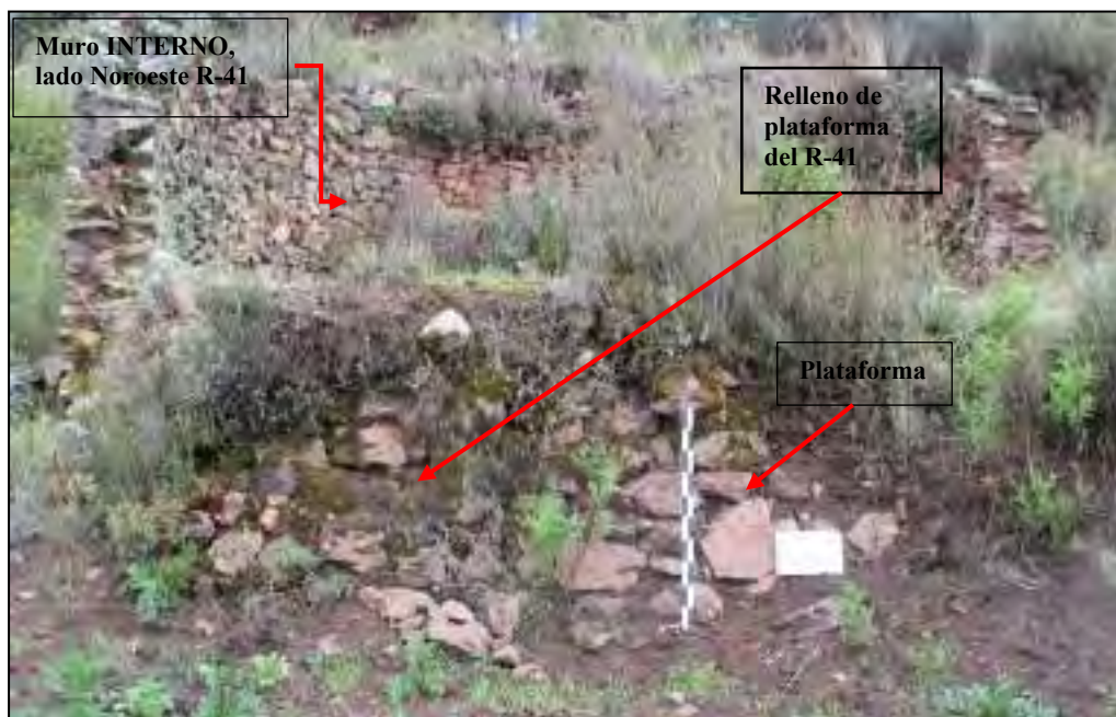
Figura 184. Adosamiento de muro de terraza.
