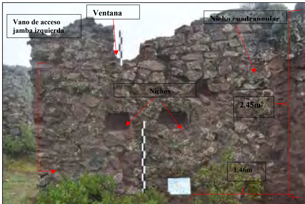
Figura 126. Muro interno del R-22.
