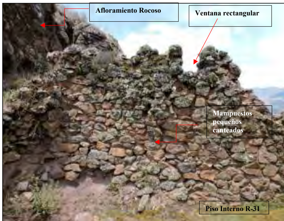
Figura 149. Muro lateral interno del lado oeste.
