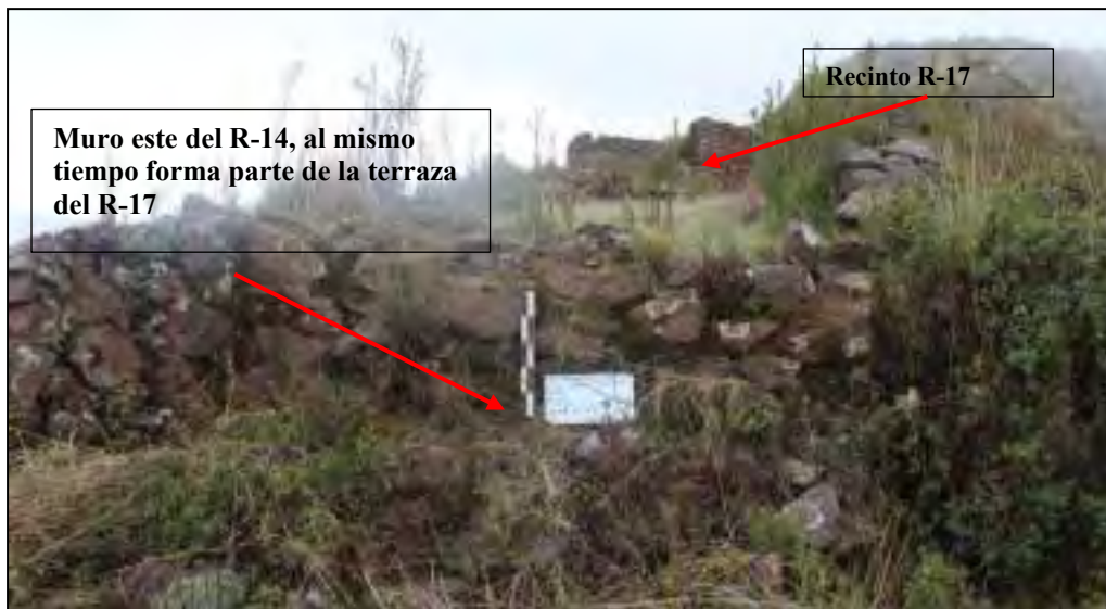
Figura 86: Vista del muro, lado exterior este del R-14
