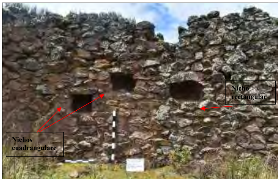
Figura 72. Vista interna del muro norte, recinto R-8.
