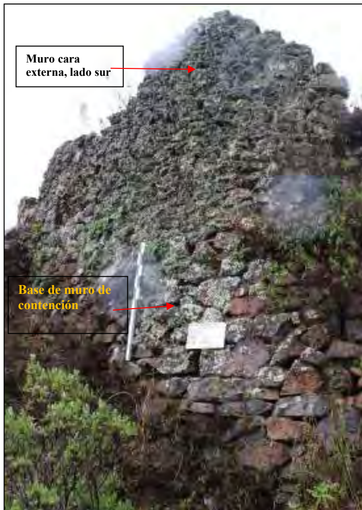
Figura 43. Vista del muro sureste exterior del recinto R-4
