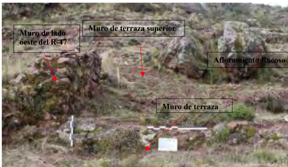
Figura 219. Vista del muro de lado oeste del recinto R-47.
