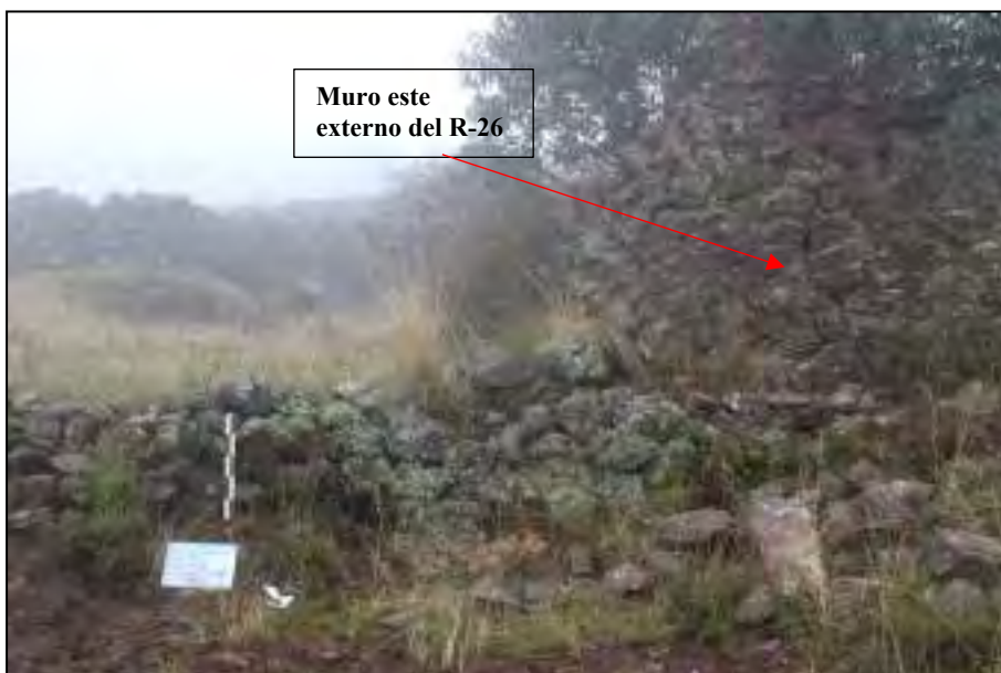
Figura 134. Recinto R-26 sobre muro de contención.
