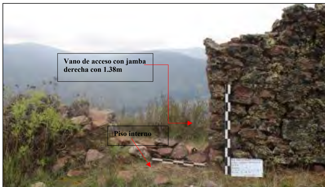
Figura 128. Vano de acceso.
