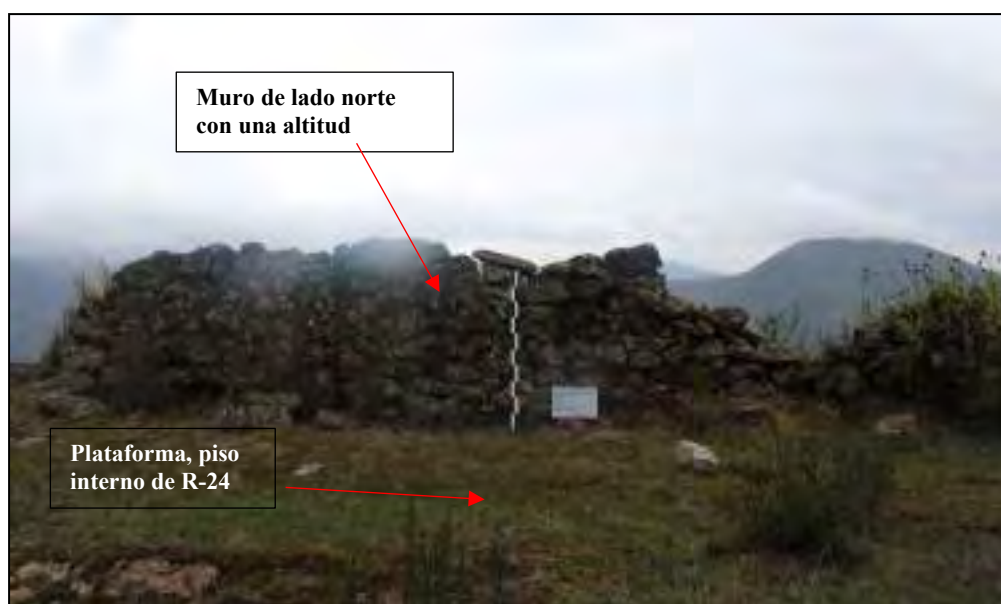
Figura 129. Muro lado norte.
