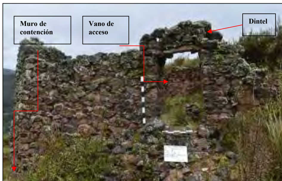
Figura 69. Vista de muro frontal oeste, recinto R-8.
