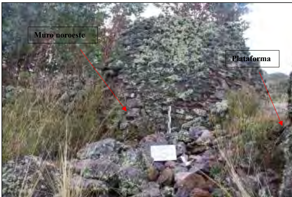
Figura 133. Muro de lado noroeste, recinto R-26.
