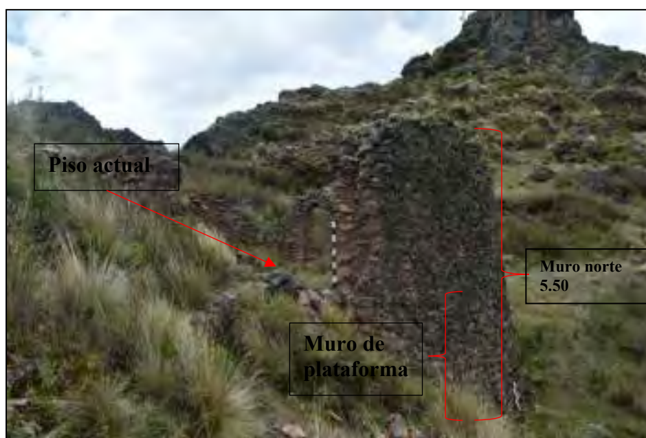
Figura 70. Muro externo norte – muro de contención recinto R-8.
