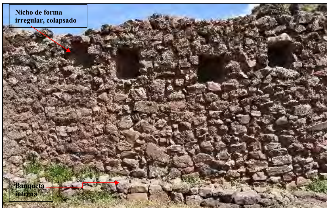
Figura 61. Vista interna del muro Oeste.
