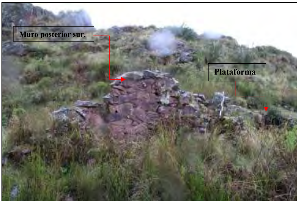
Figura 81. Muro interior lado sur.
