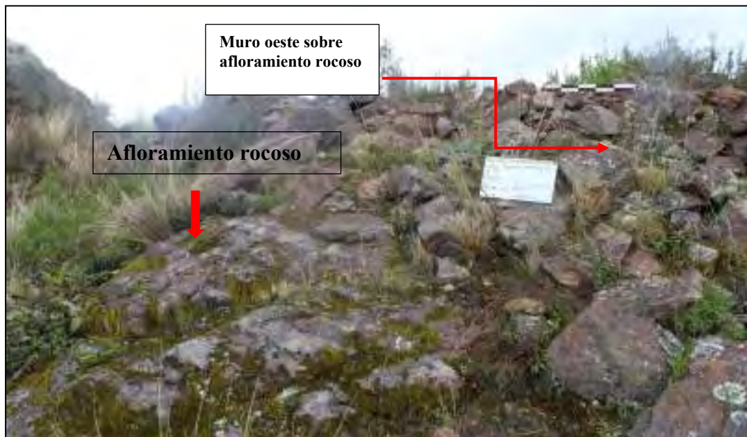
Figura 87. Construcción de muro del recinto R-14, sobre afloramiento rocoso.
