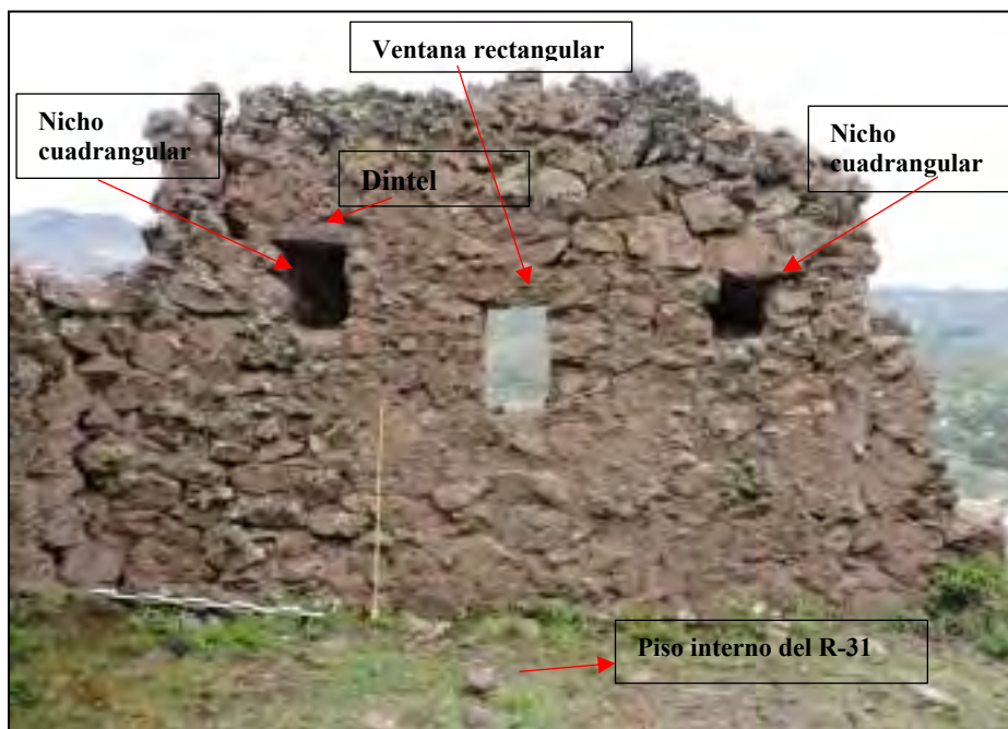
Figura 152. Muro de lado oeste.
