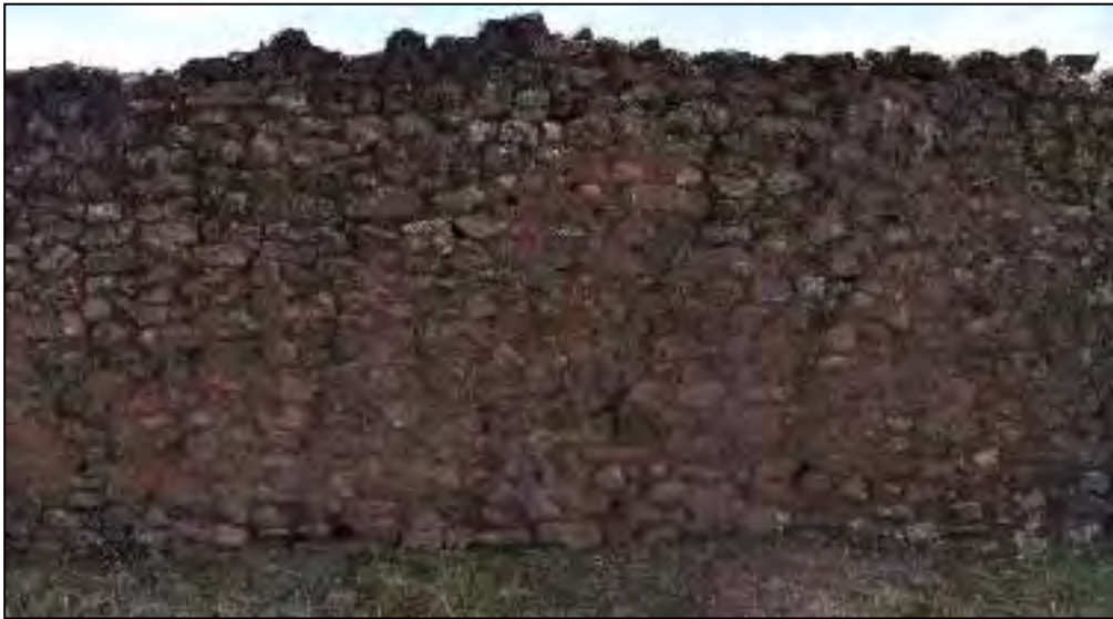
Figura 60. Vista de muro posterior suroeste del recinto R-7.
