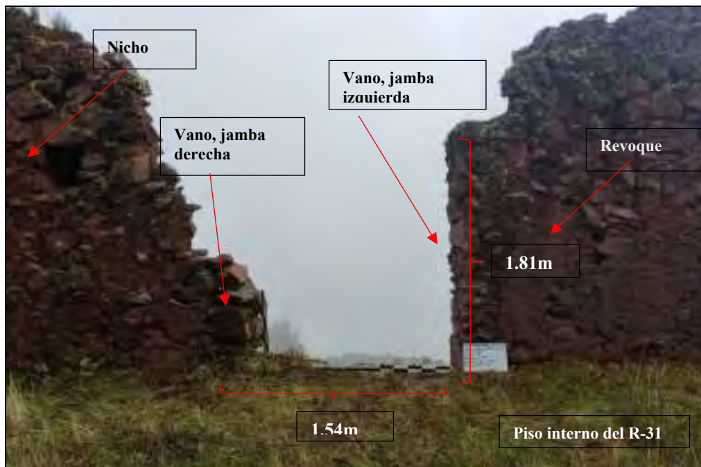
Figura 153. Vista de muro interno.
