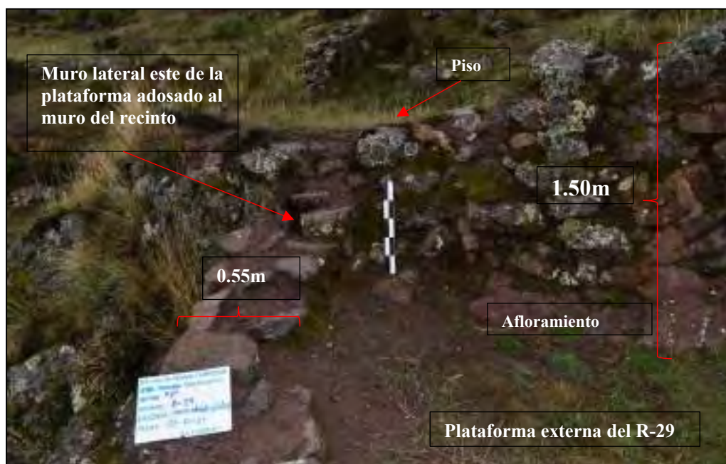
Figura 171. Vista frontal del recinto R-29.
