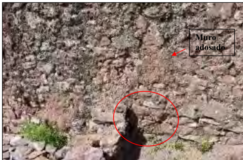
Figura 63. Estructura adosada al recinto R-7.
