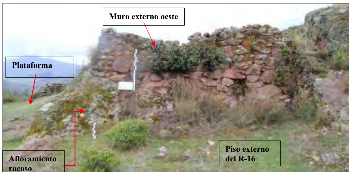
Figura 92. Muro externo del recinto R-16
