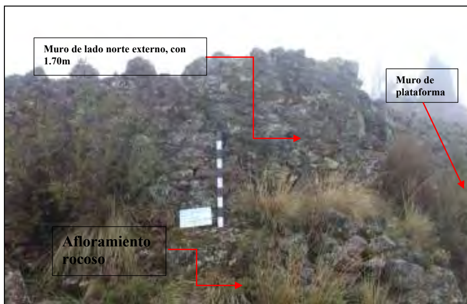
Figura 102. Muro exterior norte del recinto R-22.
