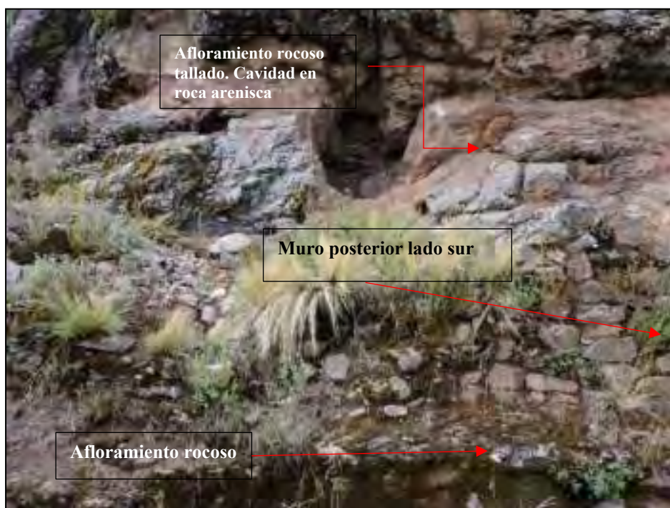
Figura 151. Muro posterior del recinto R-31.
