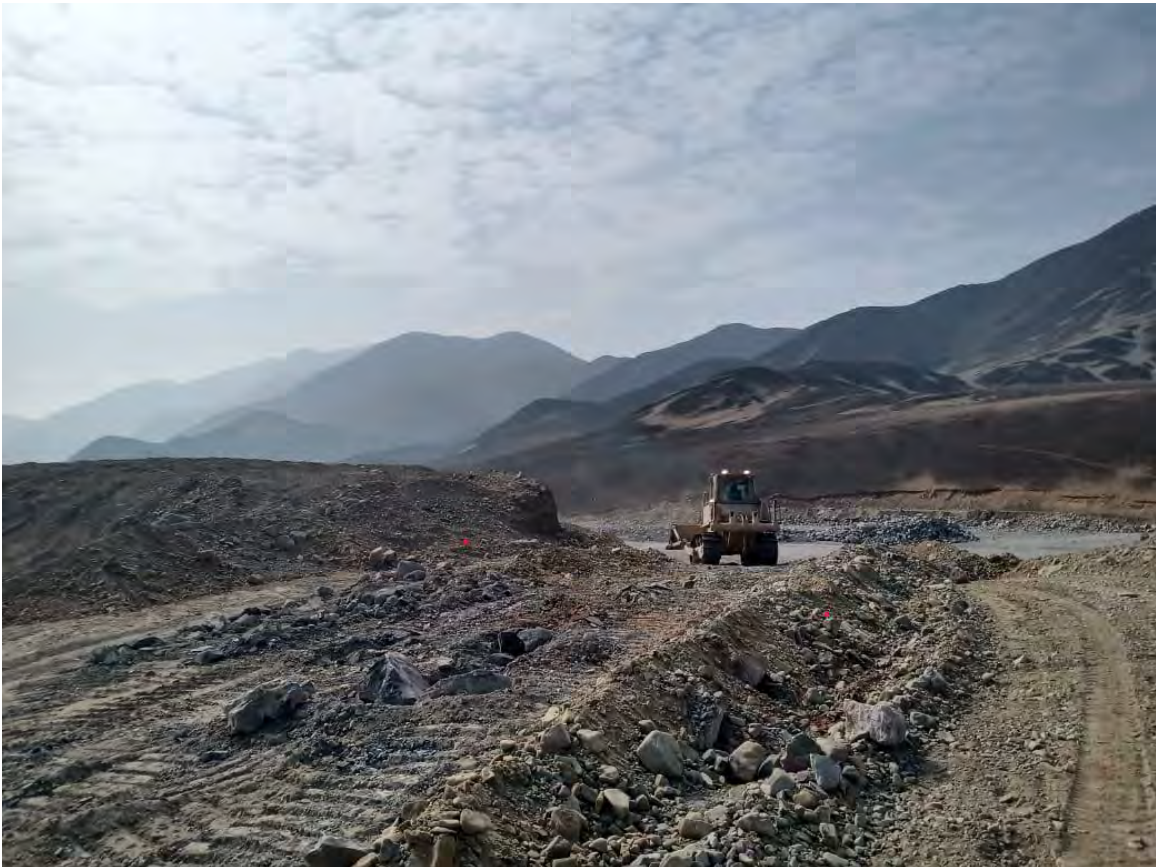
Figura 14: Construcción de Rampas
