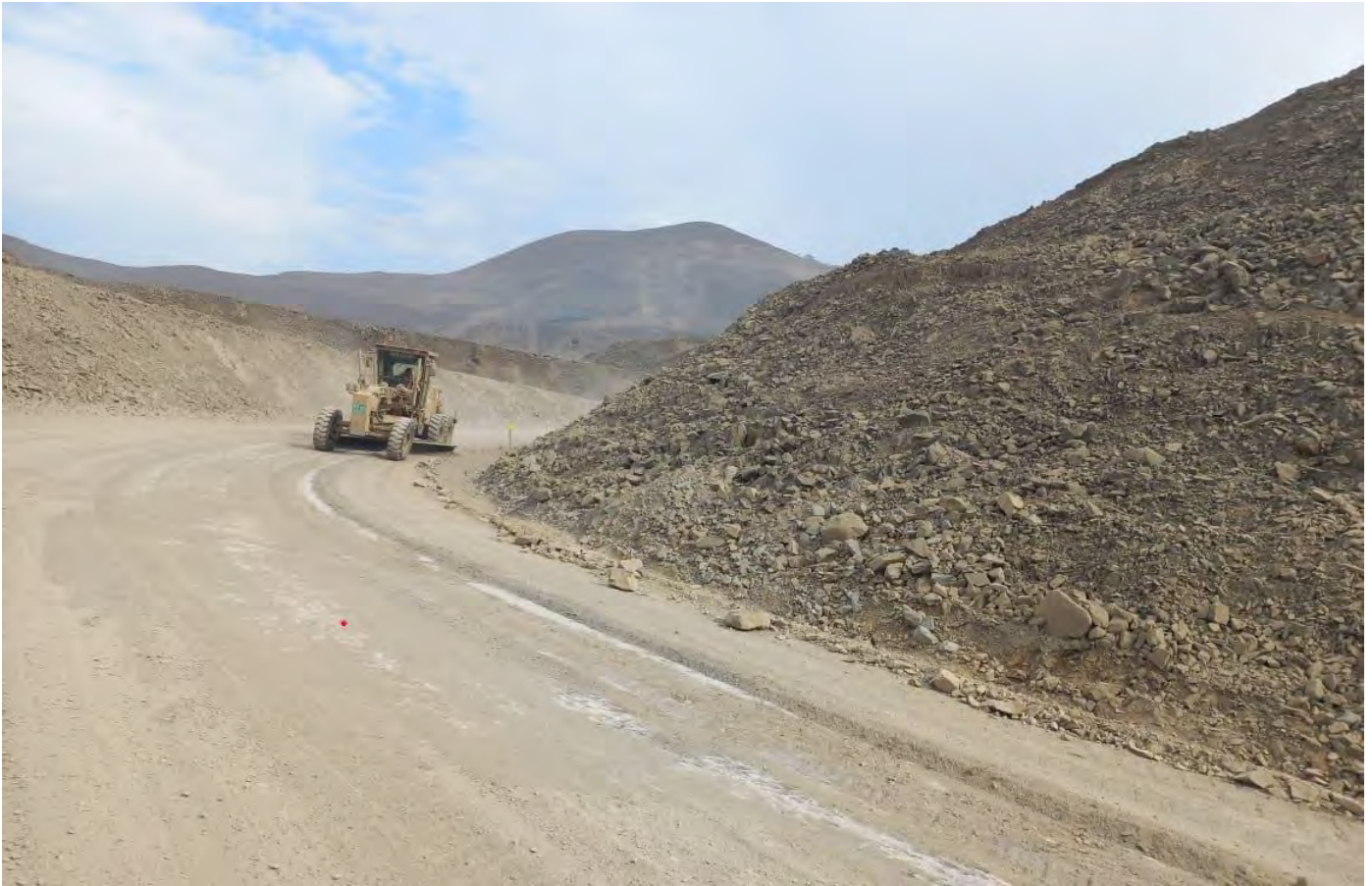
Figura 15: Mantenimiento de vías
