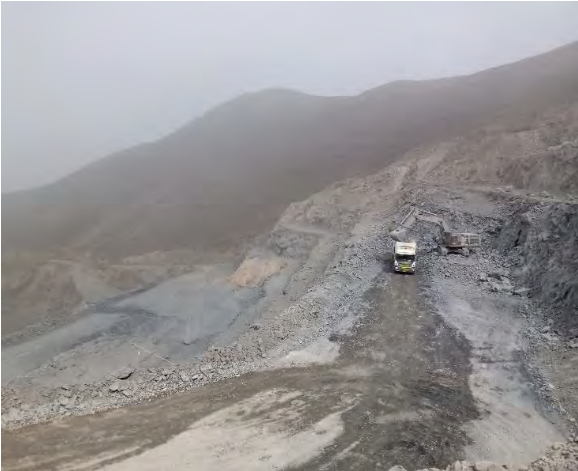
Figura 4: Carguío de Excavadora
