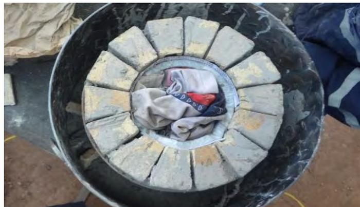
El vaciado de la parte exterior de la cámara de combustión, se inicia colocando el material aislante como la manta cerámica y luego se vierte el concreto refractario entre la estructura metálica y los ladrillos, en donde se formará una sola pieza que estará constituido por cuatro paredes que es la estructura metálica, concreto refractario, aislante térmico y el ladrillo refractario donde se tendrá mayor resistencia estructural y menores pérdidas de calor.
