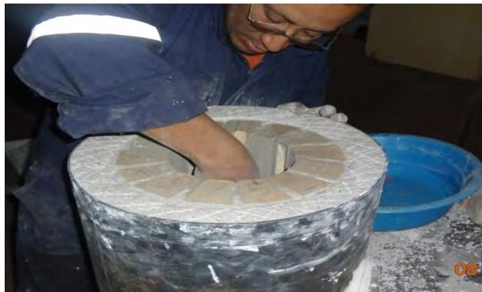
Cuando fragüe el concreto refractario se debe realizar el curado de la cámara de combustión dándole un acabado para su secado y posteriormente su funcionamiento.
