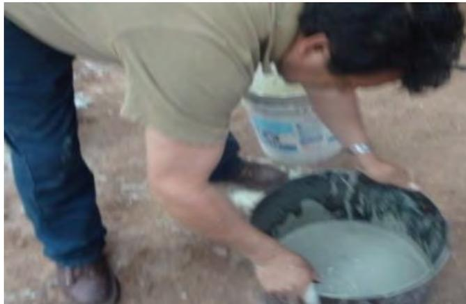
Al fraguar el concreto refractario de la base, se debe realizar el curado de la parte circular que va ser la plantilla para de la formación cilíndrica de la cámara de combustión, se debe ubicar la posición de la entrada de la tobera del quemador teniendo que orientar tangencialmente al círculo de la base y para que cuando la llama ingrese no tenga resistencia y genere turbulencia en forma de remolino en el contorno del crisol.
