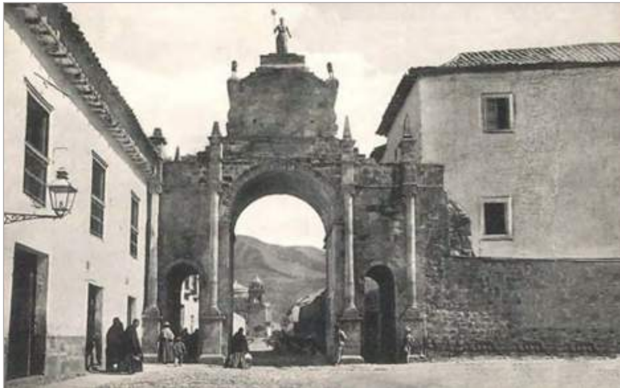
Figura 21. Fotografía en la que se aprecia faltantes de elementos arquitectónicos.
