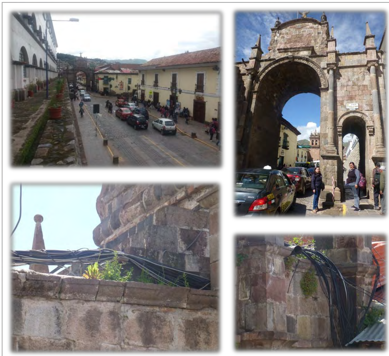
Figura 14. Tránsito vehicular, peatonal y cableado incontrolado.
