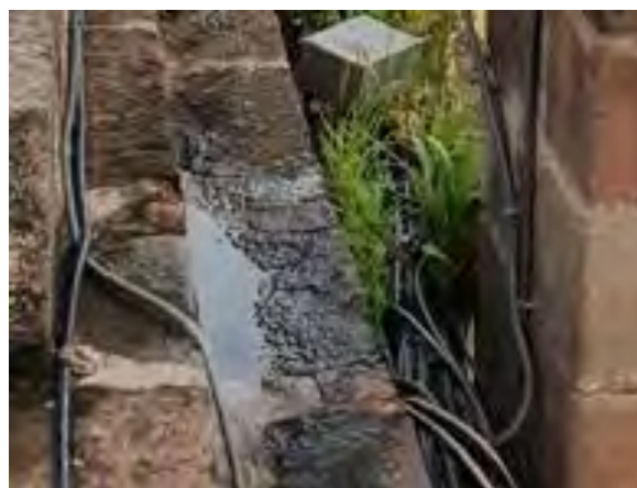
Lado posterior de muro de carga N° 02
