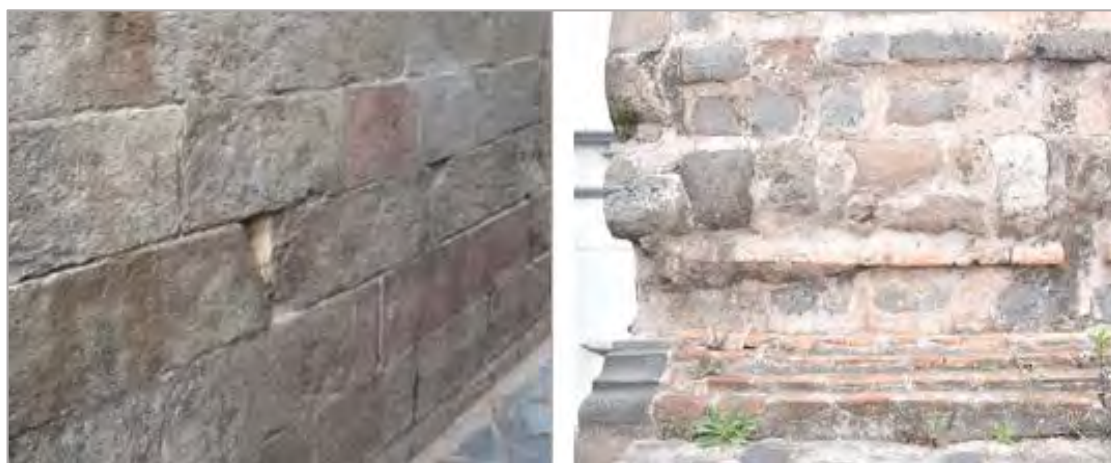
Figura 82. Aparejo isódomo o regular y mampostería ordinaria por hiladas.
