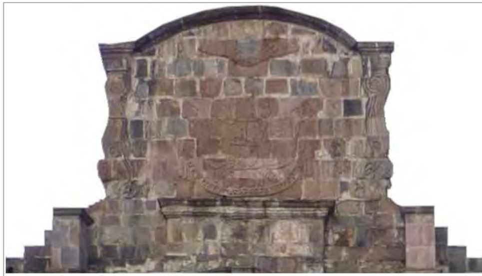
Figura 52. Muro de carga N° 02 del lado anterior.
