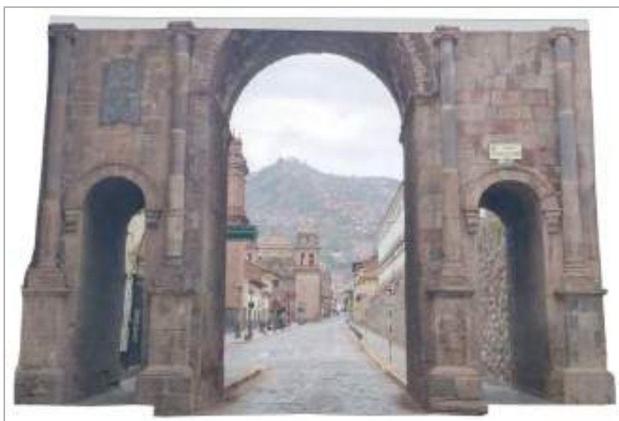
Figura 51. Muro de carga N° 01 del lado anterior.
