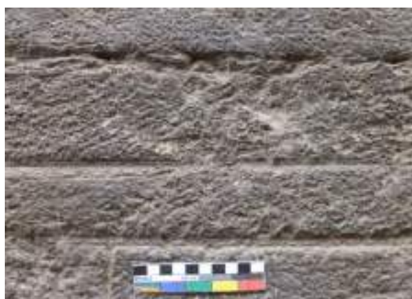
Interior del arco N° 02 - parte media
