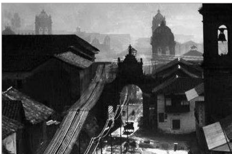
Figura 27. Cableado eléctrico sobre el Arco Santa Clara.
