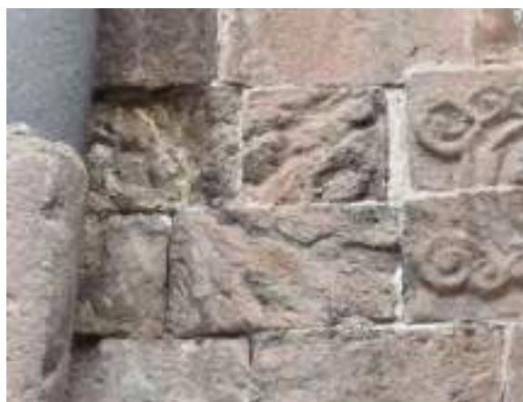
Muro de carga N° 01 - L. posterior
