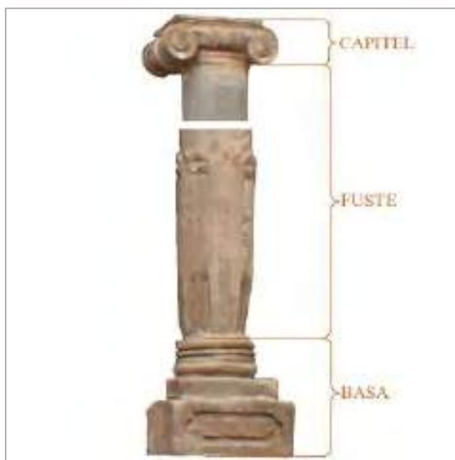
Figura 58. Partes de una columna.
