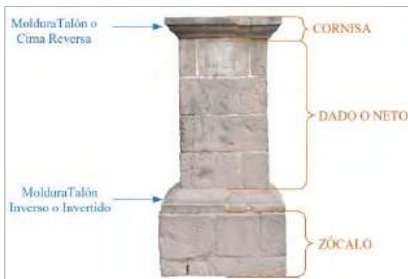
Figura 53. Partes de un pedestal en el M. H. Arco de Santa Clara.
