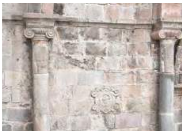
Entre paño del muro de carga N° 0 - L. anterior
