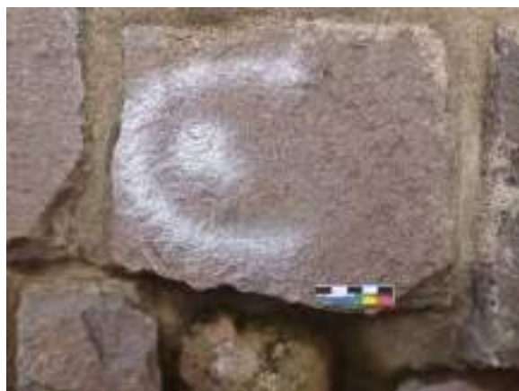
Lateral izquierdo del contrafuerte
