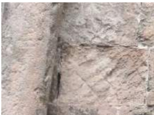
Muro de carga N° 01 - L. posterior
