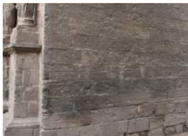
Interior del muro de carga N° 01
