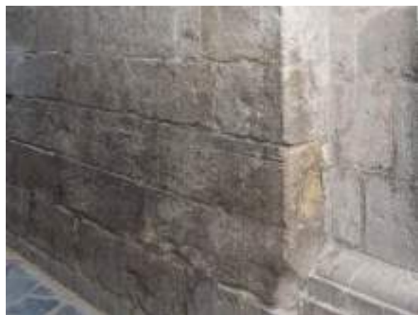
Interior del muro de carga N° 01
