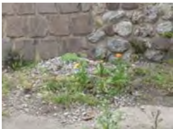
Área próximo al lateral izquierdo del contrafuerte
