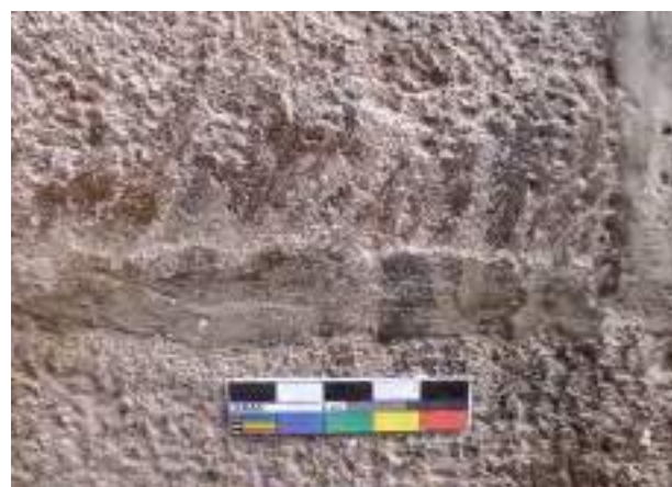
Muro de carga N° 01
