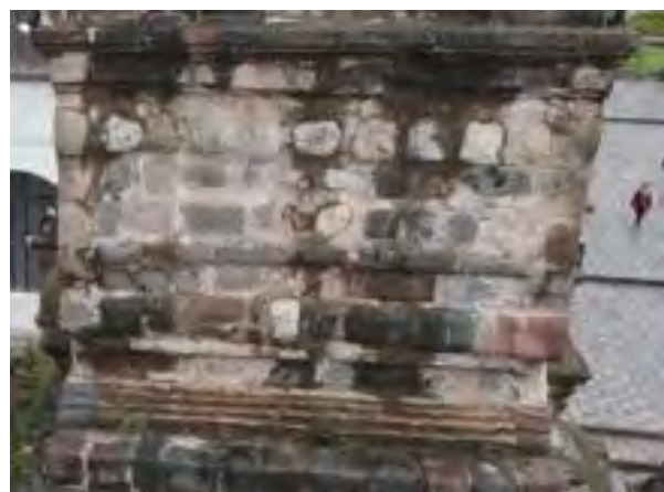
Lateral derecho del muro de carga N° 02
