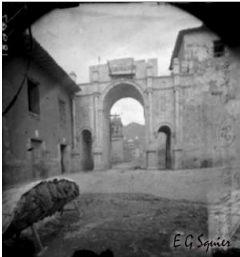
Figura 19. El Arco de Santa Clara en proceso de construcción del remate.
