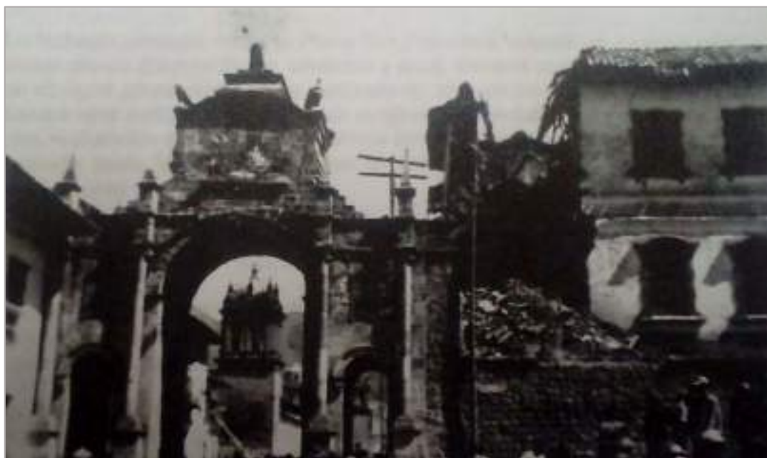
Figura 36. Vista frontal del Arco de Santa Clara después del terremoto de 1950.
