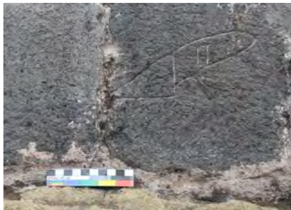
Muro de carga N° 02 - lateral izquierdo
