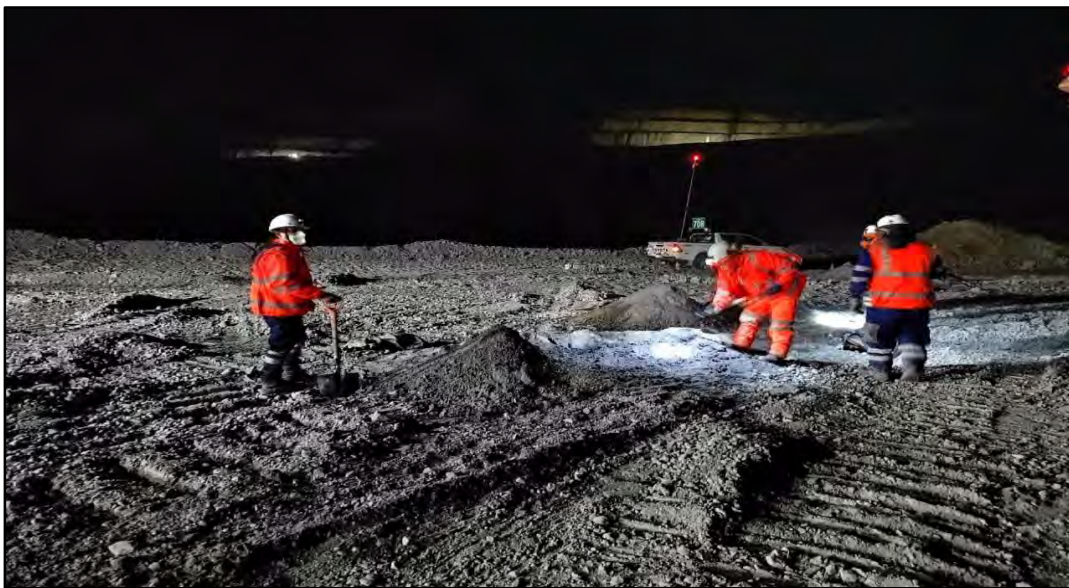
Cimentación de Geófonos con mezcla
