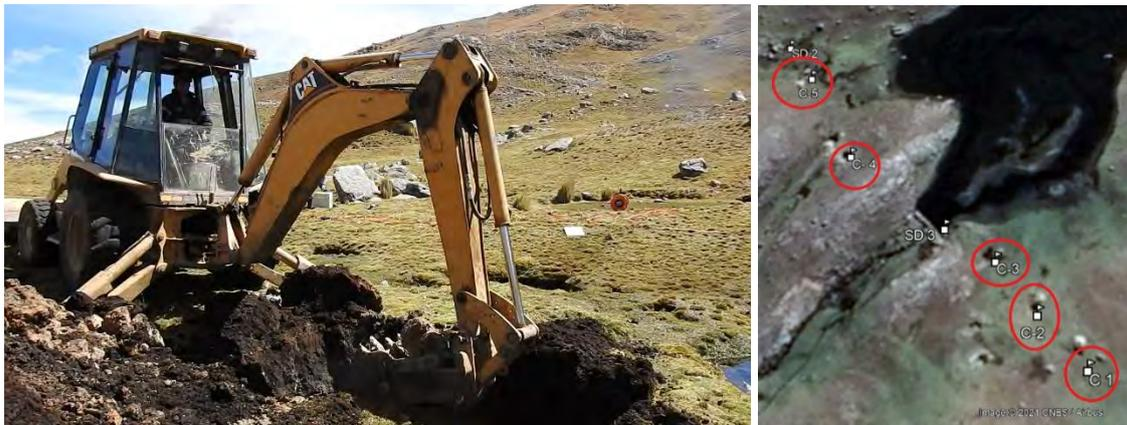
*Figura 53. Proceso de excavación con retroexcavadora CAT 416D y ubicación de calicatas*
