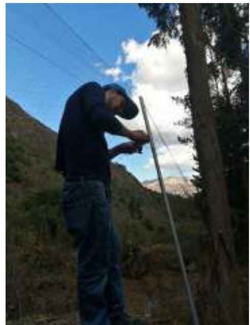
Instalación de redes niebla
