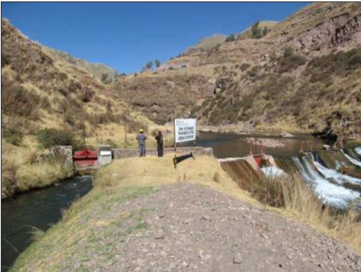
Figura 3.7: Compuerta de admisión de la PCH de Hercca
