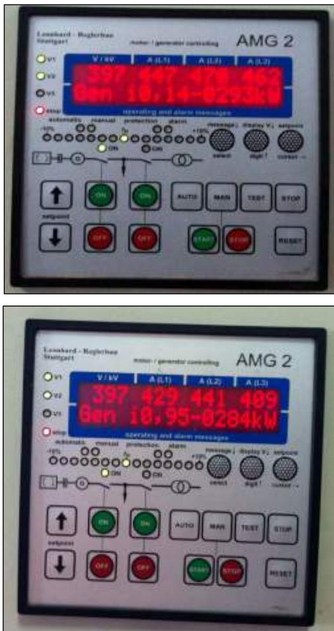
Figura 3.36: Variables definidas por el regulador de tensión, protección del generador y aviso de fallas del G1 y G2 de la PCH de Hercca.
