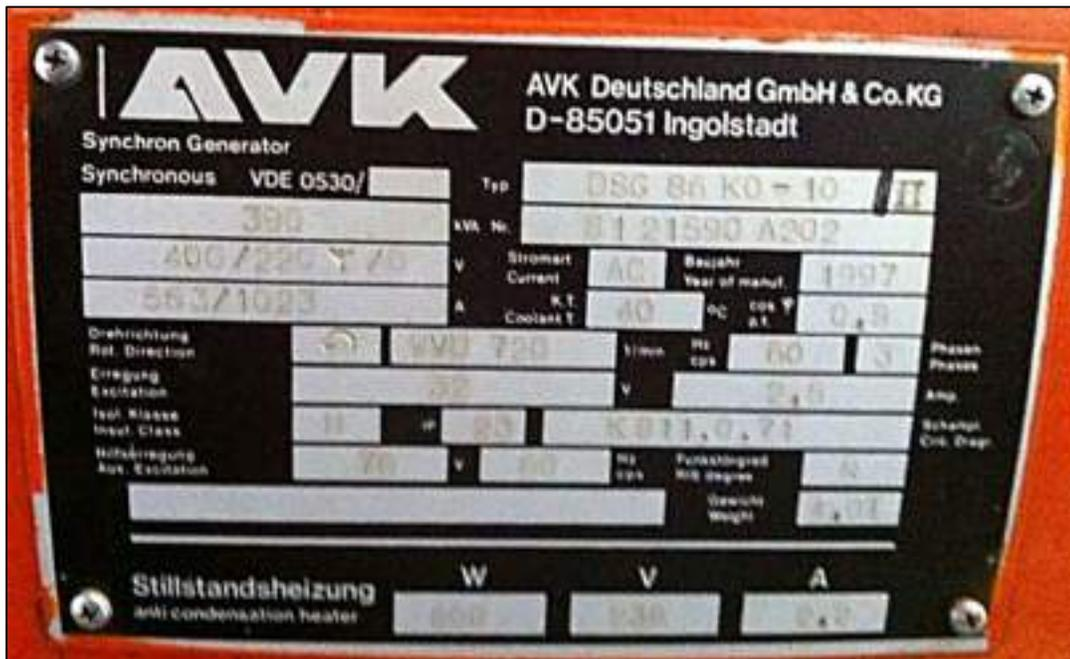
Figura 3.29: Placa de características del Generador síncrono II
