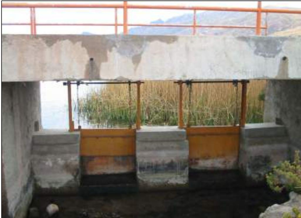
Figura 3.5: Compuertas del sistema de regulación de la laguna Langui Layo
