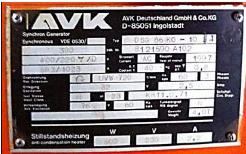
Figura 3.27: Placa de características del Generador síncrono del grupo de generación I
