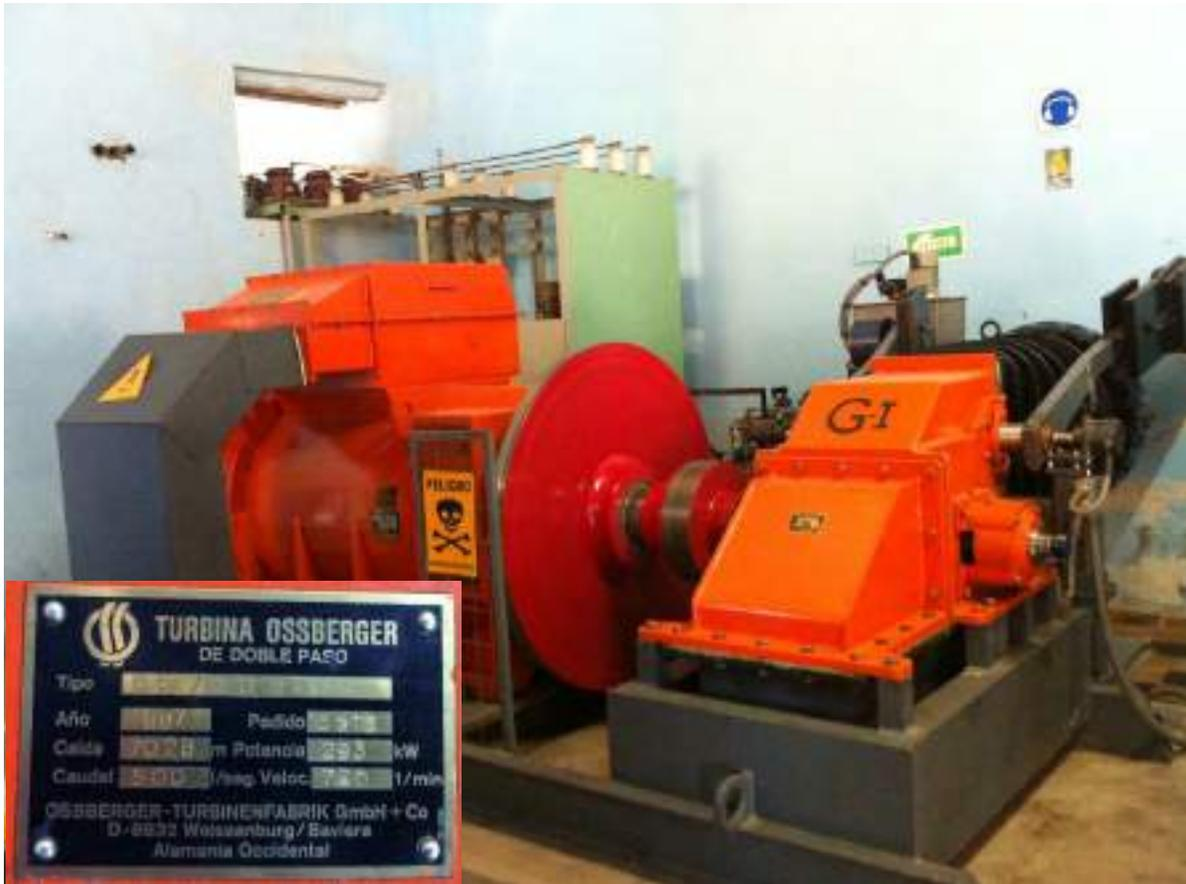
Figura 3.19: El grupo de generación I: Turbina, volante de inercia y generador
