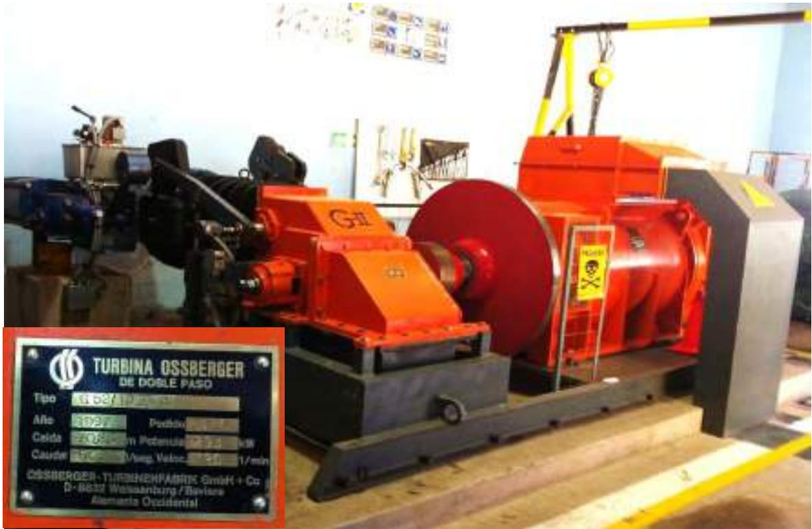
Figura 3.20: El grupo de generación II: La turbina, volante de inercia y el generador
