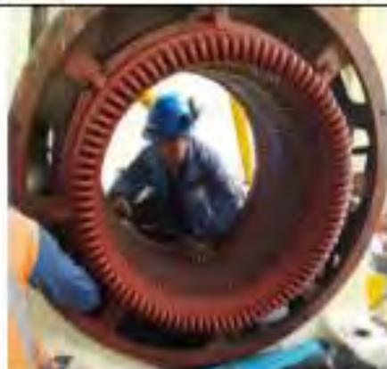
LIMPIEZA Y REBARNIZADO DEL ESTATOR Y ROTOR
