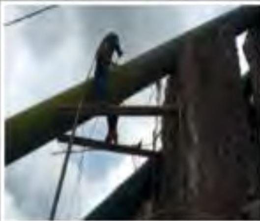
Procediendo a la unión de la tubería antigua con la nueva tubería, mediante la soldadura de penetración E-6011 y recubrimiento E-7018. Total de tubería cambiada 15.20 m. Progresivo 0+110, cambio de tubería 7.20 m.
