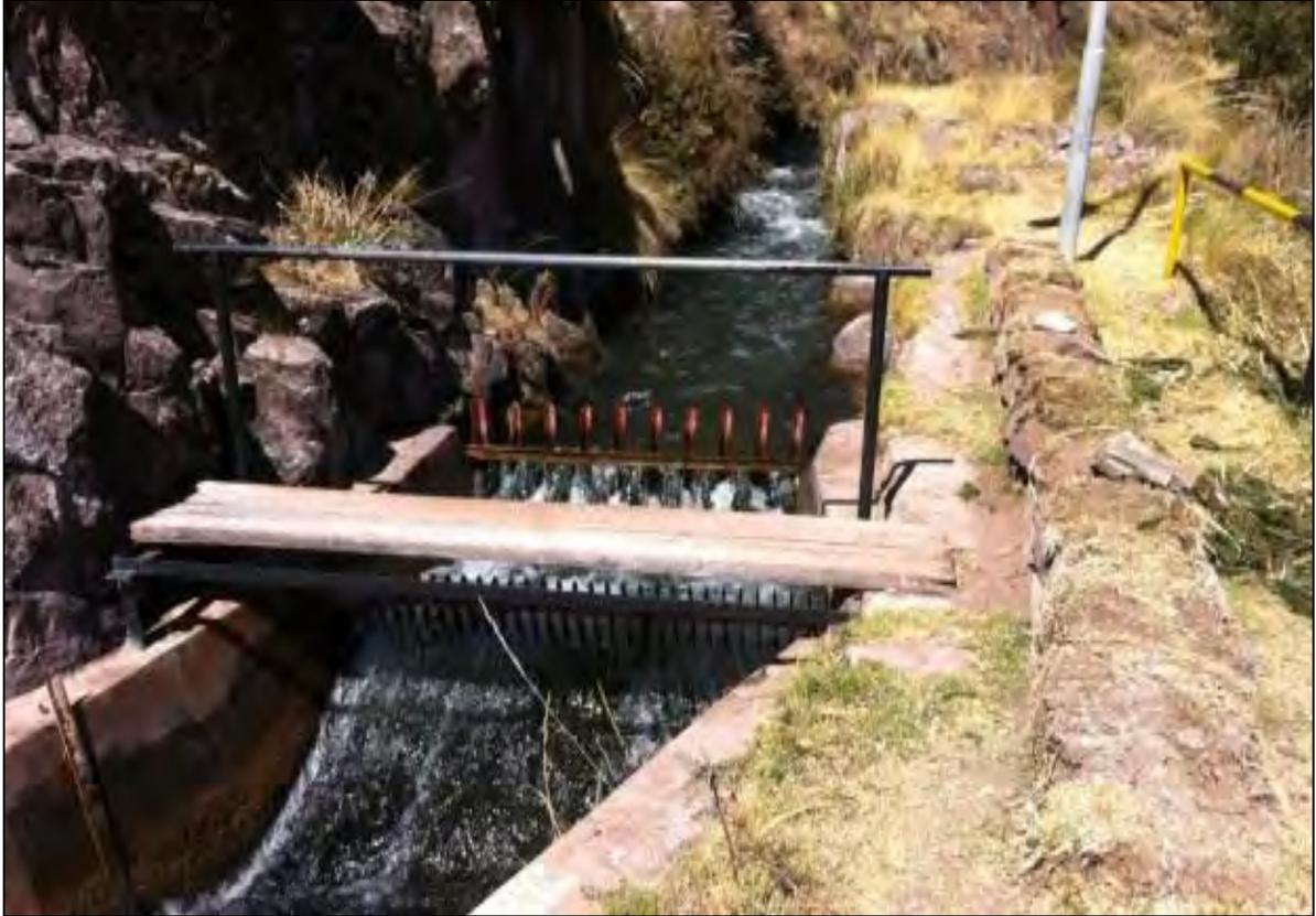
Figura 3.11: Las rejillas al inicio de la cámara de carga
