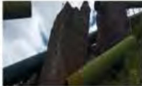
Progresiva 0+110 cambio de tubería de 7.20 m. Proceso de Corte y desmontaje de la tubería antigua
