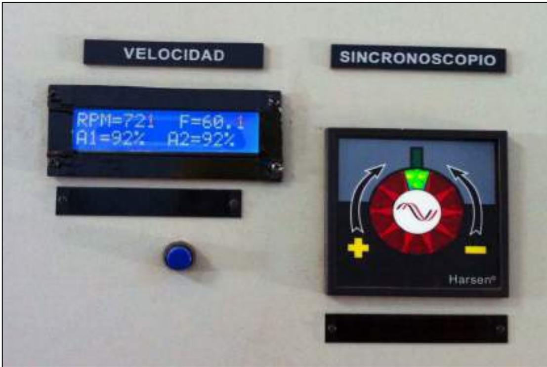
Figura 3.34: Tablero de señalización de la velocidad síncrona, la frecuencia y el Sincronoscopio digital.
