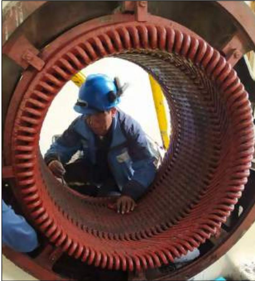
Figura 3.30: Estator de generador de la P.C.H. de Hercca, en proceso de mantenimiento
