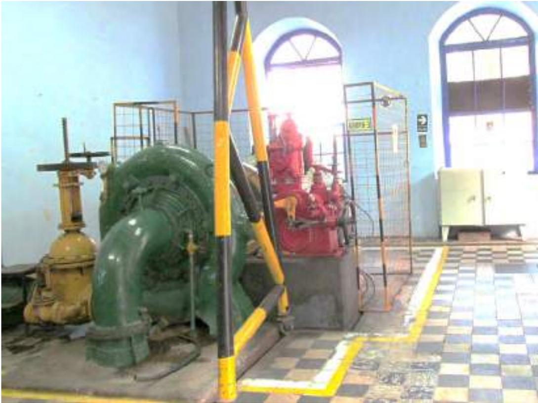
Figura 3.21: El grupo de generación III: La turbina Francis, el volante de inercia y el generador
