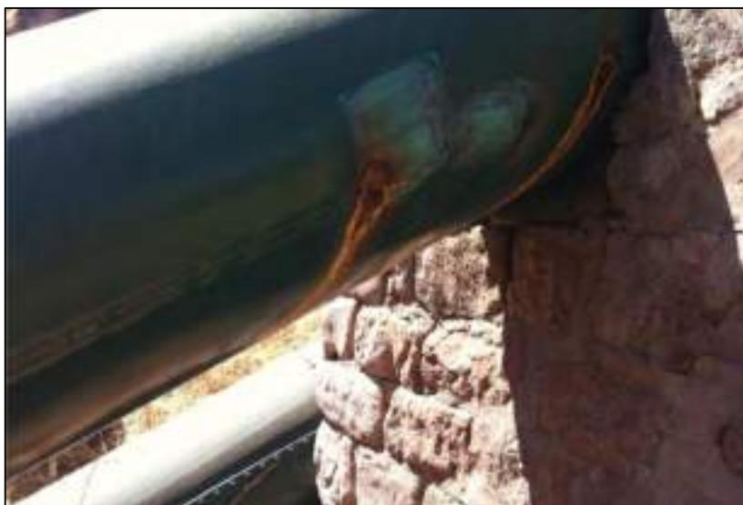
Figura 1.7: Problemas de corrosión en la tubería de presión
