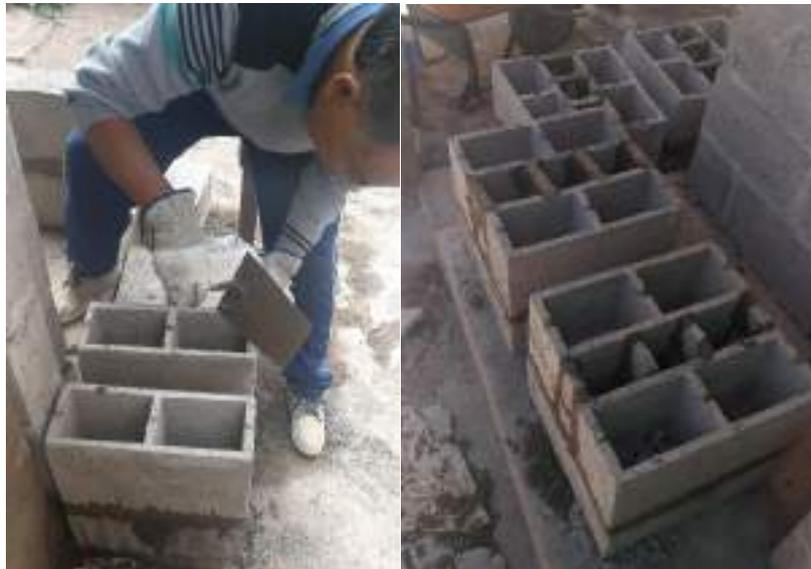
*Figura 55: Fabricación de módulos para ensayo de aislamiento térmico*
