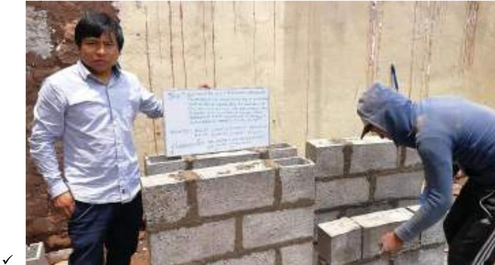
Figura 40 Elaboración de muretes de bloques huecos de concreto
