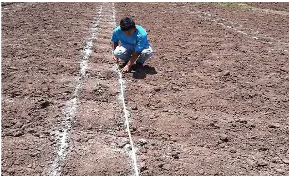
Fotografía 06.- Trazo y replanteo de bloques
