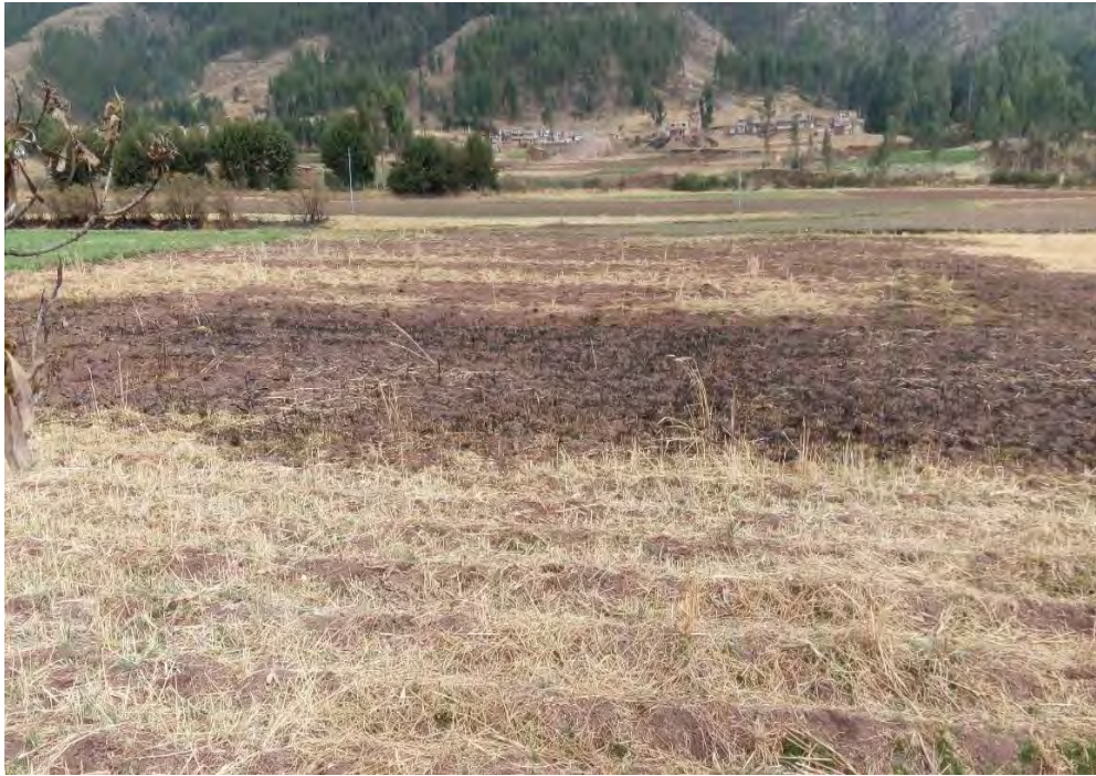
Fotografía 03.- Limpieza del terreno
