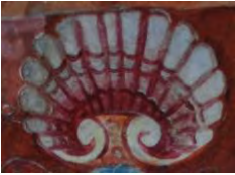
Imagen 40. Cocha marina de la cubierta de la sacristía. Fotografía propia
