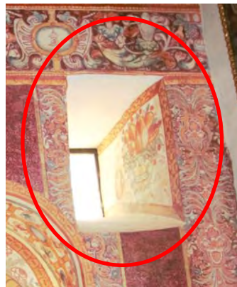
Imagen 29. Vano del muro izquierdo. Fotografía propia
