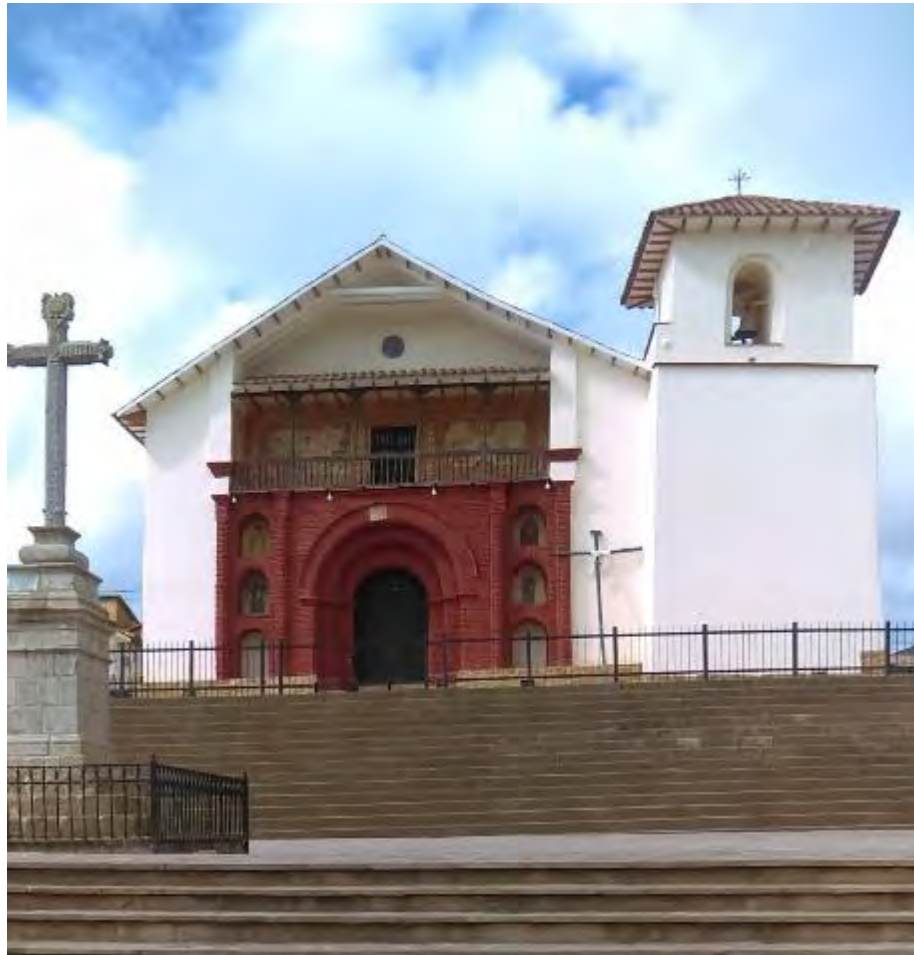
Imagen 1. Fachada del templo San Jerónimo de Colquepata. Fotografía propia.
