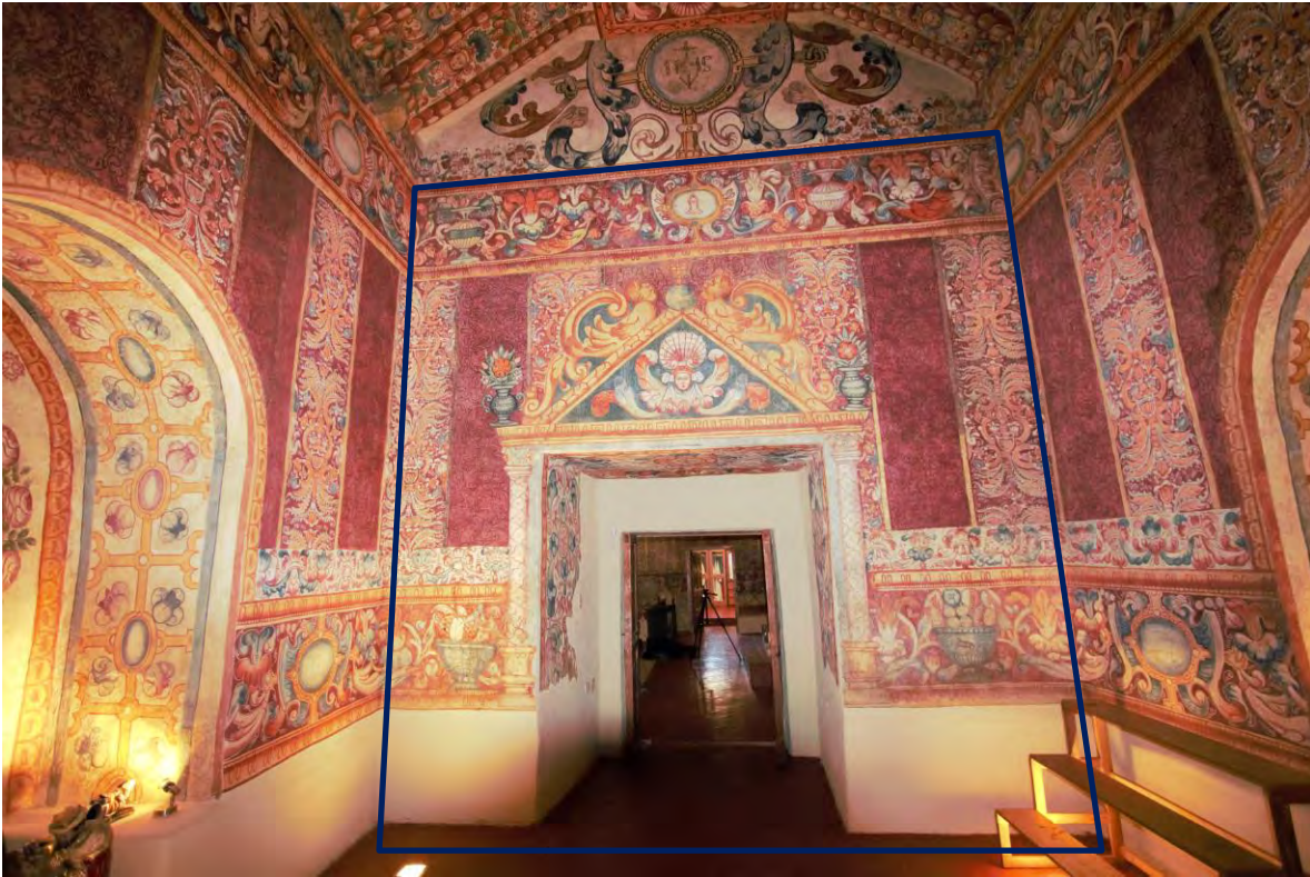
Imagen 109. Muro posterior o del este
