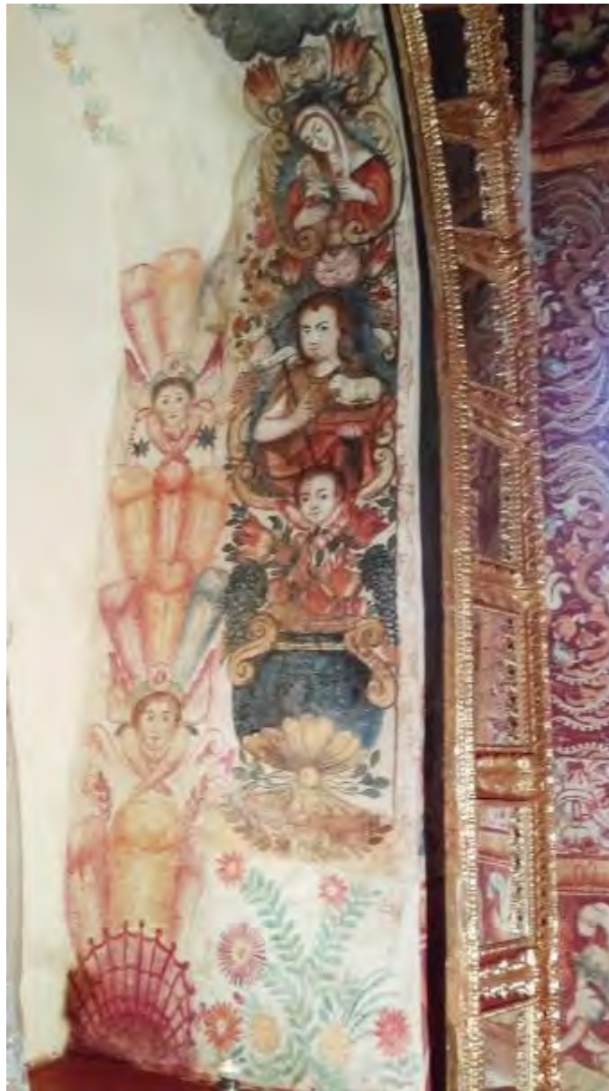
Imagen 60. Jamba derecha del muro frontal.
