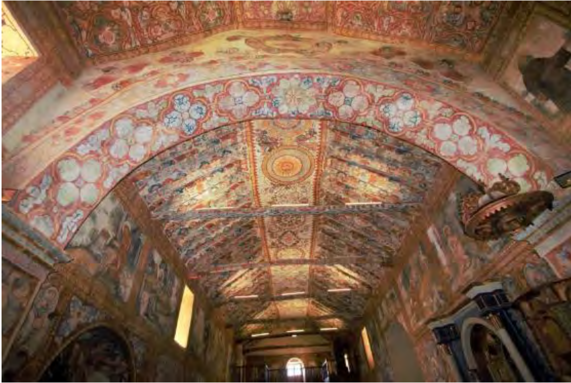
Imagen 14. Vista del arco toral y cubierta compuesta por hameruelo y faldones de la nave central. Fotografía propia
