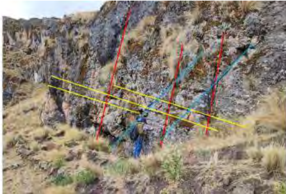
Fotografía N° 13: Vista de sistema de fracturamiento en macizo rocoso del grupo Mitu. FUENTE: Propia.
