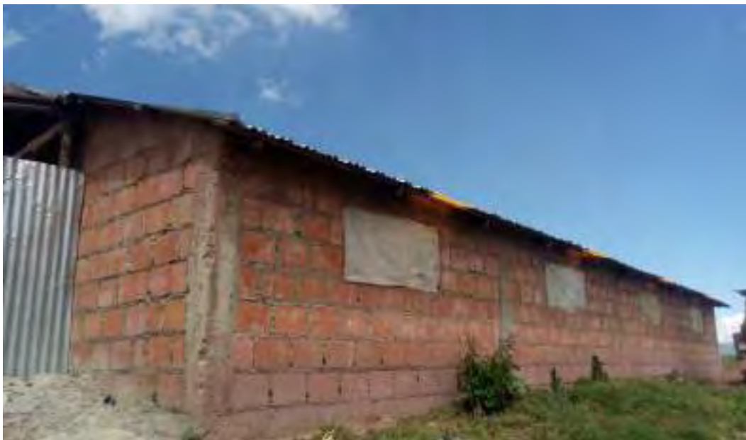
Figura 8 Vista externa del galpón
