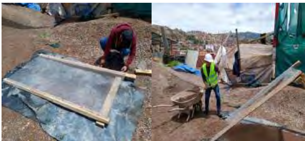
Figura 103. Construcción de la zaranda 3/8”, Zarandeo y Traslado del material a la zona de producción.
