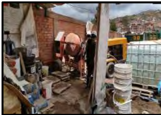
Figura 99. Vaciado de concreto hacia la tolva de la bomba TK-40.
