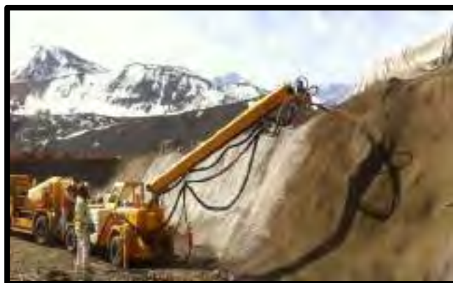
Figura 12. Aplicación de Concreto para estabilización de taludes
