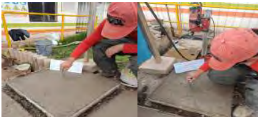
Figura 120. ensayo con penetrómetro pocket en panel cuadrado de shotcrete cada 30 minutos, cemento tipo HE
