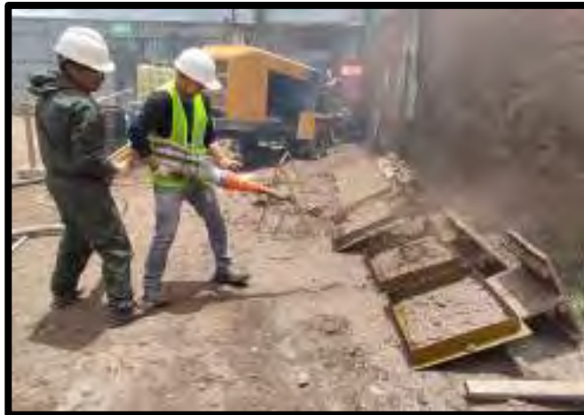
Figura 100. Proyección de la mezcla del concreto lanzado.
