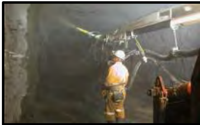
Figura 11. Aplicación de Concreto lanzado en minas
