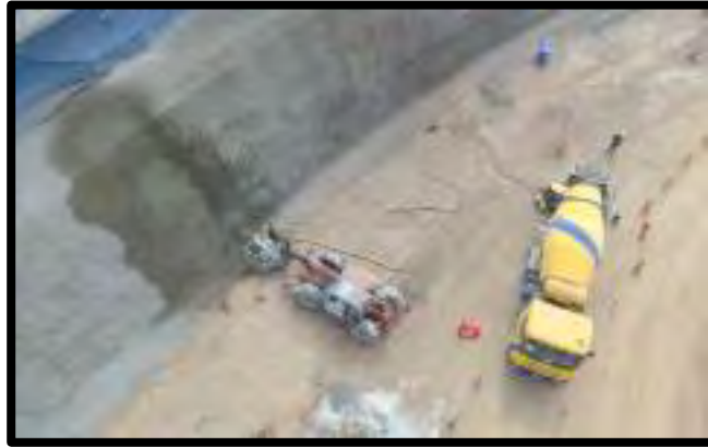
Figura 13. Aplicación de Concreto para reparación de elementos estructurales
