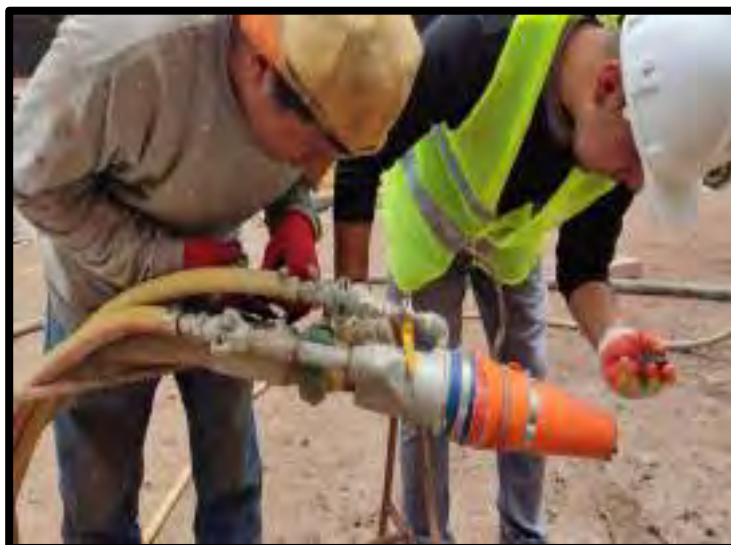
Figura 32. Boquilla marca Grove para tuberías de 2”
