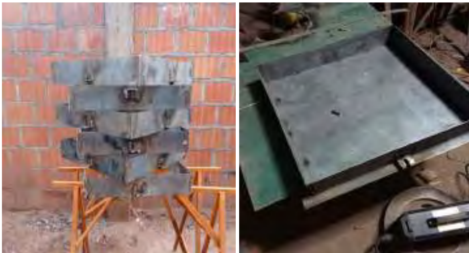
Figura 35. Preparación de moldes para elaboración de paneles.
