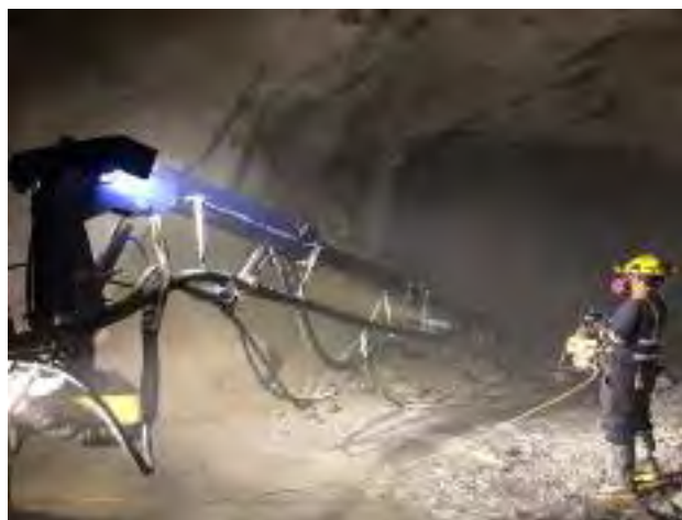
Figura 9. Equipos de aplicación robotizado de shotcrete seguros.
