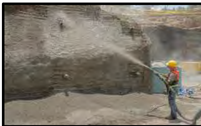
Figura 10. Aplicación de Concreto lanzado asentamiento de taludes.
