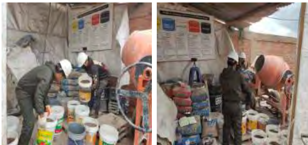
Figura 97. Vertido de los materiales hacia la mezcladora.
