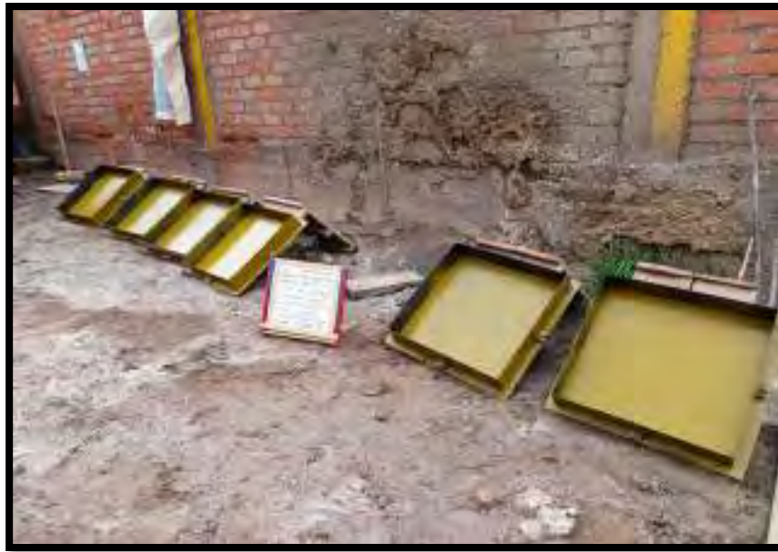
Figura 38. 06 moldes para elaboración de paneles.
