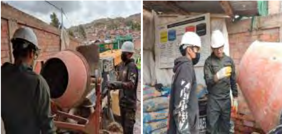
Figura 98. Verificación de la mezcla del concreto.
