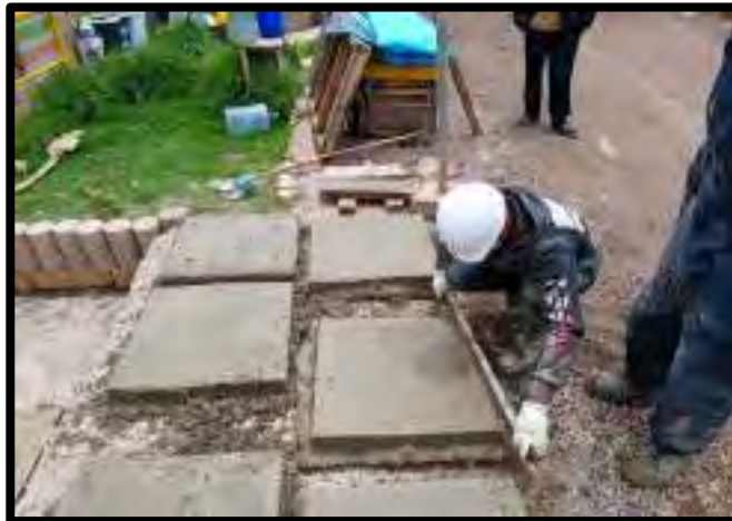
Figura 101. Nivelado de la mezcla del concreto en cada panel.
