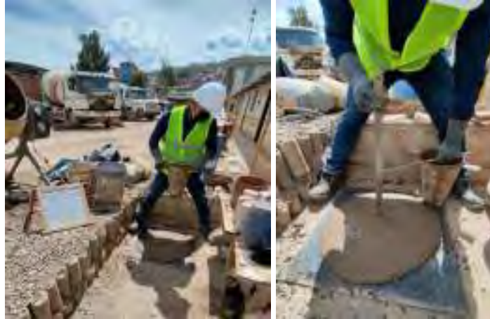
Figura 78. Medición de asentamiento de mezcla.
