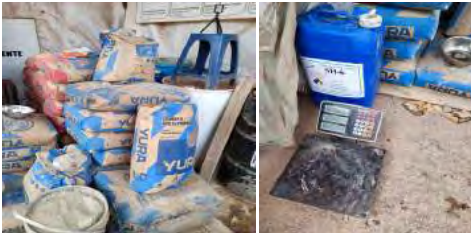
Figura 96. Pesaje del cemento y del aditivo superplastificante.
