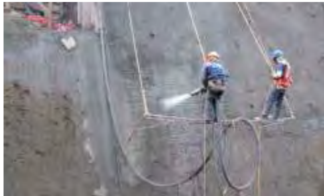
Figura 5. Bombeo de Shotcrete a gran altura.
