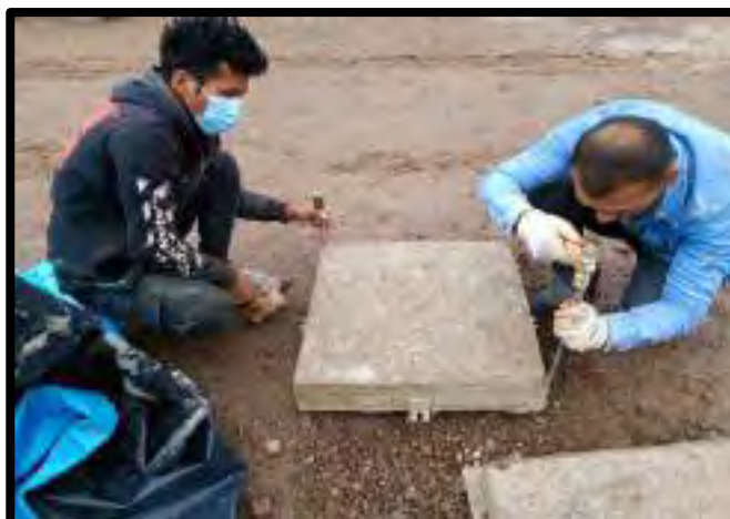
Figura 102. Desencofrado de paneles proyectados.
