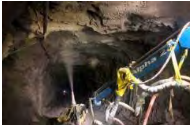
Figura 7. Proyección en socavón, difícil acceso.
