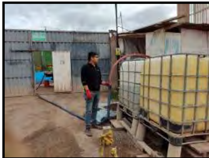
Figura 109. Llenado y traslado de tanques de 1m 3 de agua.
