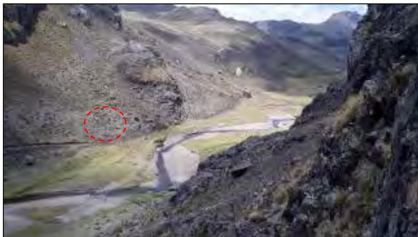
Foto N°6.1: Identificación de zonas de derrumbe de roca en la margen derecha del vaso.
