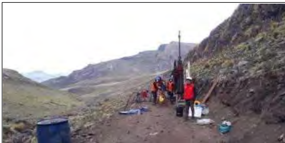
Foto N° 8.41: Imagen panorámica del sondeo-02, ubicado margen derecho del río.
