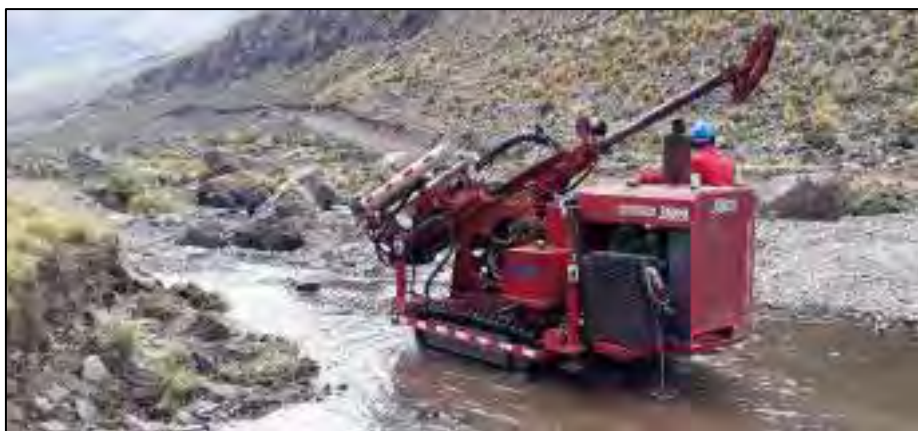
Foto N° 8.34: donde muestra el traslado a nuevo punto, movilizándose con su oruga que esta acoplada ala perforadora Explorer SAT 140, octubre 2018.
