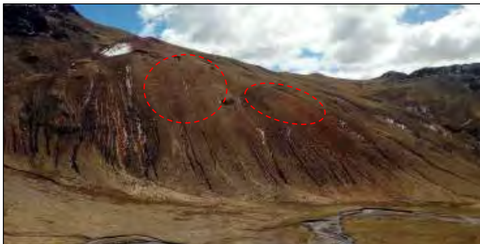
Foto N° 6.9: Ubicación de las zonas de erosión laminar severa, ubicada en la margen izquierda del vaso de la presa.
