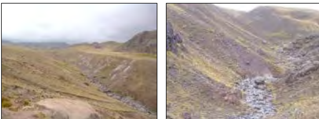
Foto N° 6.5 y 6.6: Vistas de los derrumbes en proceso de estabilización de las laderas de ambas márgenes del río Palljahuayco
