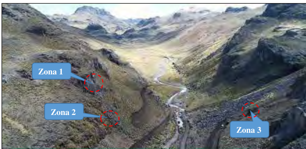
Foto N° 4.2: Ubicación de las zonas de toma de datos estructurales.
