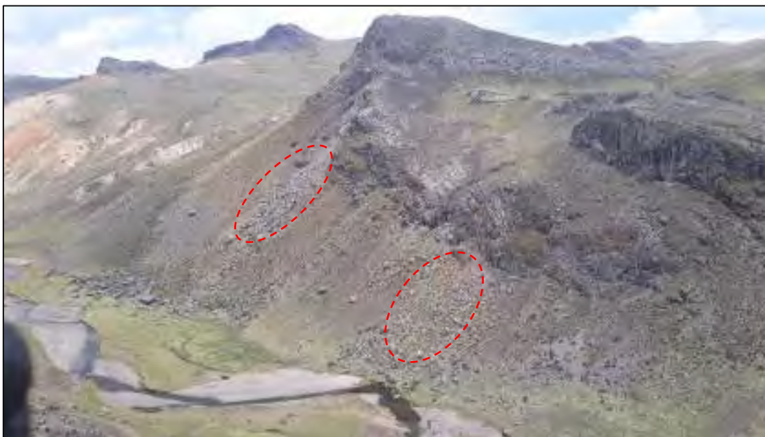
Foto N° 6.2: Identificación de zonas de derrumbe de roca en la margen izquierda del vaso.
