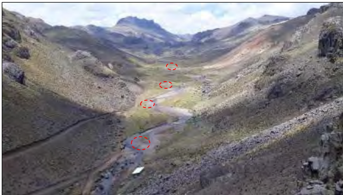
Foto N° 2.12: Vista panorámica de la cuenca Husillo con la ubicación de las zonas llanas.
