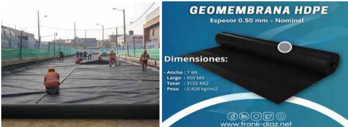
Nota: IZQUIERDA: Instalación de una geomembrana tipo HDPE, en una pavimentación (Fuente: Pavco wavin - Geosinteticos), DERECHA: Detalles de la geomembrana tipo HDPE. (Fuente: www.frank-diaz.net)
