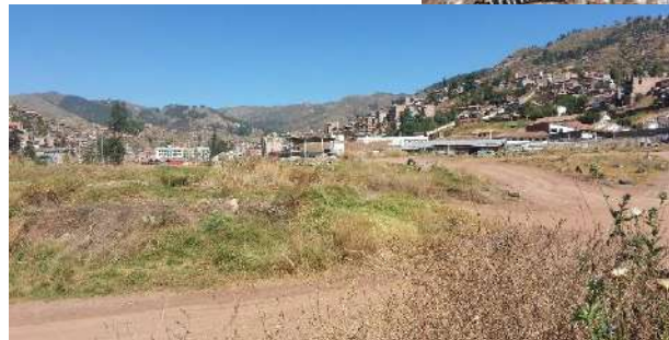
VISTA HACIA LA APV. MANAHUAÑUNCCA Y EL COLEGIO SAN JOSE OBRERO
