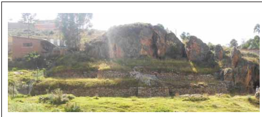
Figura 31. Vista posterior de la Huaca Ccoheccarana, véase los muros de contención alrededor de la roca labrada.
