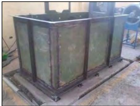
Figura 5.6: Angulares de refuerzo en reservorio
