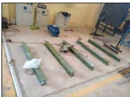
Figura 7.2: Vigas base de reservorio rectangular
