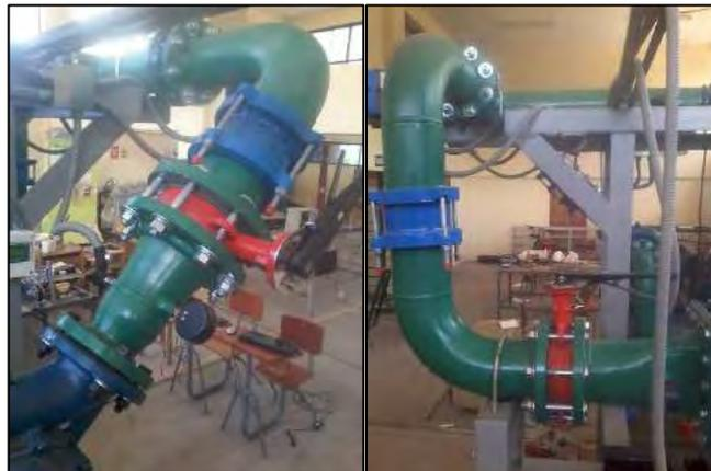
Figura 4.19 Tramos de tubería hacia cada turbina
