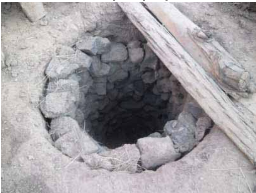
Foto N°2. Construcción del pozo séptico para una vivienda
