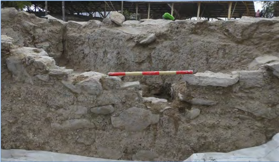
Figura 36 Faltantes de muro.
