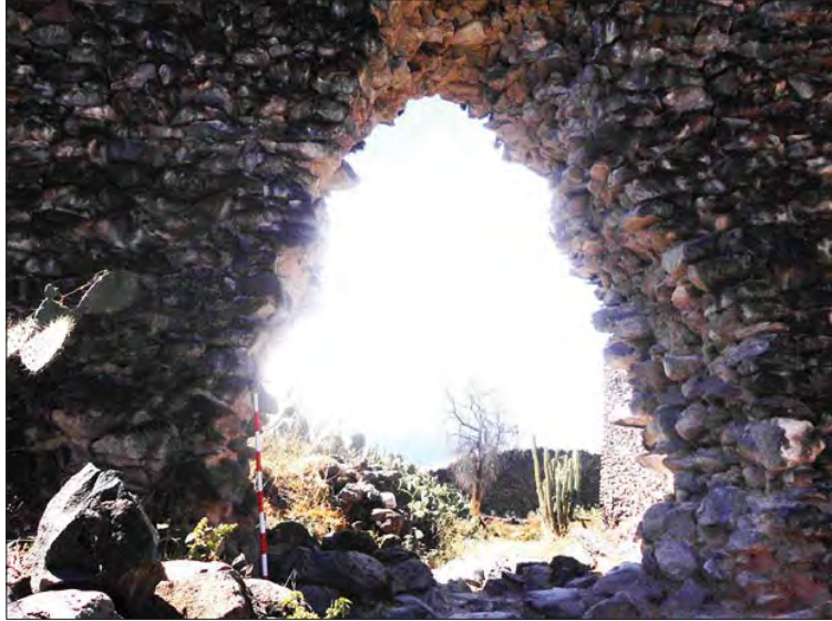
Foto del estado actual del muro
