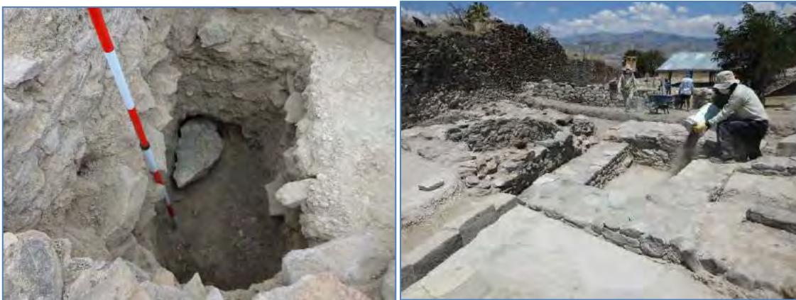
Figura 27 Perspectiva de faltante de piso con piedra que tapaba la entrada al canal, (a) llenado de faltante de piso (b).
